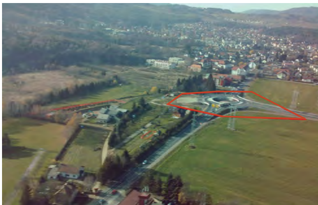
5 Pogled iz zraka proti jugozahodu na cestno krožišče v Radvanju, kjer je bilo v letih 2007 in 2008 raziskano arheološko najdišče (fotografija: A. Gulič). Južno od Lackove ceste je vidna ograjena gradbena jama stanovanjskega objekta podjetja AJM (uničen del arheološkega najdišča).
