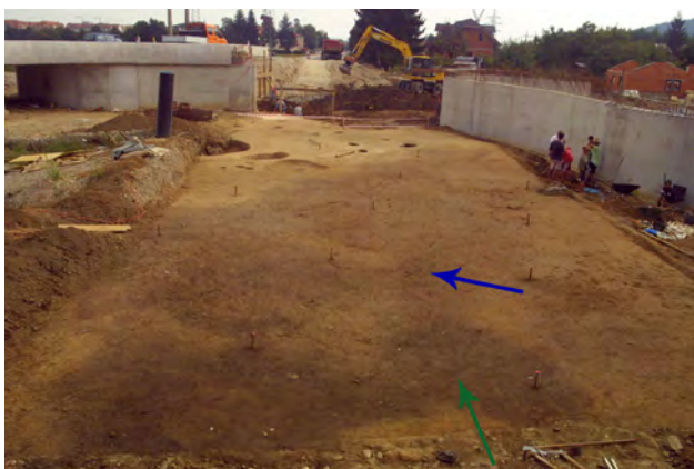
28 Naplavinska plast SE 1404 (modra puščica) nad objekti 17–18 in 20 v sek. 4–6 pred izkopavanjem. V ospredju jami SE 1268/1269 in SE 1406/1407 = SE 1418/1419, ki ju naplavina ni prekrivala (zelena puščica). Pogled z zahoda.
