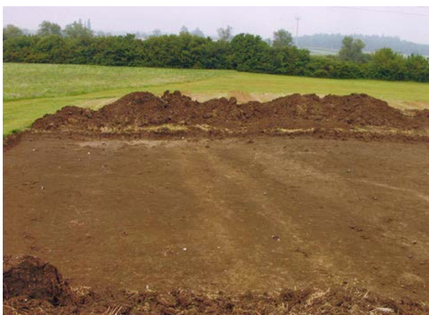
53 Pogled na drenažne jarke v južnem delu sektorja G.
