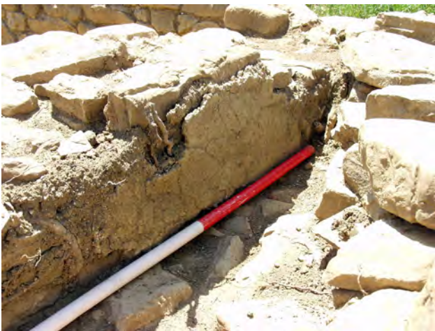
147 Zunanja stena term na zahodno dvorišče – zid SE 104. Omet SE 117 in tlakovanje SE 116.
