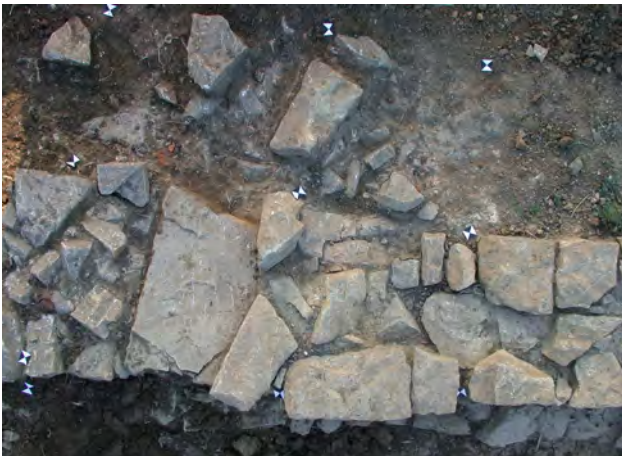
170 Izpust v zidu SE 560.
