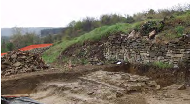
20 Zidovi na moderni terasi 2 so bili izjemno uničeni, saj so se nahajali pod tanko plastjo ornice.
