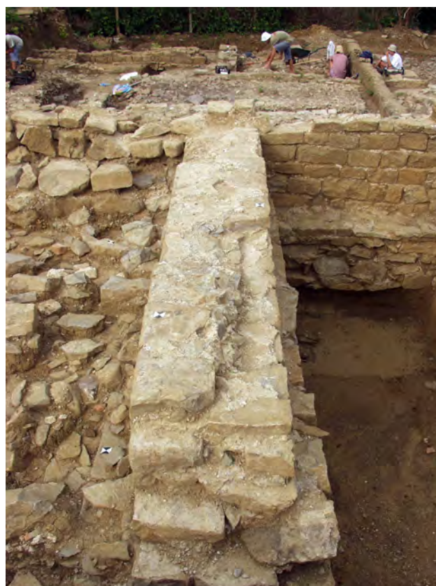
24 Postopna gradnja z obilico maltnega veziva med vrstami kamnov. Zid SE 328 – gospodarsko poslopje 1. faza. Pogled proti jugozahodu.
