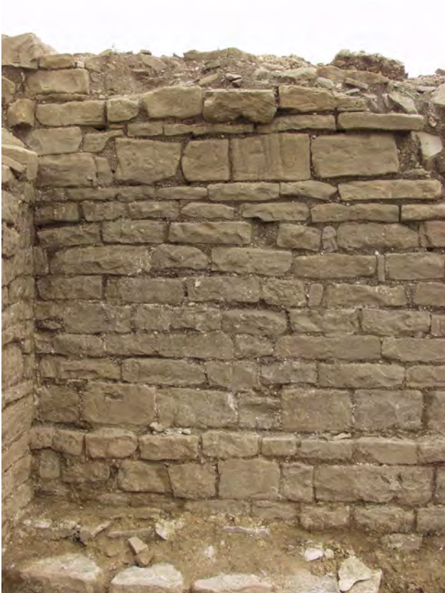
25b Skrbno postavljene vrste kamnov v severozahodnem licu zidu SE 363 v skladišču.
