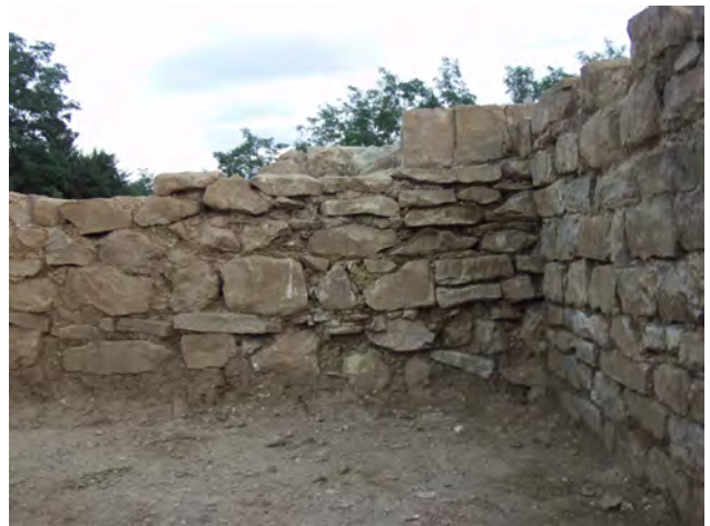
30d Severozahodno lice zidu SE 229 v prostoru F na rimskem nivoju 4.
