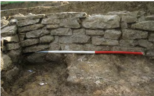
172 Kamniti plošči SE 176 z ostanki SE 175.
