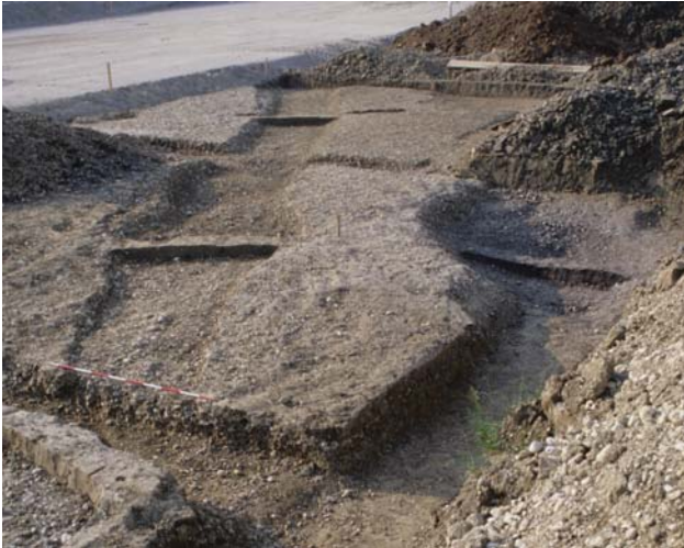
35 Pogled na cesto s severozahoda.
