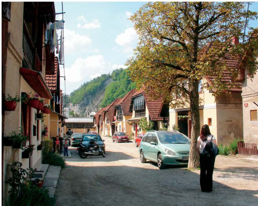
Trbovlje, občinska kolonija pred prenovo (foto: T. Hohnec)
