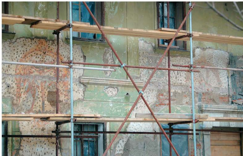
Cerklje, hiša Krvavška 1, sondiranje fasade (foto: E. Tršar Andlovic)
