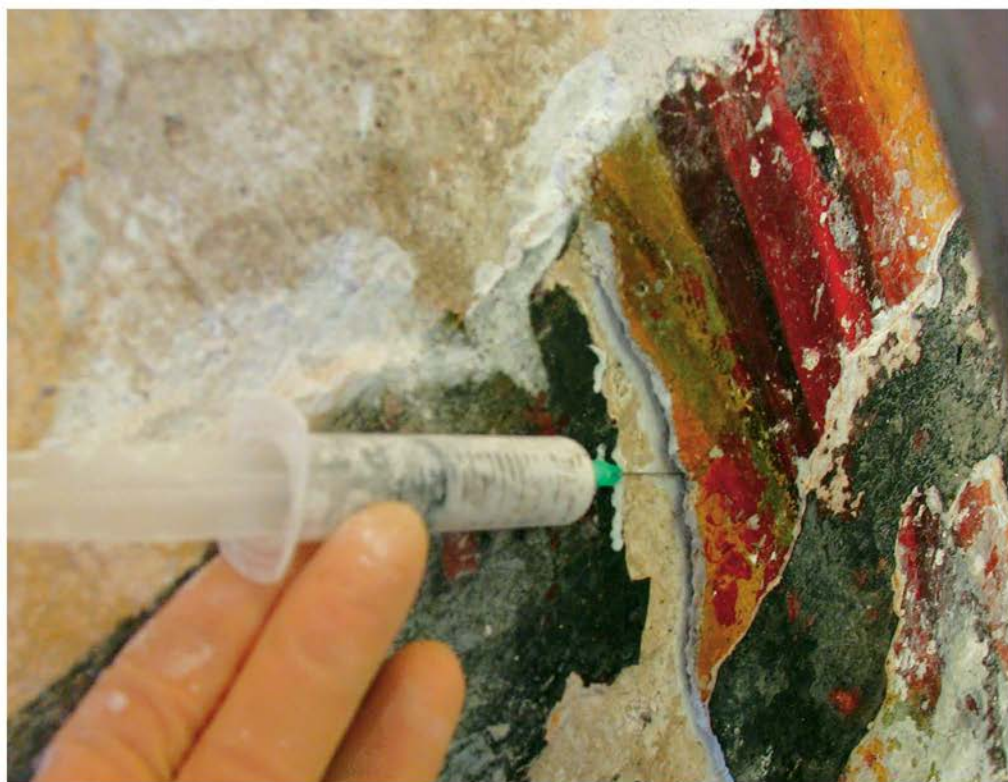
Mikroinjektiranje (foto: A. Klančar Kavčič)
