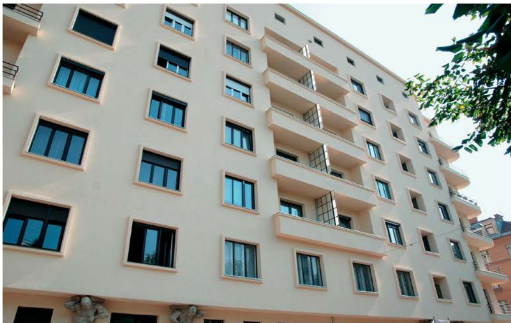
Detajl ulične fasada po obnovi (foto: M. Režek Kambič, 2009)
