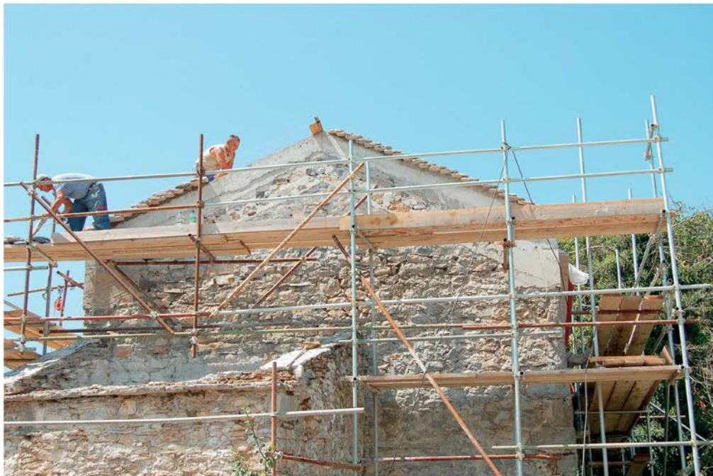
Zidanje skrlatega zatrepa V-fasade nekdanjega hrama (foto: E. Belingar, 2009)
