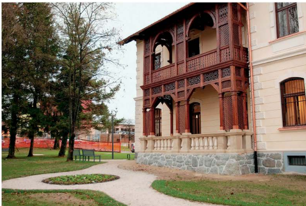
Šoštanj, vila Mayer, obnovljen altan (foto: U. Kerbavec, 2009)
