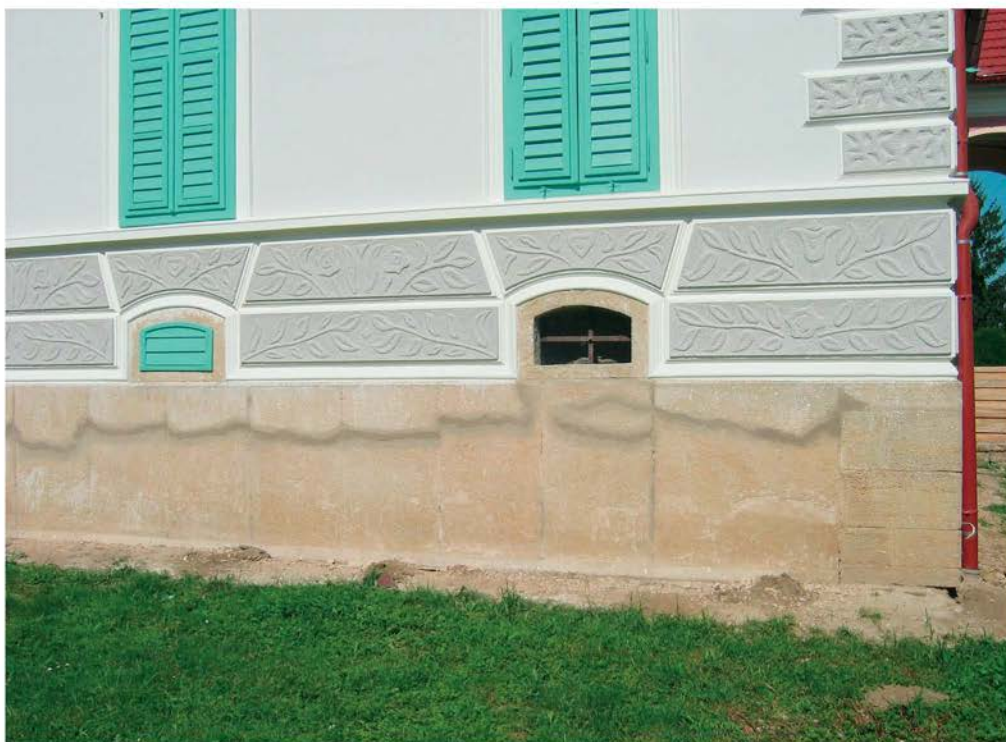
Obnovljeni temeljni zidec, julij 2009 (foto: S. Vešligaj)
