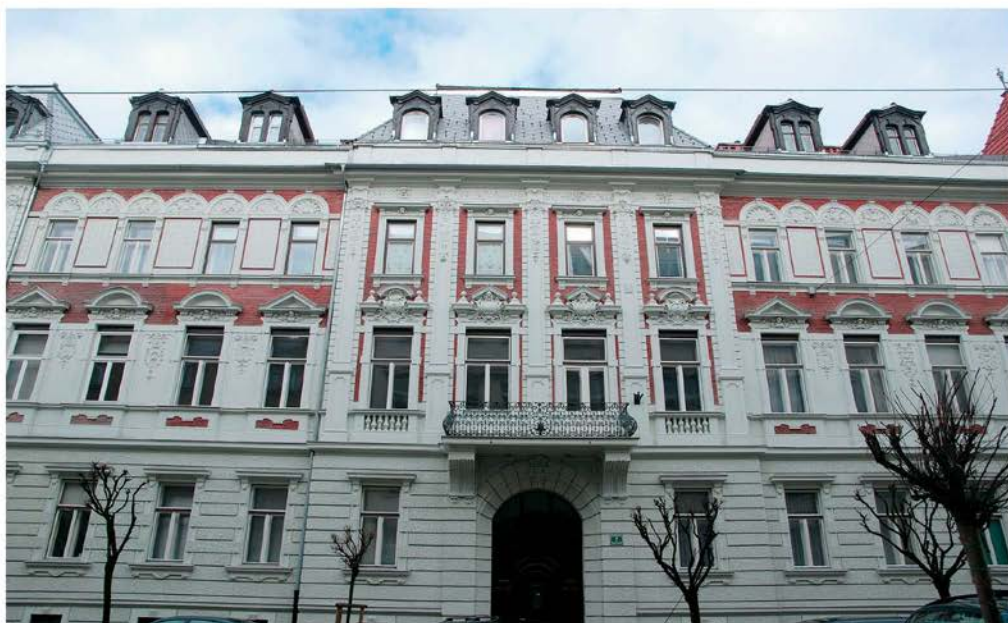
Balkon na hiši Prešernova 5 po obnovi (foto: M. Režek Kambič, 2009)
