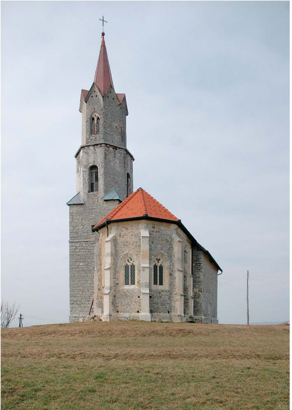
Okrog pri Šentrupertu, cerkev z vzhodne strani pred prenovo (foto: R. Peskar)
