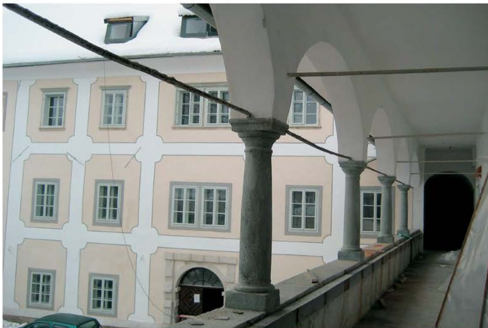
Pogled na obnovljeno fasado in stranski trakt gradu Kieselstein brez zasteklitve (foto: N. Leben, 2009, Arhiv ZVKDS, OE Kranj)
