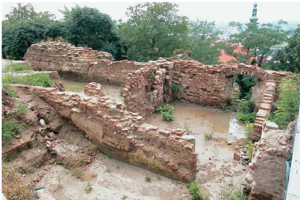
Lendava, porušeni del obzidju in obzidje s topovsko lino, ki so bili predvideni za prezentacijo (foto: N. Sulič Urek)
