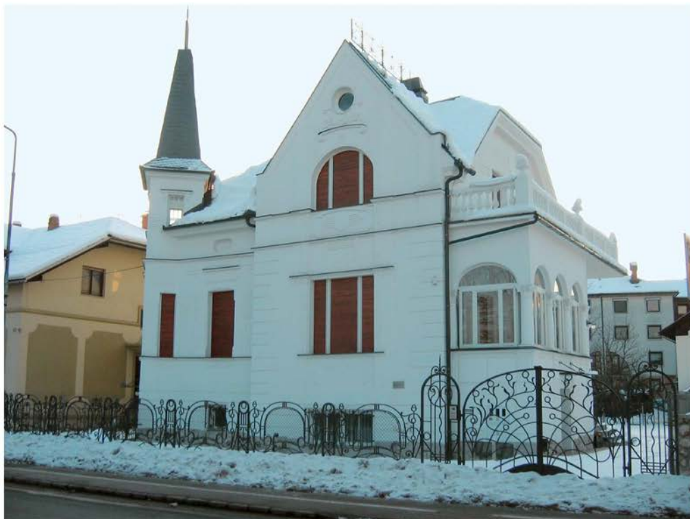
Radovljica, vila po prenovi (foto: N. Leben, 2009, Arhiv ZVKDS, OE Kranj)
