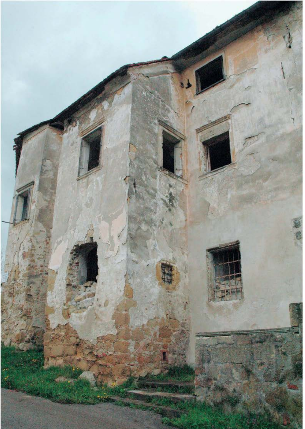
Polzela, grad Komenda, vzhodna fasada pred prenovo (foto: I. Gričar, 2008)
