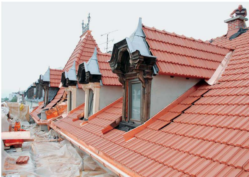
Streha hiše Prešernova 11 v Ljubljani med obnovo (foto: M. Režek Kambič, 2008)
