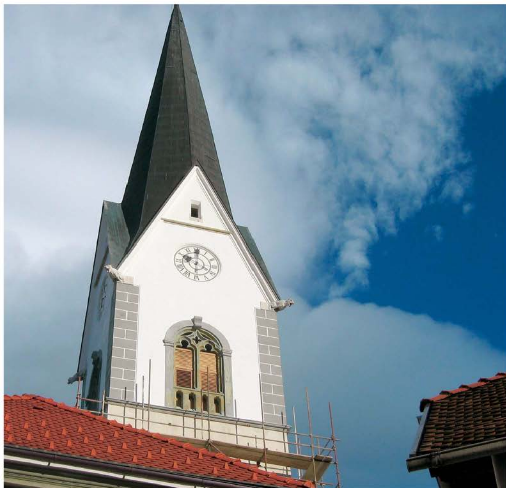
Radovljica, cerkev sv. Petra, obnovljeni zgornji del zvonika (foto: N. Leben, 2009, Arhiv ZVKDS, OE Kranj)
