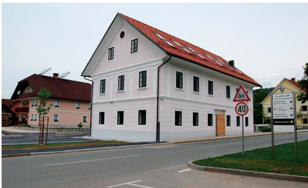
Cerklje, hiša Krvavška 1 po obnovi (foto: M. Tercelj Otorepec)
