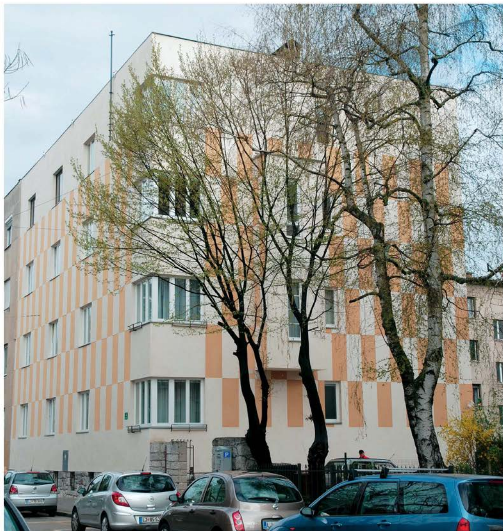
Ljubljana, stanovanjski blok Šahovnica po prenovi (foto: M. Režek Kambič, 2009)
