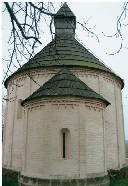
Pogled na rotundo pred obnovo strehe (foto: N. Sulič Urek)
