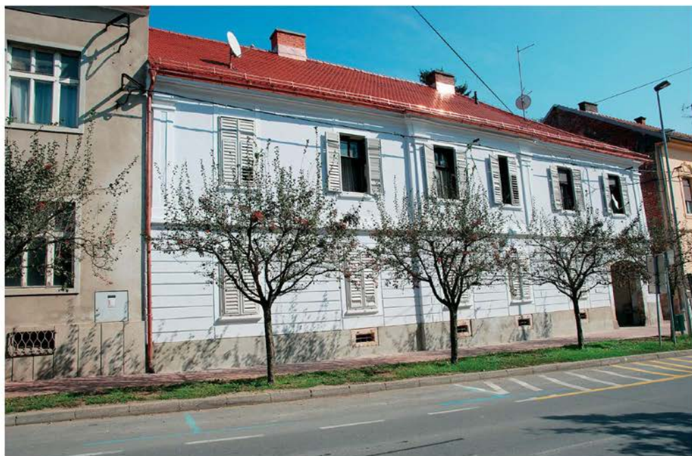
Lendava, hiša Partizanska 20, fasada po obnovi (foto: N. Sulič Urek)
