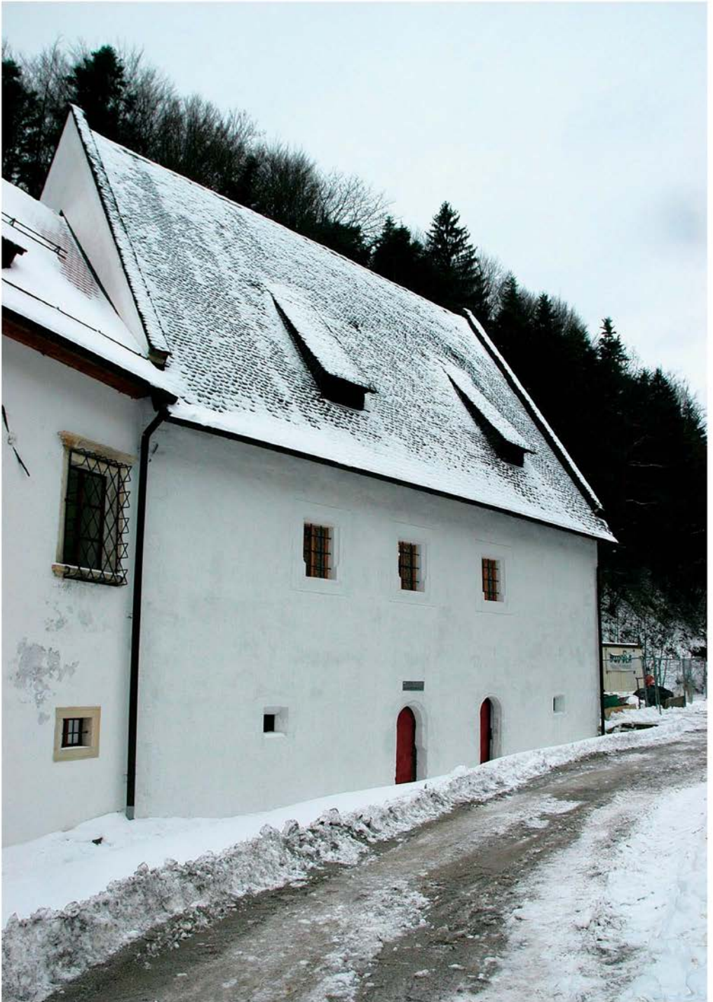
Zgornje Siemene, severna fasada Gotske hiše po prenovi (foto: B. Badovinac, 2009)
