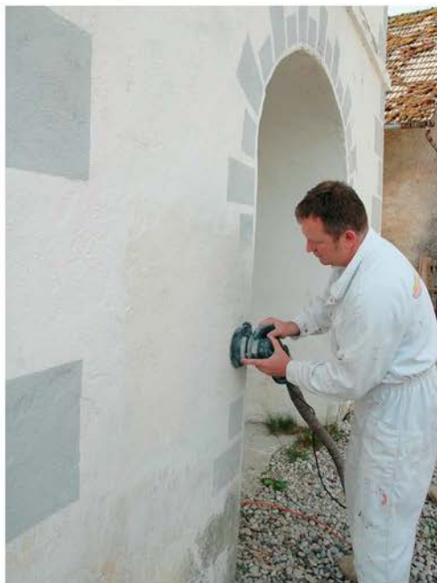
Za omet neškodljivo strojno odstranjevanje recentnih beležev (foto: T. Golob, 2009, Arhiv ZVKDS, OE Novo mesto)
