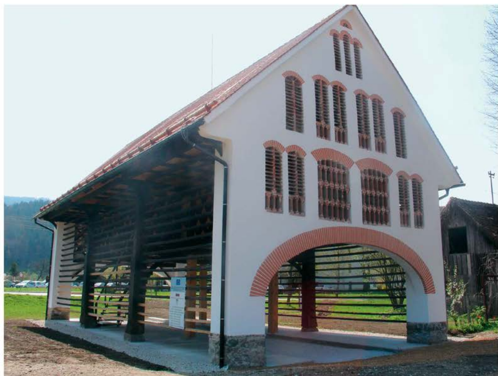
Bohačev toplar po obnovi (foto: T. Hohnec)
