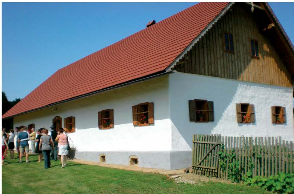
Hiša Grafonžove domačije v Zgornji Ščavnici, po obnovi (foto: J. Skalicky, 2009)
