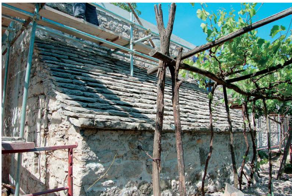
Na novo izvedena skrlata streha ledenice ob nekdanjem hlevu (foto: E. Belingar, 2009)
