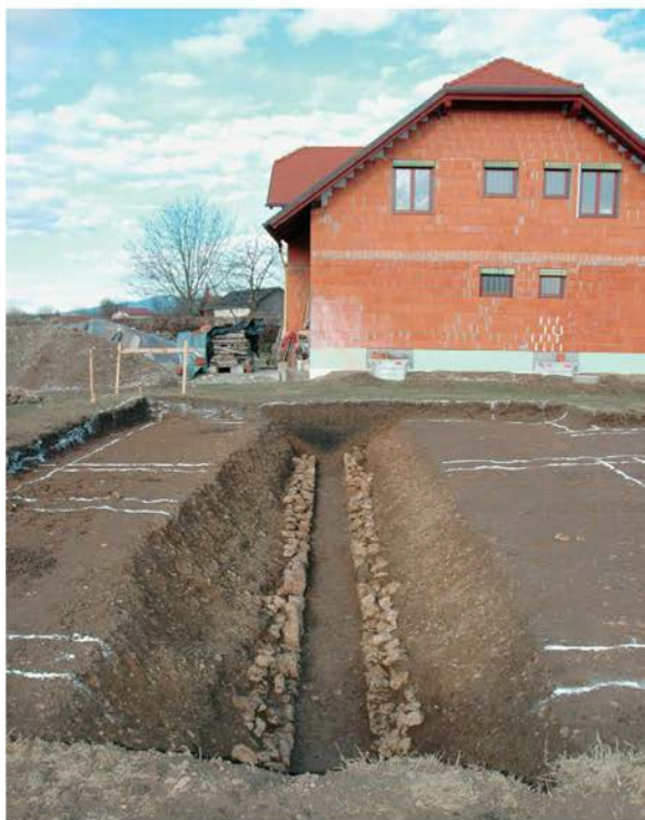
Kungota pri Ptuj, parc. št. 657/13, k. o. Gerečja vas, 2009, ostaline rimskodobnega vodovodnega kanala, z vzhoda (foto: D. Belič)
