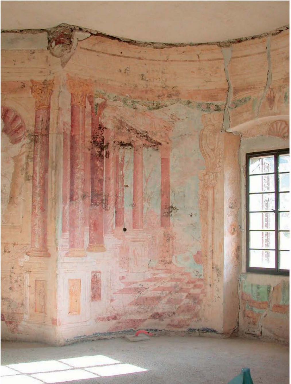
Soteska ob Krki, vrtni paviljon Hudičev turn, stanje po odstranitvi opleskov (foto: T. Mesojedec)
