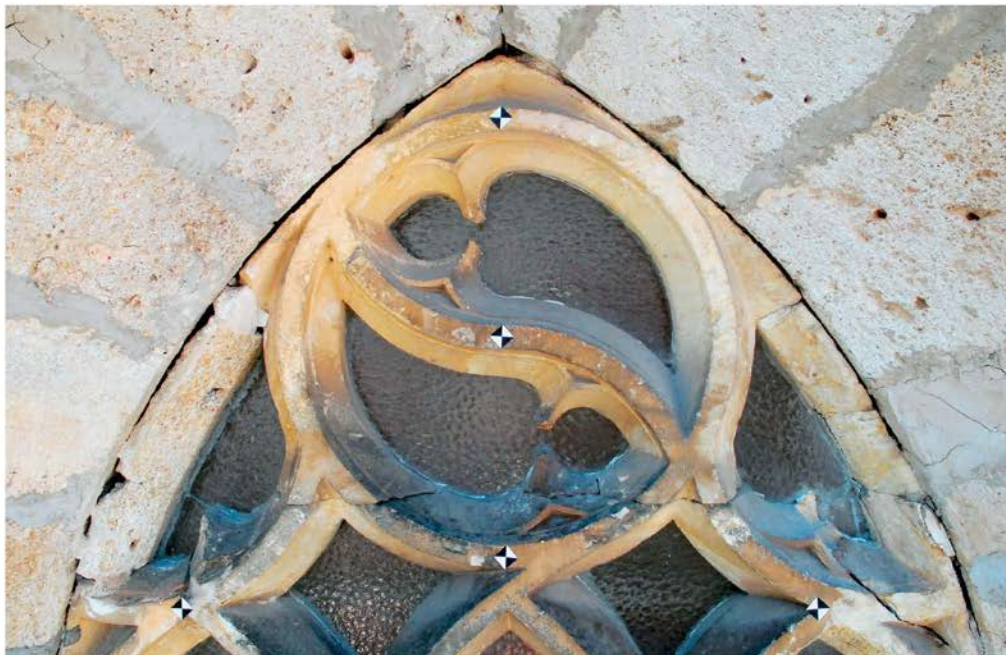
Krogovičevje obeh oken smo izmerili s pomočjo oznak (markerjev); ti so na fotografiji in risbi omogočili uskladitev merskih podatkov (foto: J. Grobovšek).
