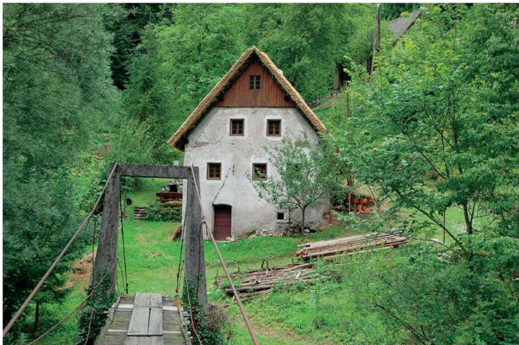
Obnovljena slamnata streha pri Pušiču v Dolenji Trebuši (foto: A. Ščukovt, 2009)
