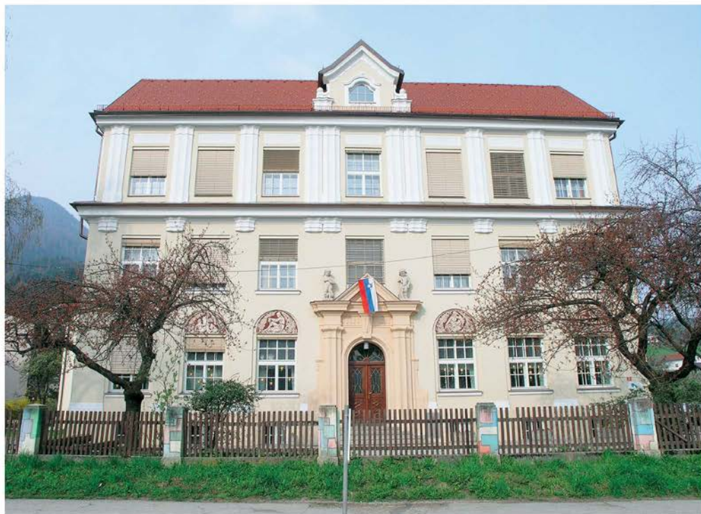
Mežica, šola, ulična fasada po obnovi (foto: S. Kurelac)
