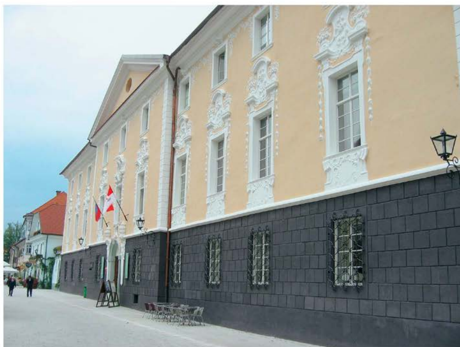
Pogled na obnovljeno fasado radovljiškega gradu (foto: N. Leben, 2009, Arhiv ZVKDS, OE Kranj)
