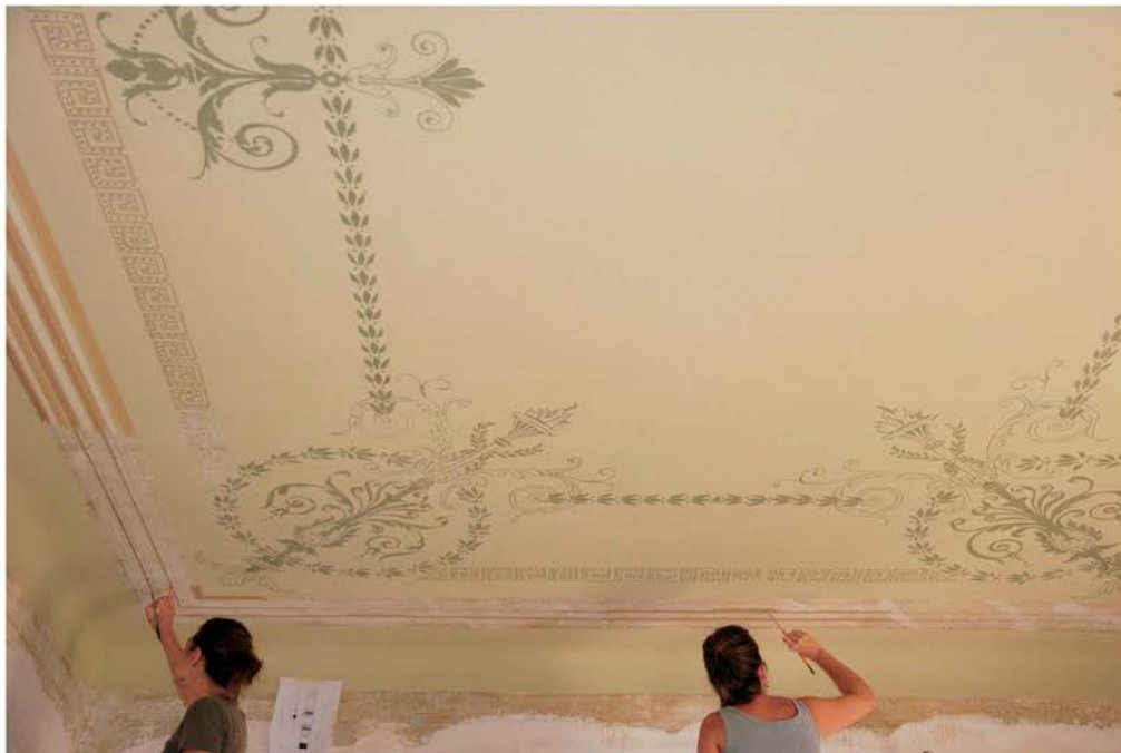
Šoštanj, vila Mayer, restavriranje stropne poslikave (foto: U. Kerbavec, 2009)
