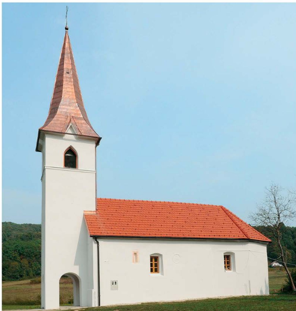
Mrzlava vas, pogled na cerkev z južne strani po obnovi fasade (foto: R. Peskar)
