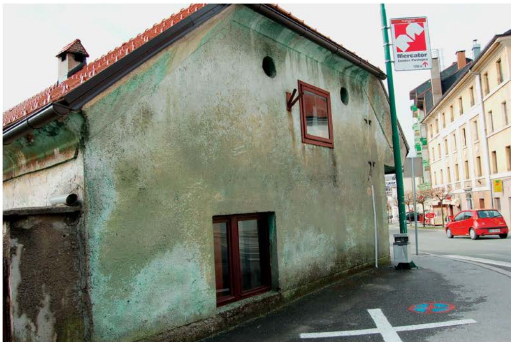
Postojna, domačija Ljubljanska 20, obcestna fasada kaže zanemarjen videz, ometi so dotrajani (foto: E. Belingar, 2009).
