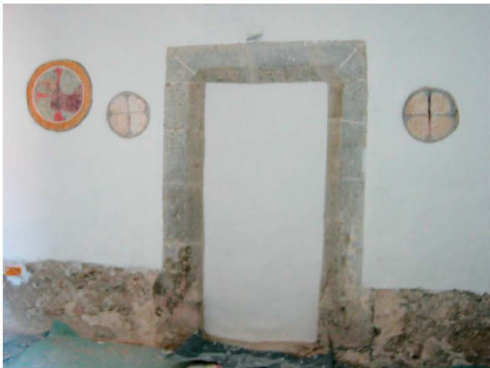
Vuzenica, cerkev sv. Nikolaja, posvetilni križi pod korom na južni in zahodni ladijski steni ter dostop na kor po posegu (foto: N. Nahtigal)
