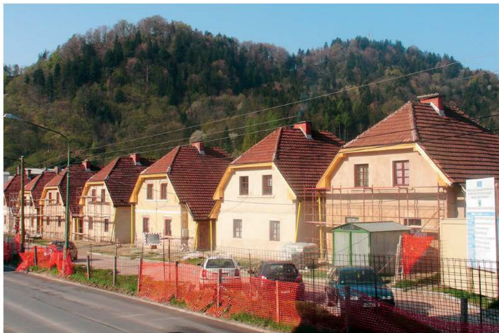
Trbovlje, občinska kolonija med prenovo (foto: T. Hohnec)
