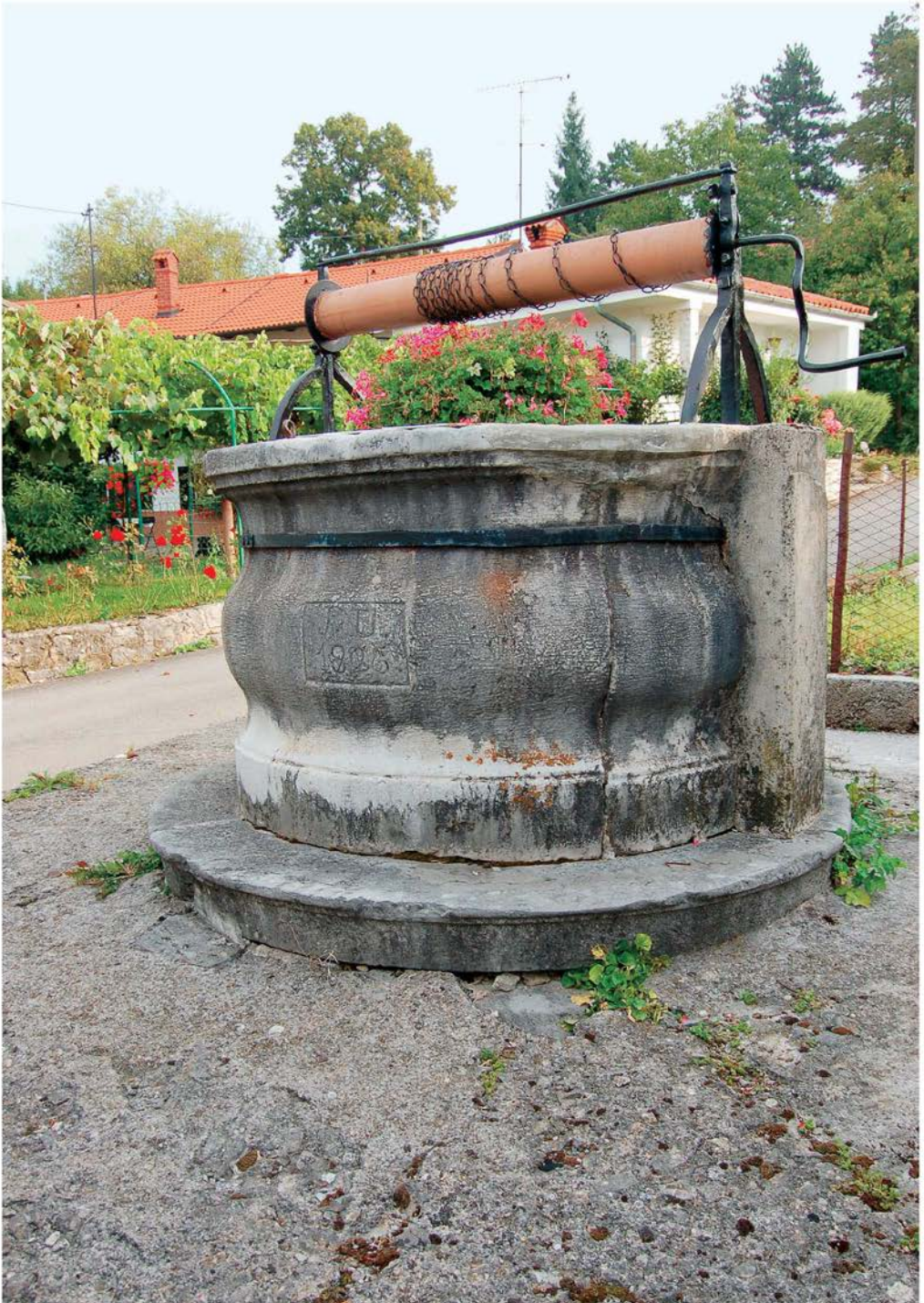
Zavrhek, komunski vodnjak pred izvedbo obnovitvenih del (foto: E. Belingar, 2009)
