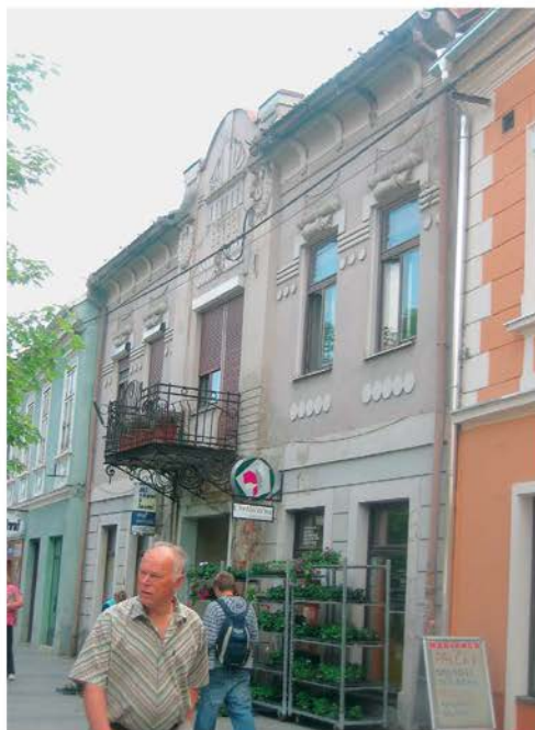
Slovenj Gradec, hiša Glavni trg 13, ulična fasada pred obnovo (foto: S. Kurelac)
