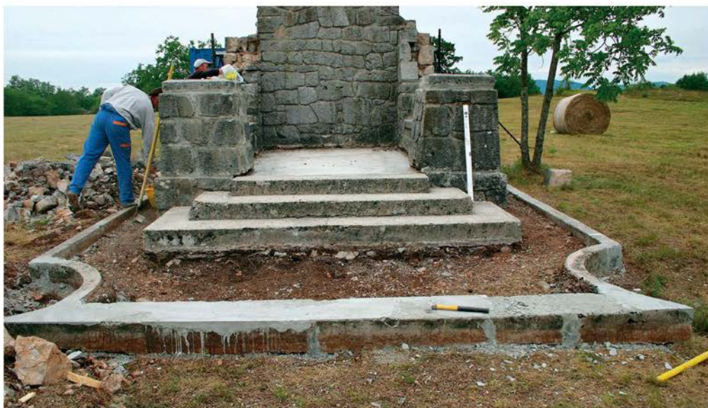
Obnovitvena dela, junij 2009 (foto: E. Drole, 2009)
