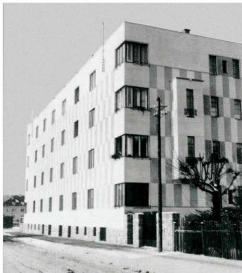
Pogled na stanovanjski blok Šahovnica okoli leta 1931 (vir: B. Zupančič, Arhitekt Josip Costaperaria in ljubljansko moderno meščanstvo, stran 75)
