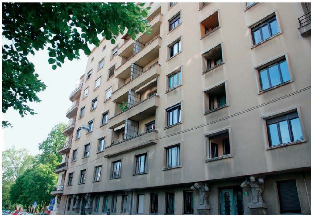
Ljubljana, Dukičevi bloki, ulična fasada pred obnovo (foto: M. Režek Kambič, 2009)
