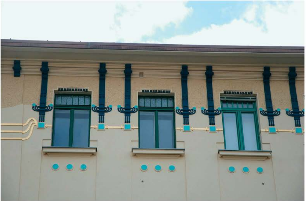
Detajl ulične fasada po obnovi (foto: M. Režek Kambič, 2009)
