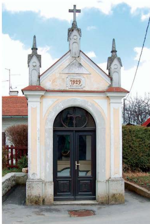
Koče pri Prestranku, kapelica pred obnovitvenimi deli (foto: E. Belingar, 2008)
