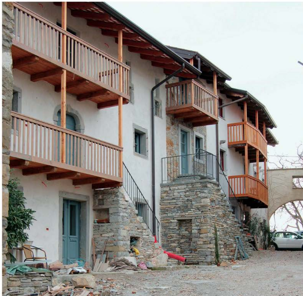
Celovito obnovljena domačija pri Adamovih v Kozani (foto: A. Ščukovt, 2010)
