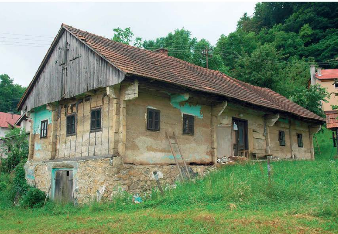
Brezovica na Bizeljskem, stanje fasad pred sondiranjem (foto: D. Strgar)
