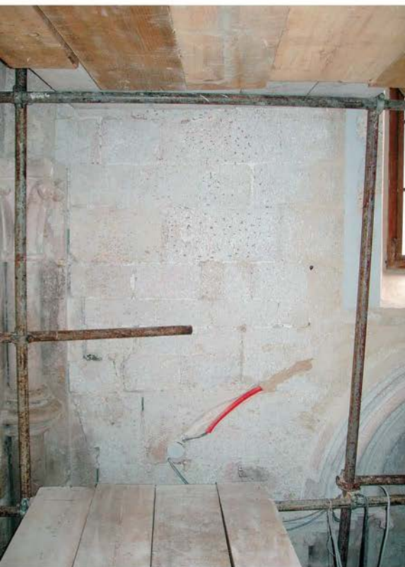
Južna stena prezbiterija z vklesano kineto za električni vod (foto: B. Badovinac)
