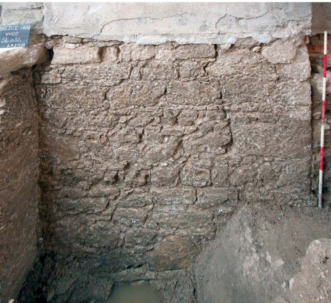
Pravilno in kvalitetno grajeni zidovi iz večjih, delno klesanih kamnov na vhodu v grad Brežice, 16. stoletje (foto S. Olič)
