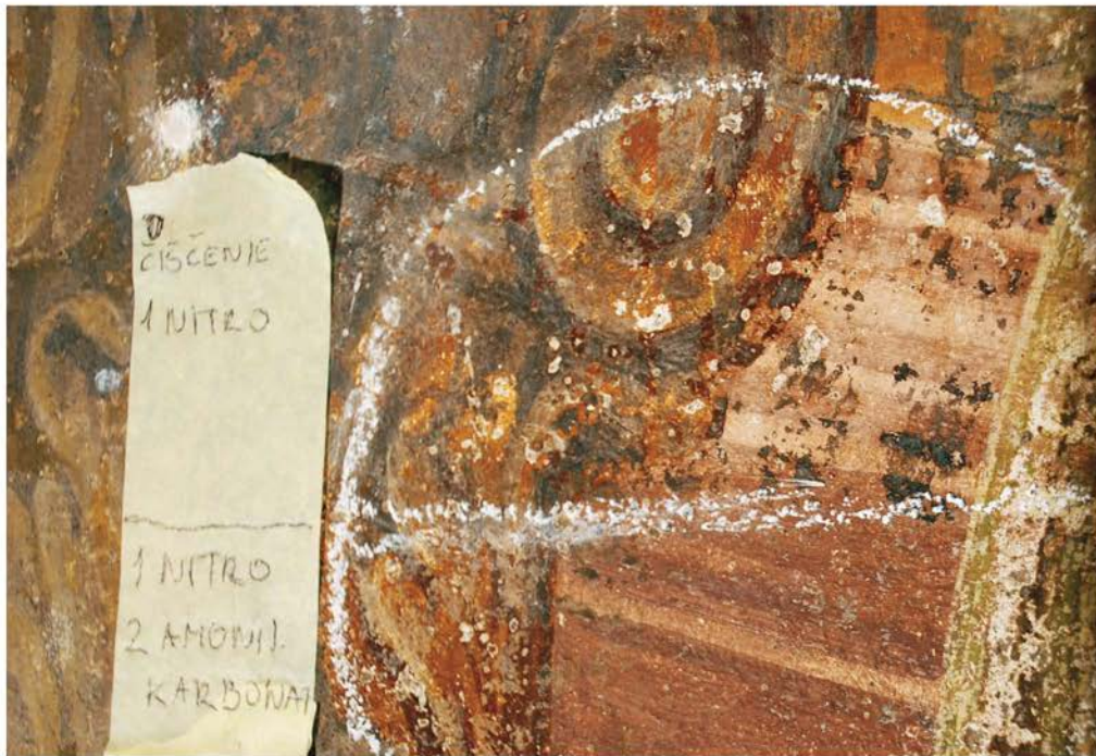
Sonda odstranjevanja potemnega filma stare akrilne emulzije ter umazanije in preslikav (foto: A. Jazbec, 2008)
