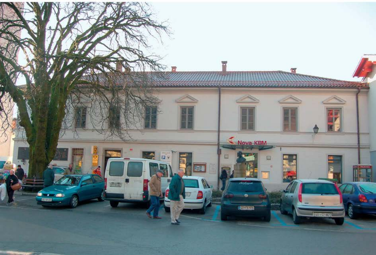
Popotresno saniran objekt na Trgu svobode v Kobaridu (foto: A. Ščukovt, 2008)
