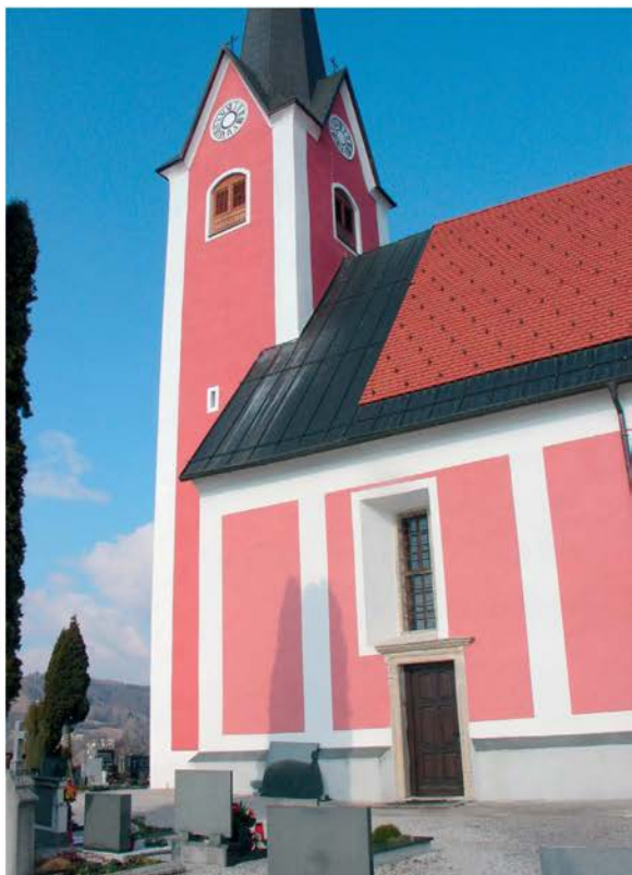
Pogled na del obnovljene zunanjšine cerkve sv. Križa (foto: A. Plevčak)
