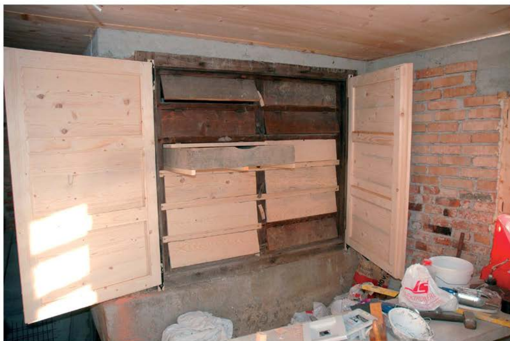
Pogled na obnovljeno sušilno komoro s predali za sušenje sadja (foto: D. Štepec, 2009, Arhiv ZVKDS, OE Novo mesto)
