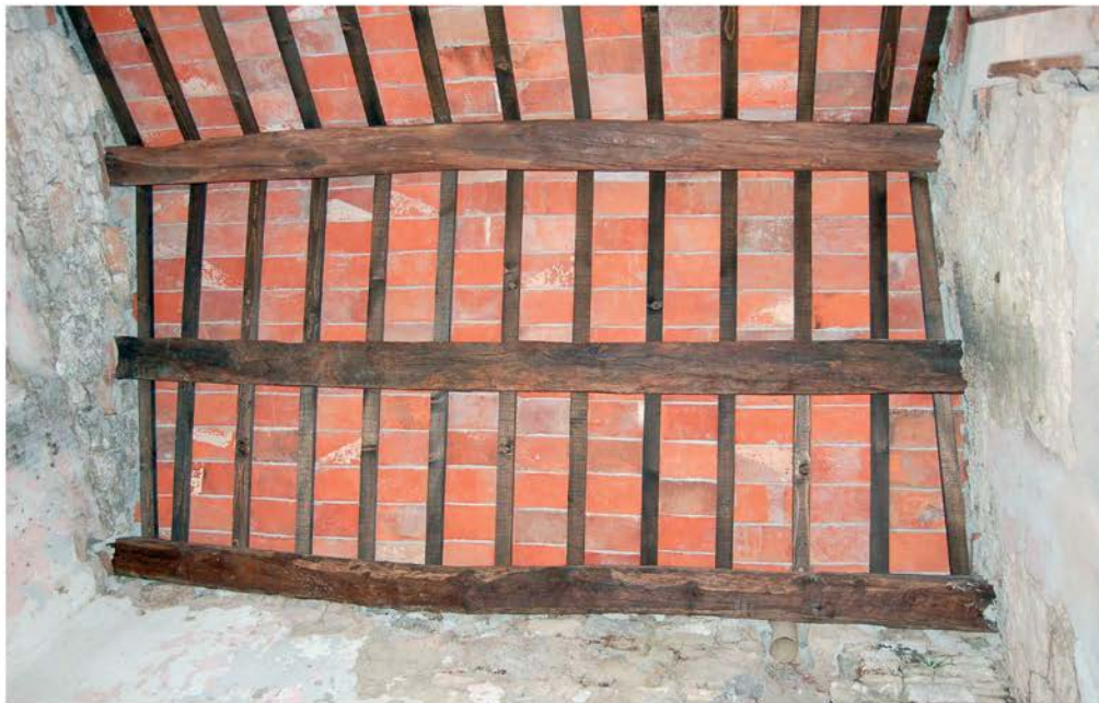
Streha kaplanije po rekonstrukciji. Uporabljene so bile stare lesene grede in opečne planetke (foto: E. Belingar, 2008)
