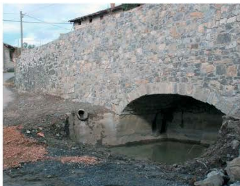
Pogled na obnovljeni vodni zbiralnik (foto: A. Ščukovt, 2009)
