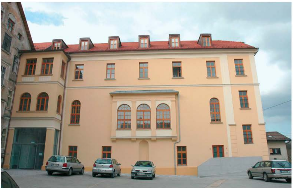
Novo mesto, osnovna šola Šmihel, obnovljeni severni trakt nekdanje dekliške samostanske šole (foto: D. Štepec, 2009, Arhiv ZVKDS, OE Novo mesto)
