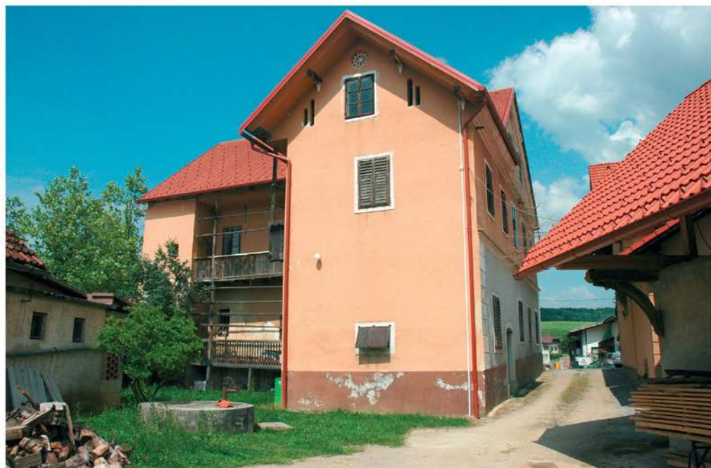
Pogled na dvoriščno fasado hiše z lesenim gankom pred obnovo (foto: D. Štepec, 2008, Arhiv ZVKDS, OE Novo mesto)
