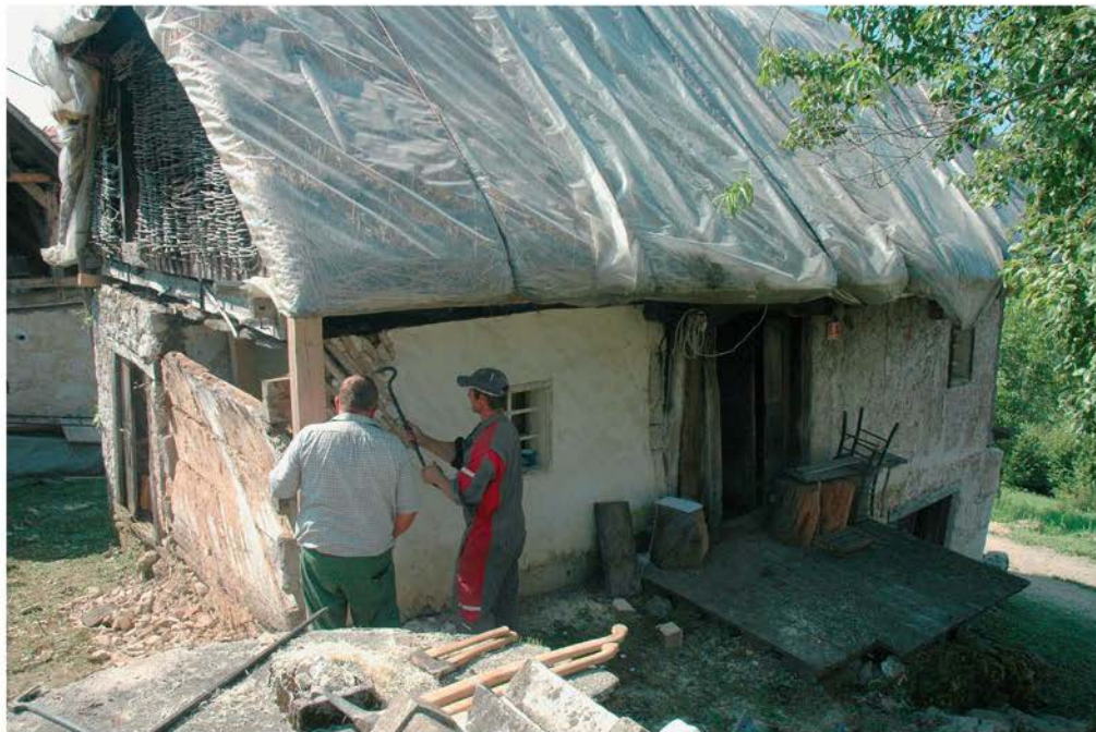
Razstavljanje lesenih kladnih sten na hiši (foto: D. Štepec, 2008, Arhiv ZVKDS, OE Novo mesto)
