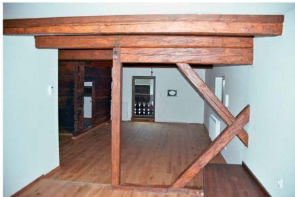
Bled, domačija Zagoriška 18. Ohranjanje kašče in še zdravega konstrukcijskega lesa v dnevni sobi (foto: R. Pamič)
