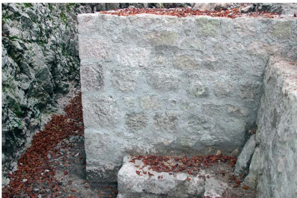
Zaprikraj, stanje obrambnega jarka po prenovi (foto: E. Drole, 2008)
