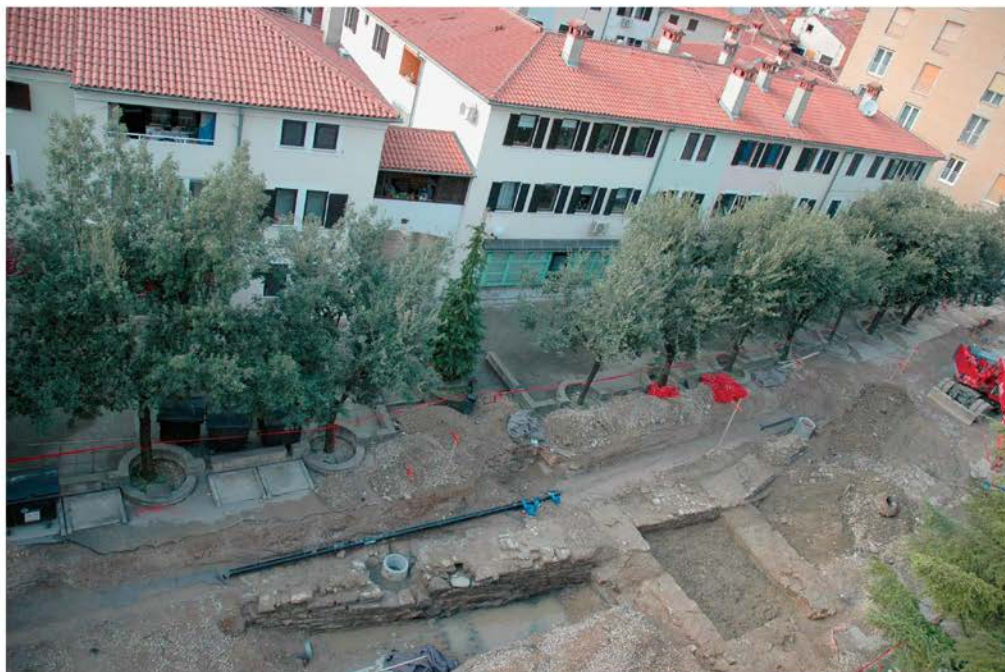
Lokacija 1 – ohranjeni temelji mestnega obzidja in Munijskega stolpa (foto: A. A. Trenz)
