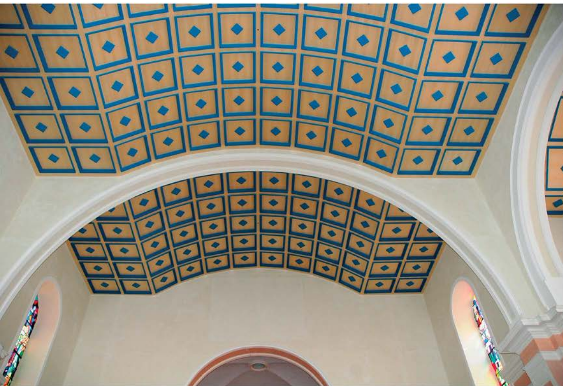
Novi leseni strop cerkve Matere božje na Zaplazu. (foto: T. Golob)
