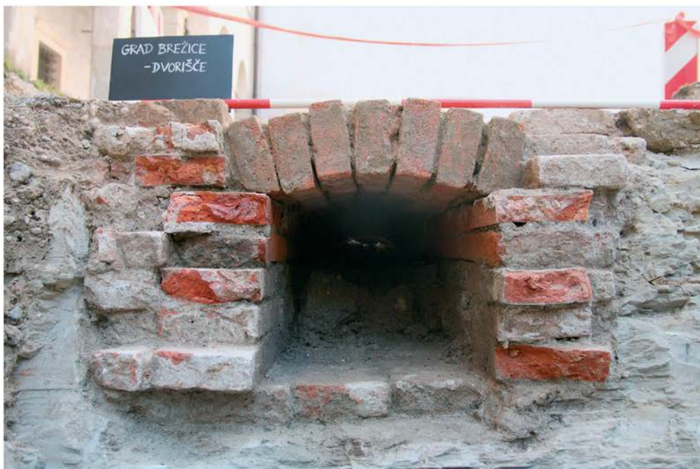
Obokan opečni kanal za odvajanje odpadne vode na dvorišču gradu Brežice 19.–prva polovica 20. stoletja (foto S. Olič)
