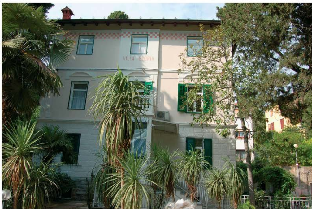
Portorož, vila Gloria, glavna fasada, stanje po obnovi (foto: V. Prohinar)
