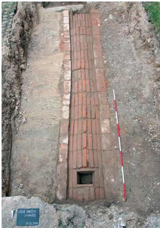
Obokan opečni kanal za odvajanje odpadne vode na dvorišču gradu Brežice 19.–prva polovica 20. stoletja (foto S. Olič)
