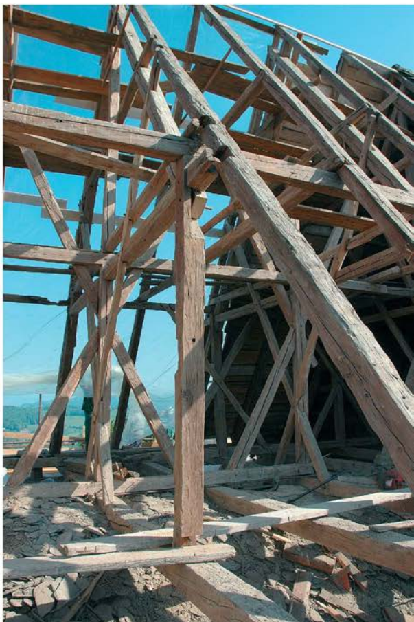
Cerkev sv. Roka, strešna konstrukcija ladje med obnovo (foto: B. Badovinac)
