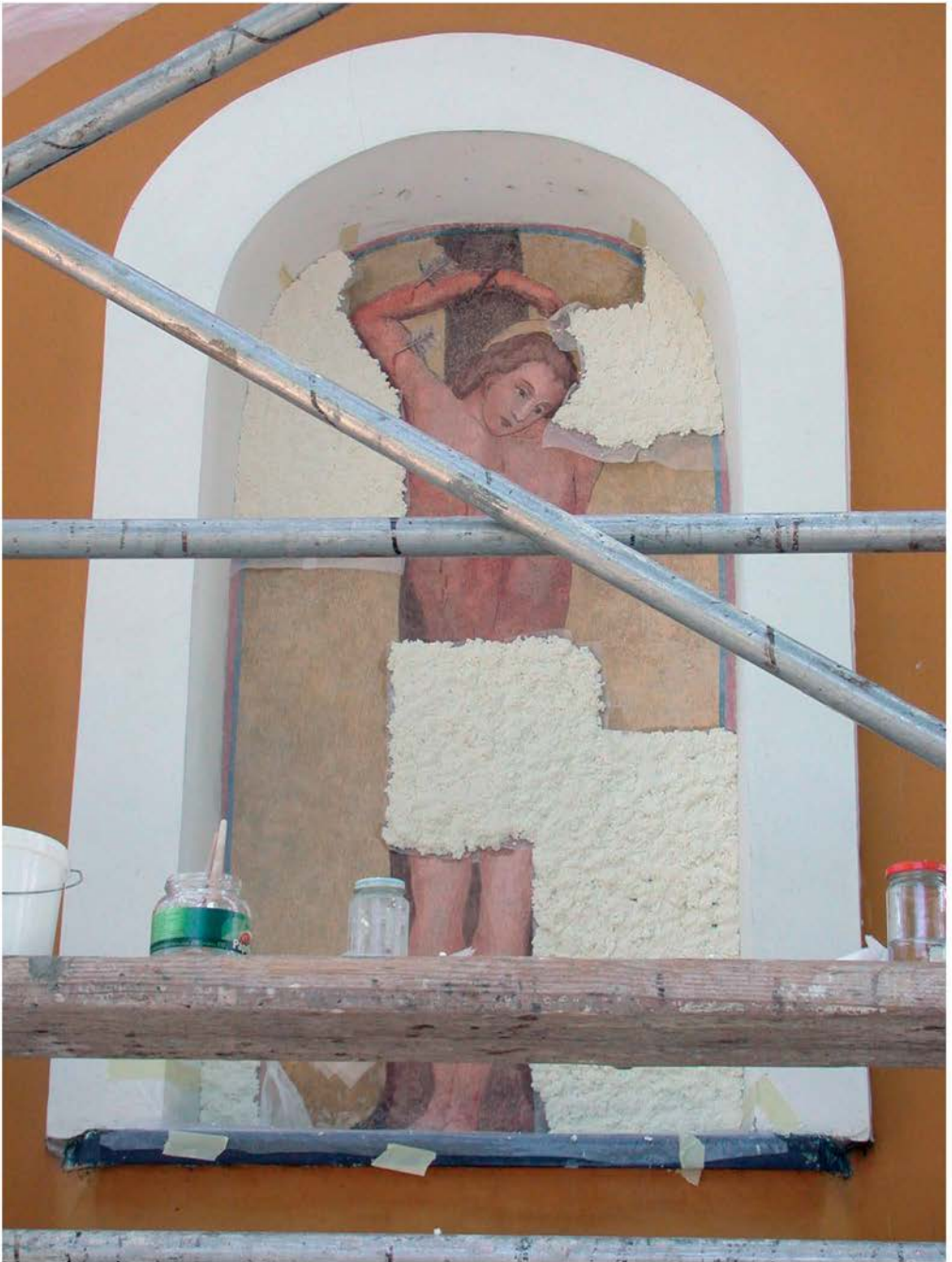
Mostec, cerkev sv. Sebastijana in Florijana: obdelava retuš z oblogami barijevega hidroksida (foto: T. Mesojevec)
