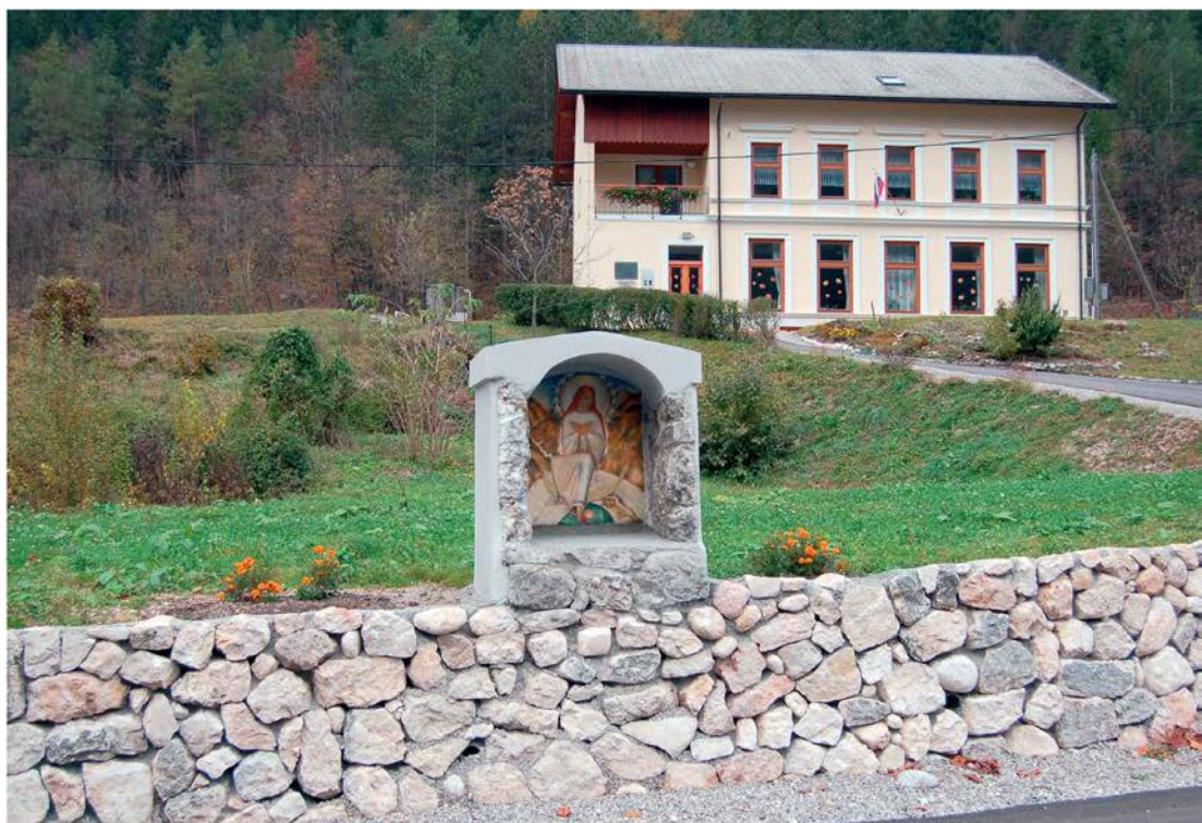
Prestavljena in obnovljena niša z restavrirano poslikavo v Soči (foto: A. Ščukovt, 2008)
