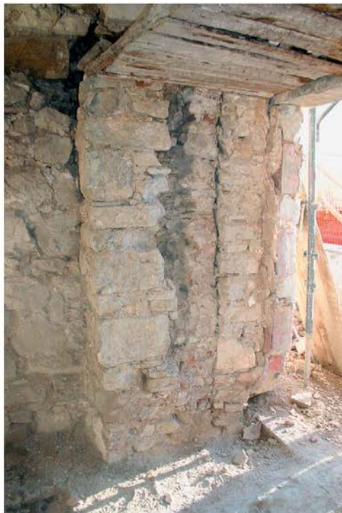
Ob vhodnih vratih v kuhinjo kaplanije je lepo vidna prizidana stena kot izravnava zunanje fasade (foto: E. Belingar, 2008)
