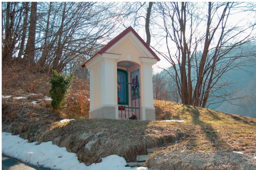
Straža pri Cerknem, celovito obnovljena kapelica domačije v Rovtu (foto: A. Ščukovt, 2009)
