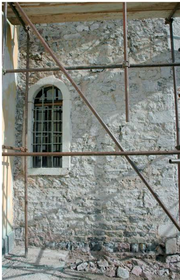
Zidava in ometi starejšega kvadratnega prezbiterija (foto: B. Badovinac)
