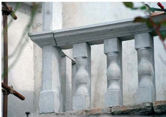
Restavrirana ograja po ponovni montaži na objektu (foto: A. Naglost, 2008)
