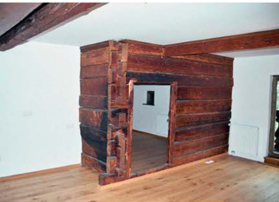
Bled, domačija Zagoriška 18. Ohranjanje kašče in še zdravega konstrukcijskega lesa v dnevni sobi (foto: R. Pamič)
