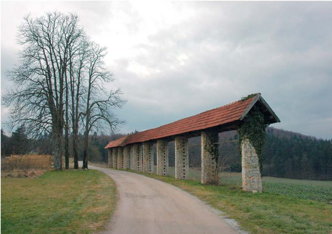
Stanje na Lanšprežu pred obnovo kozolca in vodnjaka (foto: D. Štepec, 2008, Arhiv ZVKDS, OE Novo mesto)
