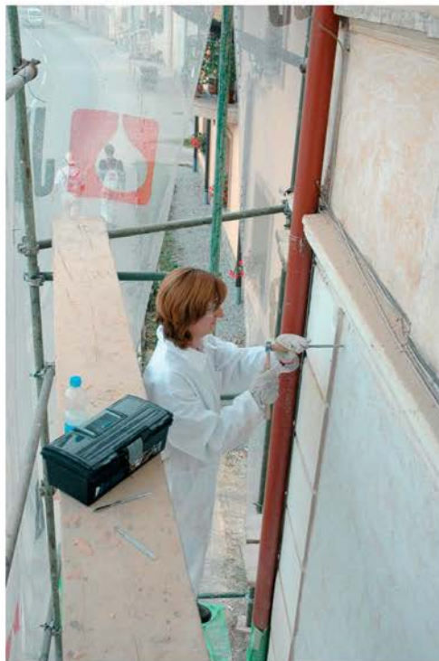
Sondiranje fasade in opleskov (foto: D. Štepec, 2008, Arhiv ZVKDS, OE Novo mesto)
