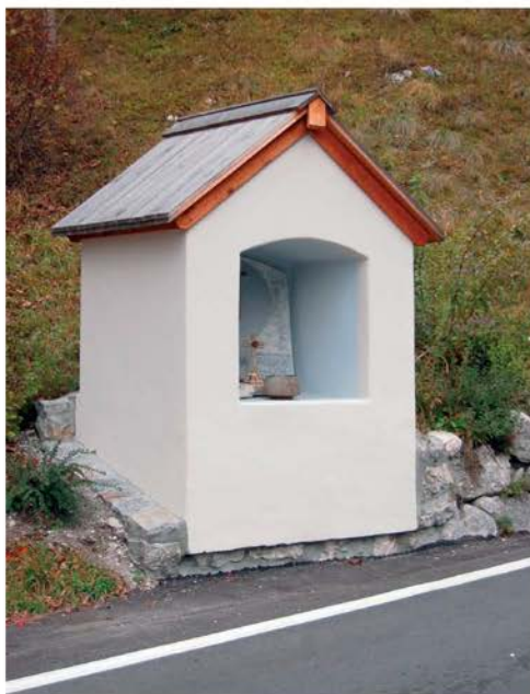
Celovito obnovljena kapelica, Barbeščevo znamenje (foto: A. Ščukovt, 2008)
