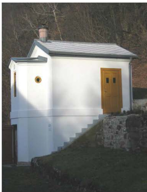
Čuvajnica po obnovi (foto D. Pediček)
