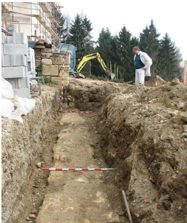
Kamniti temelj v smeri SV–JZ pred objektom B (foto: ZVKDS; Oe Maribor)
