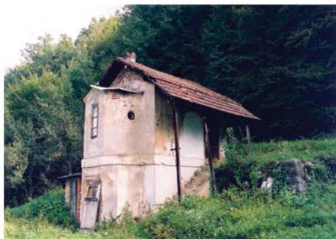
Čuvajnica pred prenovo (foto D.Pediček)
