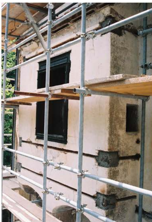
Betoniranje vezi na fasadi (foto: Majda Obreza Špeh)
