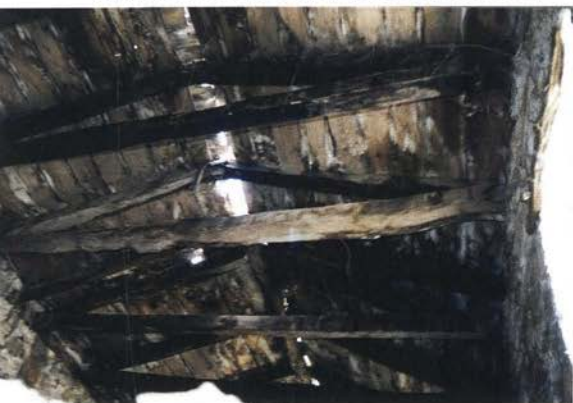
Dotrajana strešna konstrukcija (foto: E. Benčič-Mohar)
