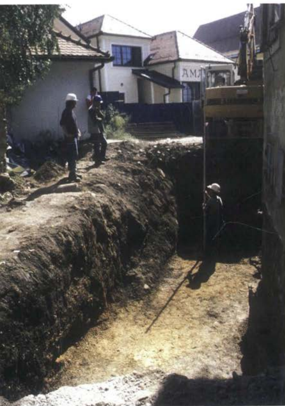
Ptuj, Prešernova ulica. Izkop za prizidek k objektu Prešernova ulica 38 (foto: M. Lubšina Tušek)
