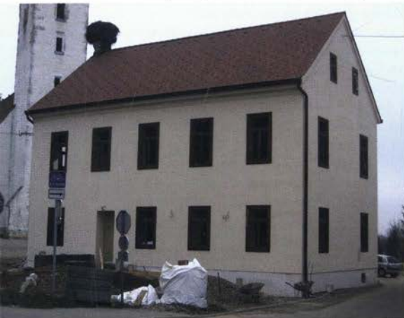
Stara šola v Martjancih po obnovi (foto: S. Vešligaj)
