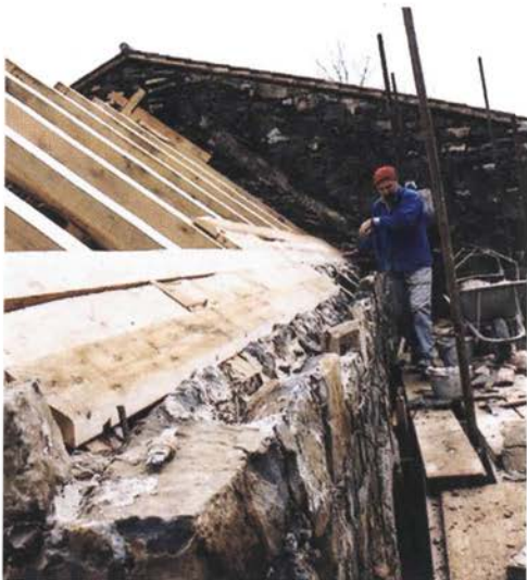
Izvedena strešna vez. December 2006 (foto: A. Ščukovt)
