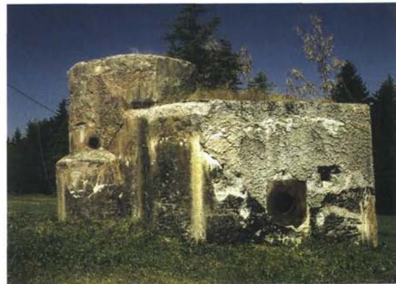
Žirovski Vrh sv. Antona – strojnični bunker na Javorču (foto: R. Pamič)
