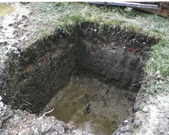
Arheološki nadzor pri zemeljskih delih izgradnje nove policijske postaje v Ormožu. Izkop za točkovne temelje na zahodni strani novega objekta (foto: I. Tušek)
