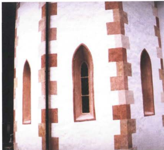
Prezbiterij cerkve sv. Kancijana po obnovi (foto: M. Lesar Kikelj)
