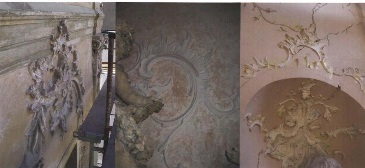
Utrjevanje in sanacija štukaturne dekoracije v notranjščini (foto: M. Habjanič)
