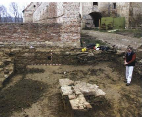
Grad Negova, 2006. Pogled na notranjost stolpa B (foto: I. Tušek)
