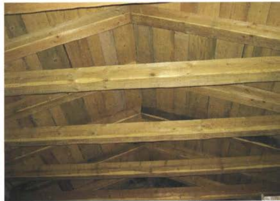
Obnovljena strešna konstrukcija (foto: E. Benčič-Mohar)
