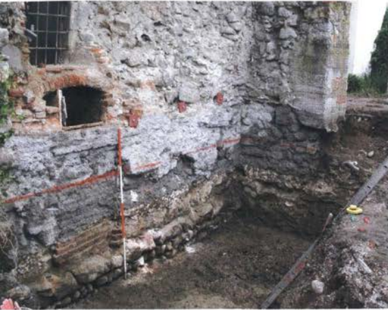
Maribor – minoritski samostan. Pogled na jugovzhodni vogal južne sonde s srednjeveškimi temelji samostana (foto: I. Tušek)
