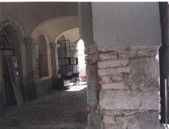
Odbijanje neustreznih ometov na stebrih vhodne lope (foto: M. Habjanič)
