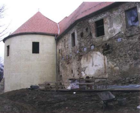
JV fasada gradu z novo streho in rekonstruiranim obrambnim stolpom ter kletno etažo novega zimskega vrta (foto: M. Habjanič)
