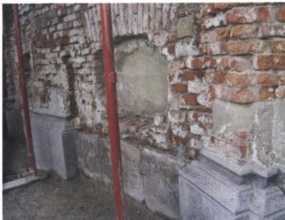
Odbiti neustrezní ometi na fasadi (foto: M. Habjanič)
