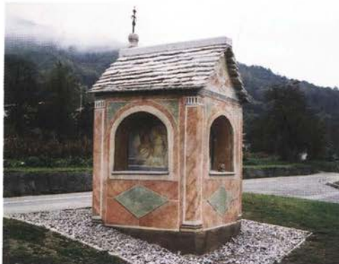
Pogled na celovito obnovljeno ročinjsko znamenje, november 2006 (foto: A. Ščukovt)
