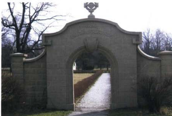
Vhodni portal po obnovi
