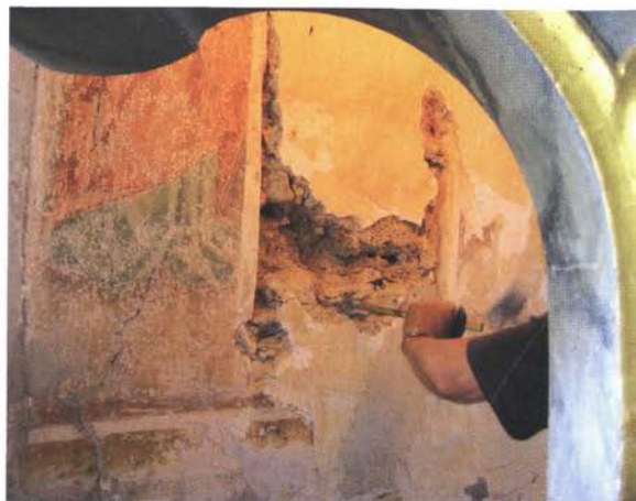
Odstranjevanje gradbenega materiala iz prvotnih gotških odprtin (foto: M. Lesar Kikelj)
