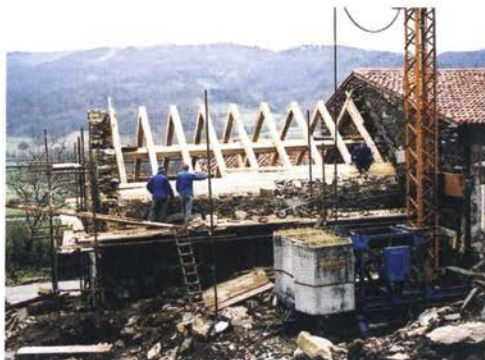
Nova strešna konstrukcija iz hrastovega lesa. December 2006 (foto: A. Ščukovt)
