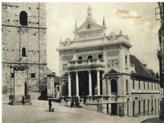
Klasicistična fasada Mestnega gledališče Ptuj pred porušitvijo vhodnega preddverja
