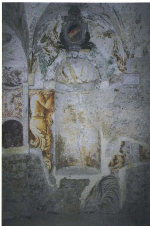
Vipava – Lanthierijev grad, odkrite freske na podestu stopnišča z marmoriranim vzorcem na okenski špaleti (foto: B. Klemenčič)
