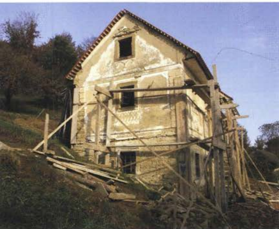
Obnova strehe (foto: T. Hohnc)
