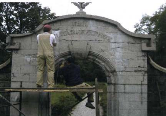
Vhodni portal pred obnovo
