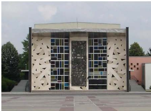
Glavno pročelje pred prenovo, pogled s trga; september 2004 (datoteka: Kulturni dom Velenje)
