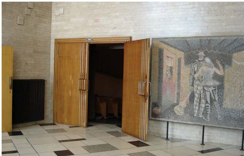
Ohranjeni detajl interierja (vhod v glavno dvorano; september 2004)
