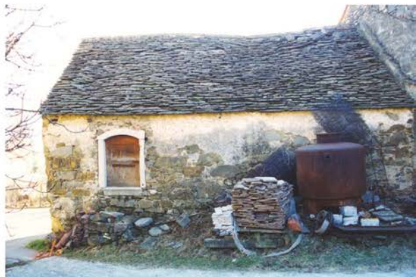
Zahodna stran gospodarskega objekta, stanje pred obnovo leta 2000 (foto: Andrejka Ščukovt)
