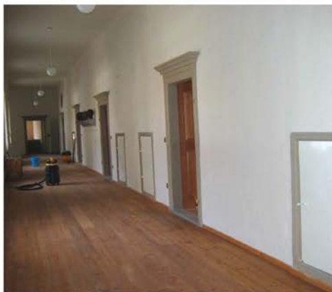
Hodnik »provincialata« v drugi etaži zahodnega trakta po prenovi
