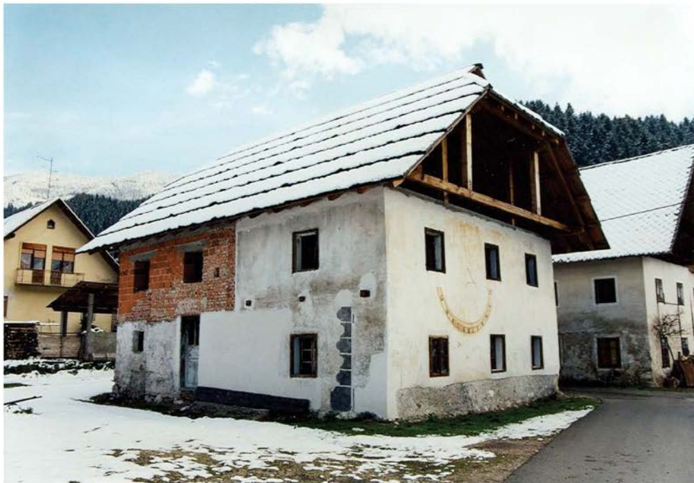
Hiša Rateče 43 – med obnovo (foto: Renata Pamič, ZVKDS, OE Kranj, april 1998)
