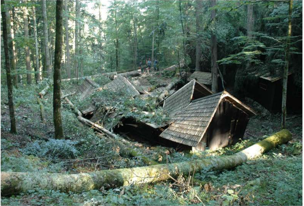
Velika baraka za ranjence po odstranitvi podrtih dreves (foto: J. Podgornik, iz arhiva ZVKDS, OE Novo mesto)
