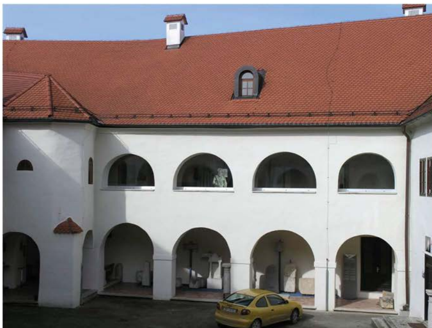
Metlika, grad, zastekljen arkadni hodnik – pogled od zunaj (foto: Leon Gregorčič)
