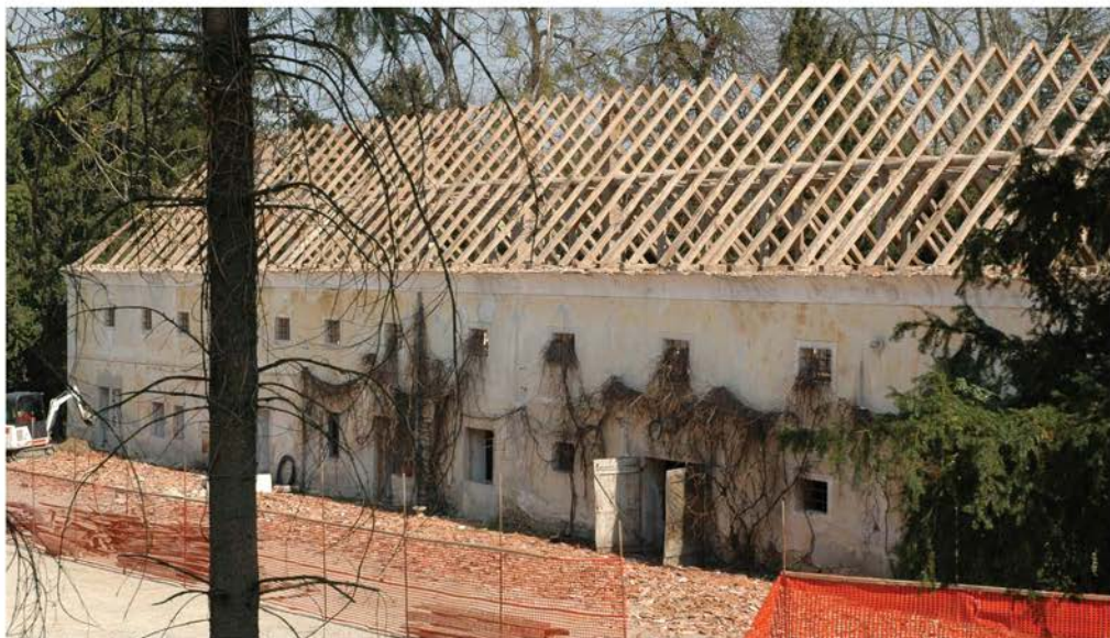
Grajska kašča ob začetku obnove (foto: Tomaž Golob)
