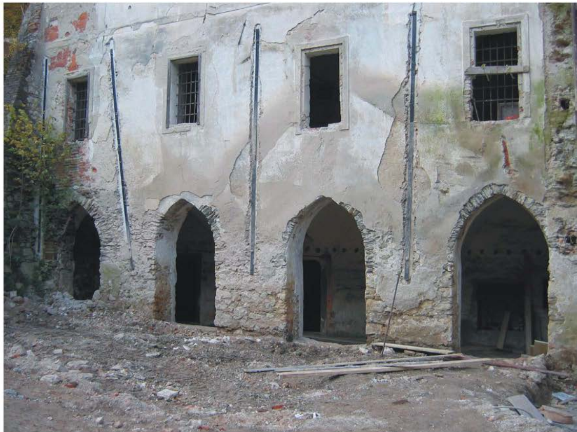
Gotski arkadni hodnik po odstranitvi pozidav (foto: A. Horvat)
