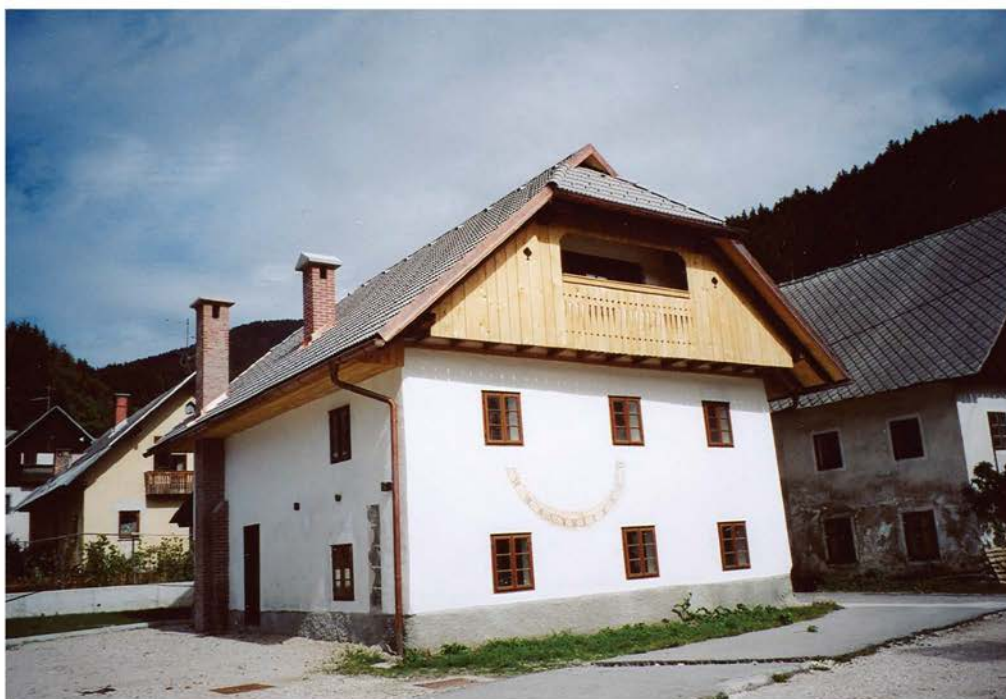
Hiša Rateče 43 – po obnovi (foto: Lidija Uranič, ZVKDS, OE Kranj, september 2004)
