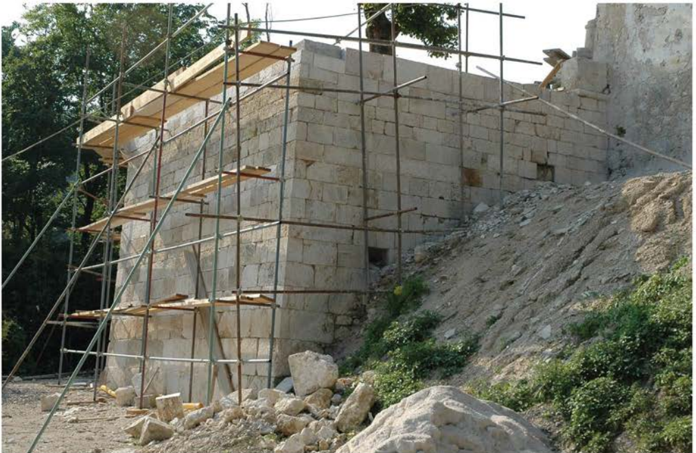
Podporni zid ob koncu obnove (foto: Tomaž Golob)
