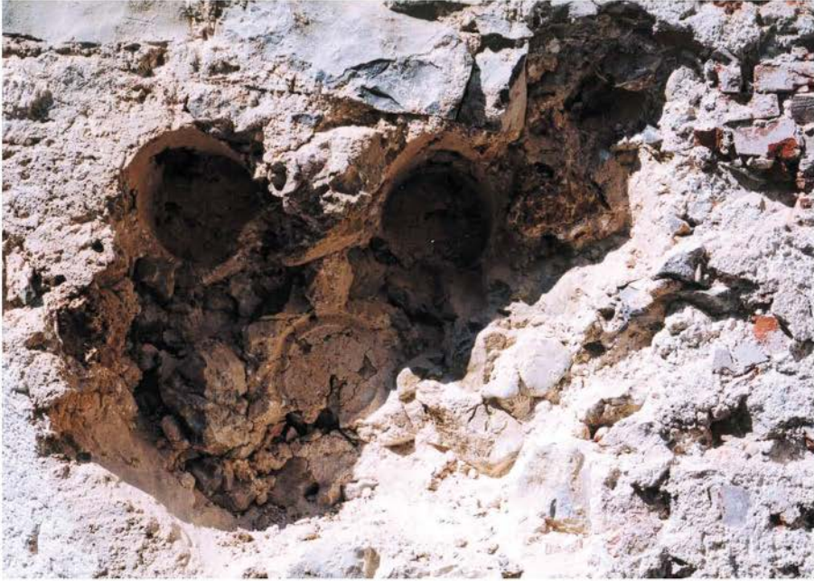
Detajl odtisa bifornih stebričev v zidu po njihovi izzidavi.
