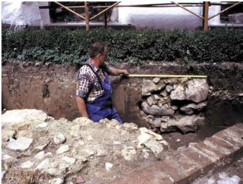
Izmera dimenzij temelja masivnega opornika.
