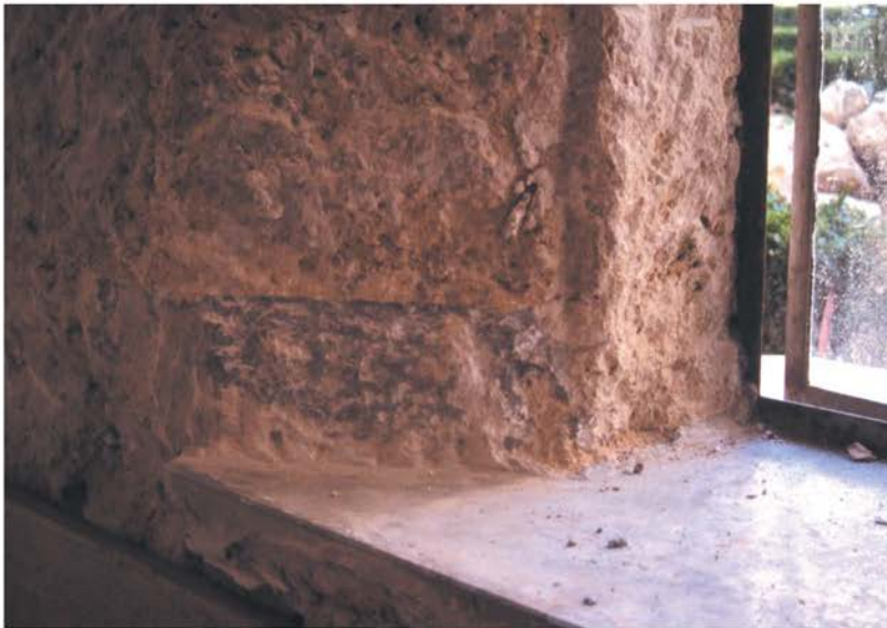
Detajl posekane baze v paleti šilastoločne odprtine, ki so ohranjene v vseh obstoječih odprtinah
