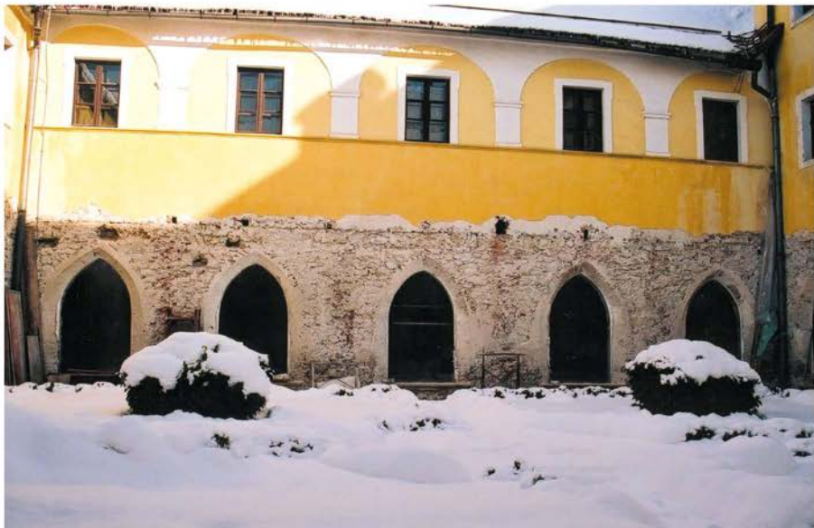
Severna fasada križnega vrta z vidno višino križnega hodnika in opečnimi polnili na mestih nekdanjih opornikov.
