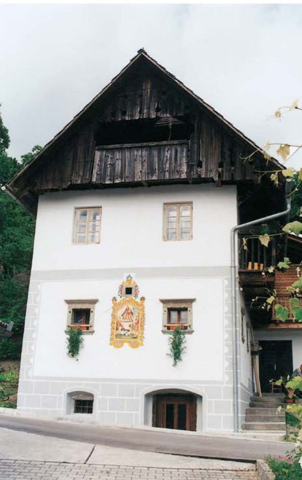
Podbrezje št. 19, manjša kajžarska hiša po obnovi fasade, freska na čelni strani in »šivani vogali«. Stanje leta 1999. Foto: V. Knific
