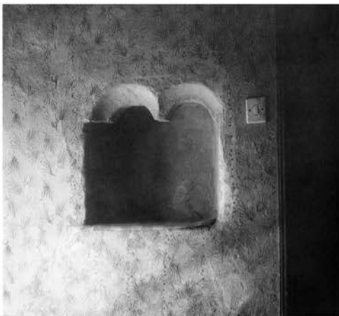
Lesce, Begunjska cesta 2, detajl v veži: »škafnica« s kamnitima lokoma. Stanje leta 1987. Foto: V. Knific
