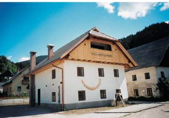
Rateče št. 43, zidana nadstropna hiša po obnovi; dvoriščna in južna fasada s sončno uro, balkonski zatrep. Stanje leta 2004. Foto: L. Uranič
