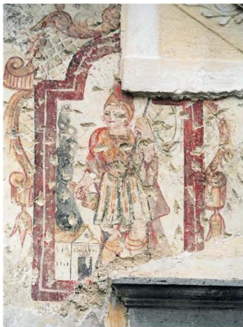
Nemški Rovt 5, freska sv. Florijana; poškodbe zaradi kasnejše vzdanega kamnitega okenskega okvirja in novih ometov z reliefno dekoracijo. Stanje leta 1998. Foto: B. J. Filipič.
