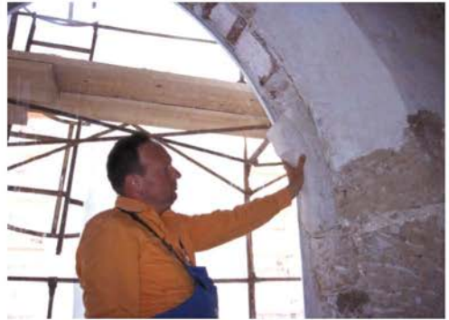
Preverjanje ležišča krogovičij v šilastoločnih odprtinah.
