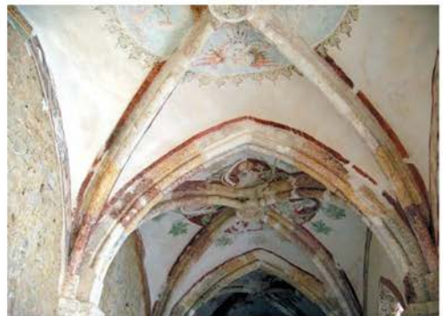
Strop v fazi finega kitanja.
