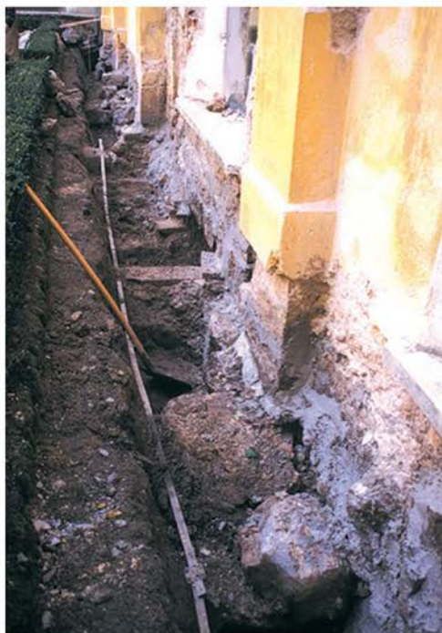
Odkop za drenažo, stanje temeljev, viden strelvod in vidni ostanki opornikov ob J fasadi.
