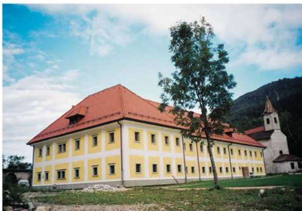
Jesenice, delavska Kasarna na Stari Savi: pogled na južno in vzhodno fasado po zaključenih obnovitvenih delih. Stanje leta 2004. Foto: V. Knific
