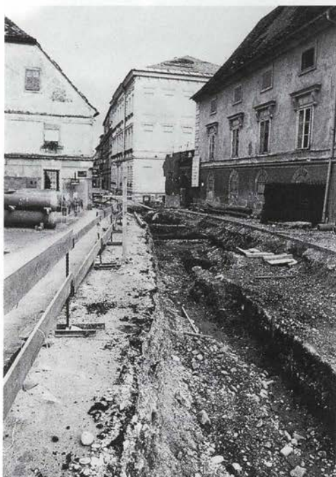
Pogled na izkop z rimskimi zidanimi temelji pred Malim gradom iz zahoda.
