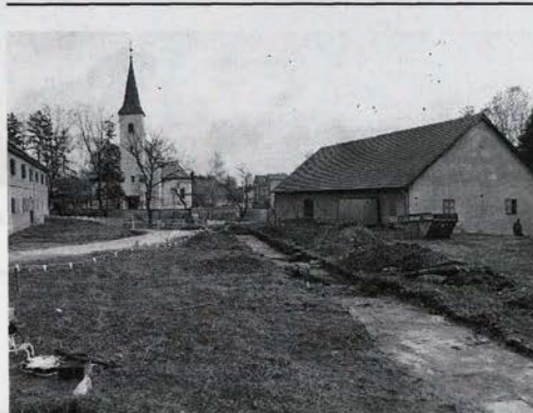
Ptuj, vojaška skladišča ob Potrčevi cesti, pogled na sondo
