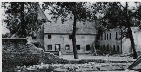
Ptuj, skladišča ob Potrčevi cesti, pogled na del poslopja s cerkvijo tik pred rušenjem leta 1975
