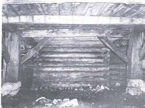
Dolenjčev stan v planini Laz, 1978; prostor pod stanom s "telečnjakom" in konstrukcijskim elementom za "kobilah"
