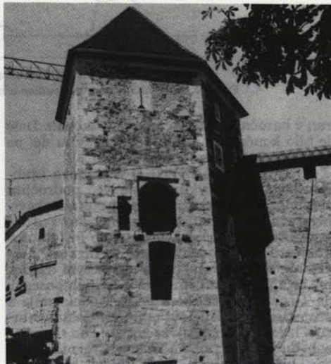
Sl. 157. Ljubljana – peterokotni stolp na gradu med obnovo
