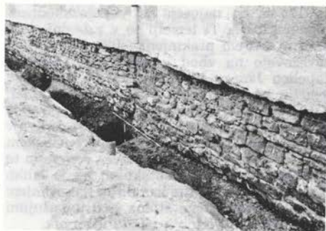
Sl. 102 Ptuj, Mali Grad na Prešernovi ulici – sanacija temelja 102. Ptuj, Mali Grad/Small Castle – sanitation of the basis
