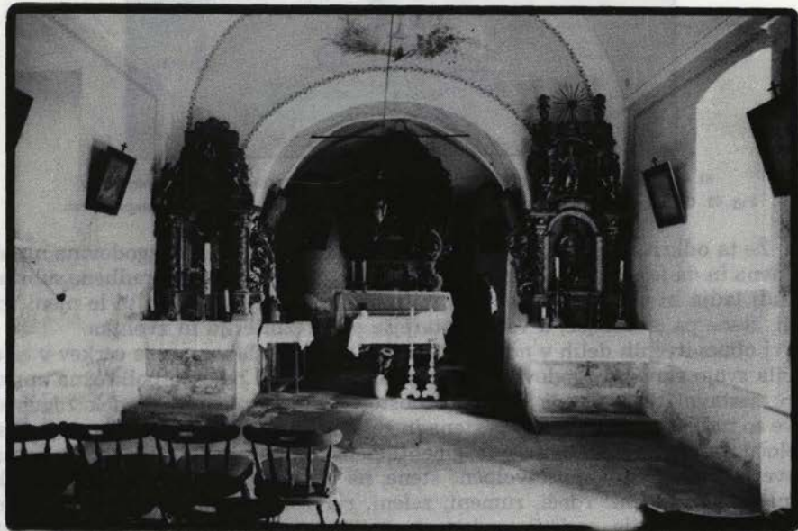
Sl. 62. Gorenja Straža, pogled proti prezbiteriju pred obnovo
