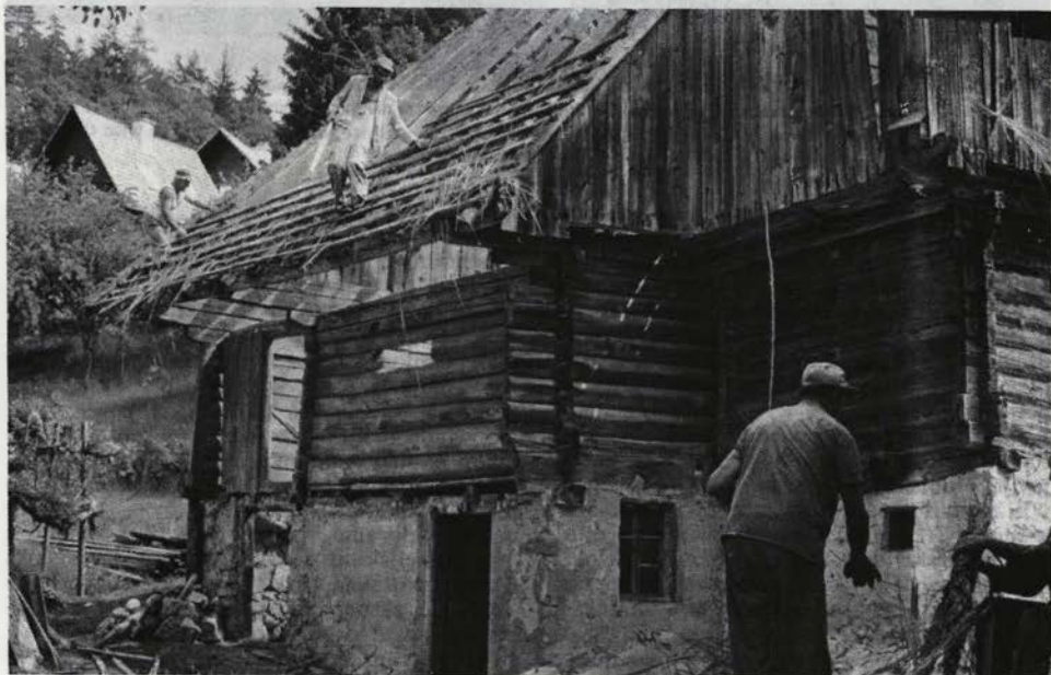
Sl. 143. Vrhpolje pri Moravčah – gospodarsko poslopje med obnovo Fig. 143. Vrhpolje pri/by Moravčec – the outhouse during the restoration
