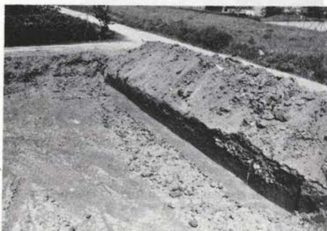
Sl. 100 Ptuj, Selinšek, parc. št. 2134 k. o. Ptuj – pogled na izkop in zahodni profil 100. Ptuj, Selinšek, parcel no. 2134 – view to the place of findings and the western profile
