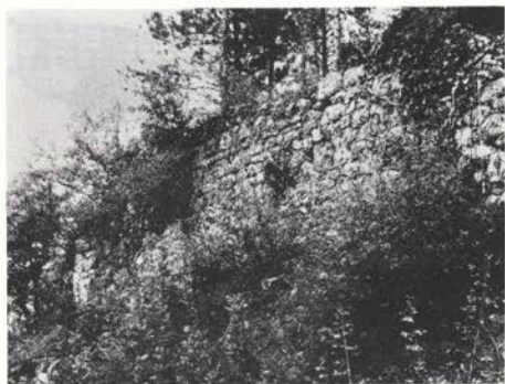
Sl. 60 Podnanos, Tabor – obzidje: južna polovica Z zidu s porušnim SZ vogalom
