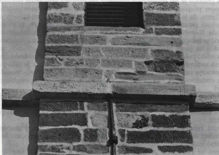
Sl. 42. Ptuj – Mestni stolp: obnovljeni mejni zidec in zastičenje kamnitih blokov (f. J. Mikuž) Fig. 42 – Ptuj – Town Tower: detail after restoration
