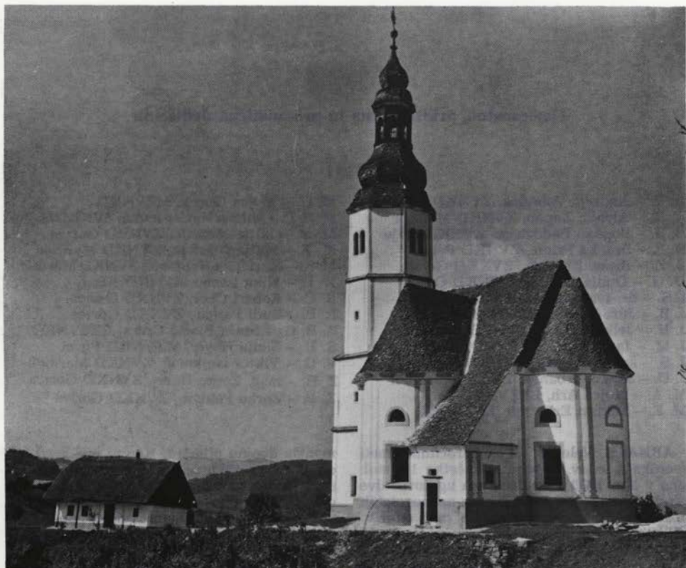
Sl. 112 Babna gora – obnovljena zunanjščina p. c. sv. Ane Fig. 112 Babna gora – the exterior after renewal
