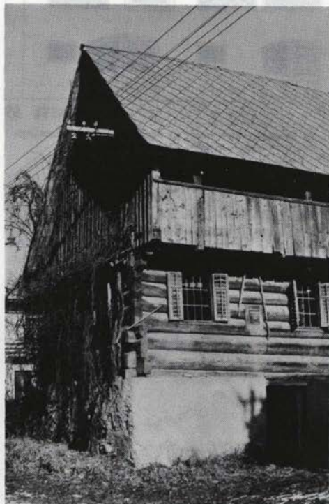
Sl. 93 Olševke 45 – lesena kmečka hiša pri Bič, letnica 1784 na tramu, morda zaman čaka na prenos v muzej ljudskega stavbarstva, zaradi nadomestne gradnje je obsojena Fig. 93 Olševke 45 – the wooden house from 1783: could it still be saved on time for the open-air museum?
