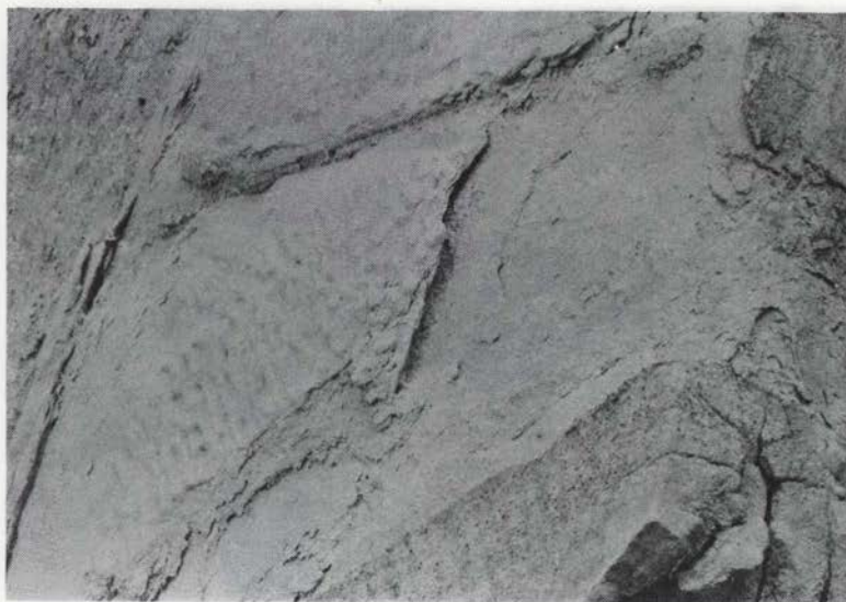
Sl. 40. Ptuj – Mestni stolp: luščenje kamna je posledica napačne graditve (sedimentacijske plasti so navpične) (f. J. Mikuž)
