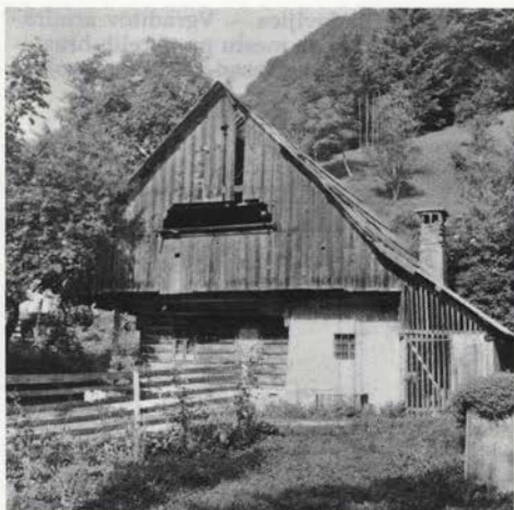
Sl. 88 Grabče 21 – lesena kajža pred poružitvijo Fig. 88 Grabče 21 – before demolition
