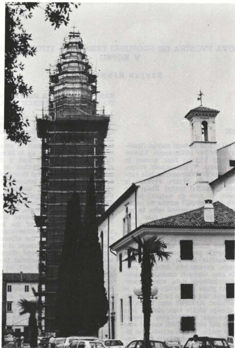
Sl. 53. Koper, stolp v času obnove (f. Milan Vinčec)
