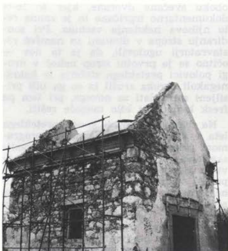
Sl. 31. Crnelo — obnova strehe na grajski kapeli (fototeka ZVNKD Kranj)
