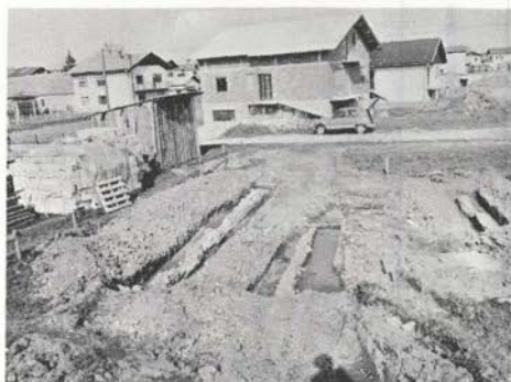
Sl. 58. Hajdina — 1988, parc. št. 1092/11 in 1087/2, last J. Gajserja; pogled na slabo ohranjene temelje rimskih zidov v izkopu za novo gradnjo
