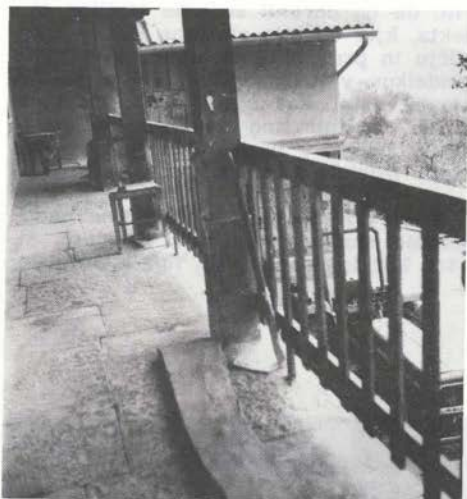
Sl. 24. Vrtovin 84 — tlak na balkonu, kamnite plošče
