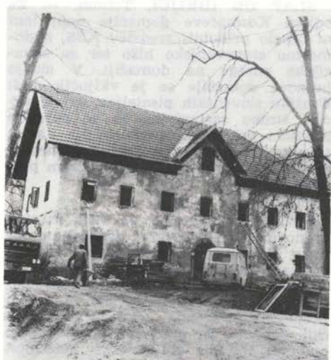
Sl. 16. Spodnja Idrija 80 — stanovanjski del med obnovo
