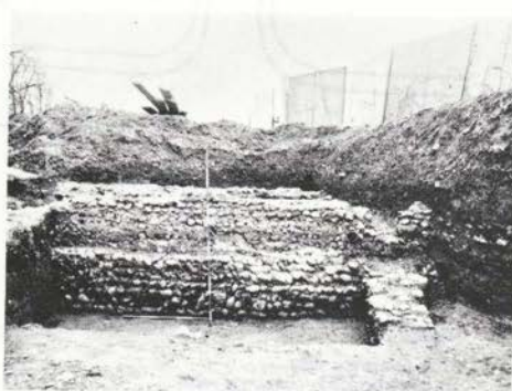
Sl. 52. Ptuj — vroečovod ob bolnici »dr. J. Potrča«, 1988: pogled na temelji zidu s keramično cevjo
