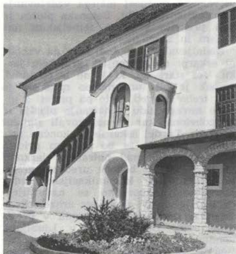
Sl. 29. Braslovče 35 — obnovljena zunanjšina župnišča (f. B. Badovinac)
