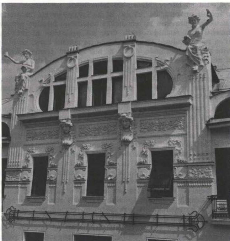
Sl. 8. Ljubljana, Miklošičeva 4, obnovljena fasada (f. V. Benedik)
