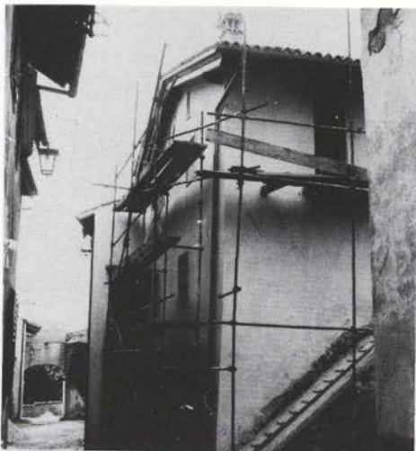
Sl. 19. Smartno 21 -- stanovanjski del med obnovo
