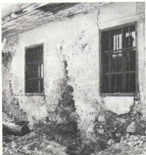
Sl. 60. a, b: Žirovnica — r. hiša M. Cop, med oknoma viden vogal in pri sondiranju ugotovljeno gotsko okno (fototeka ZVNKD Kranj)
