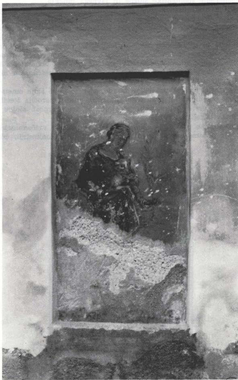
Sl. 26. Zbilje, kapelica, kjer je zaradi kapilarne vlage in rekristalizacije topnih soli razpadel pas v spodnjem delu slike
