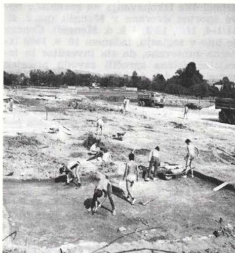
Sl. 42. Mengeš — delovišče športne dvorane, čiščenje planuma v severozahodnem vogalu spodnje terase
