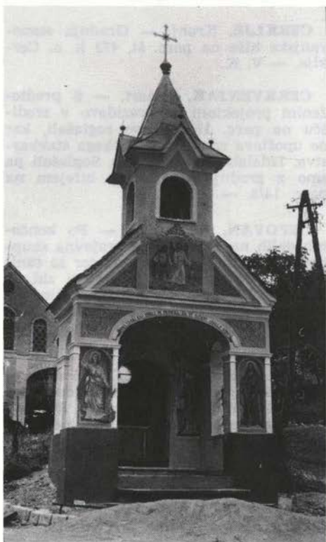
Sl. 1. Bukovje — Bezenškova kapela po obnovi Fig. 1 — Bukovje — the Bezenšek chapel after restoration
