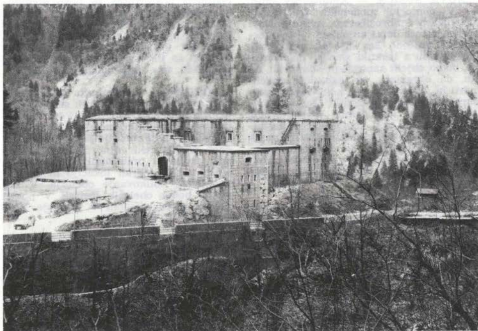
Sl. 57. Kluže — pogled na trdnjavo po obnovi strehe na sprednjem objektu Fig. 57 — Kluže — a view of the fortress after the renewal of the roof on the front object
