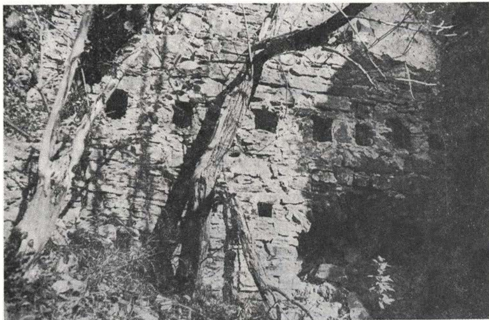
Sl. 93. Tramovnice v predelni steni. Desno pod njimi je vrh vratne odprtine, na načrtu označene s št. 19. Desno zgoraj je večja zaplata izvirnega, gladko zalikanega ometa
