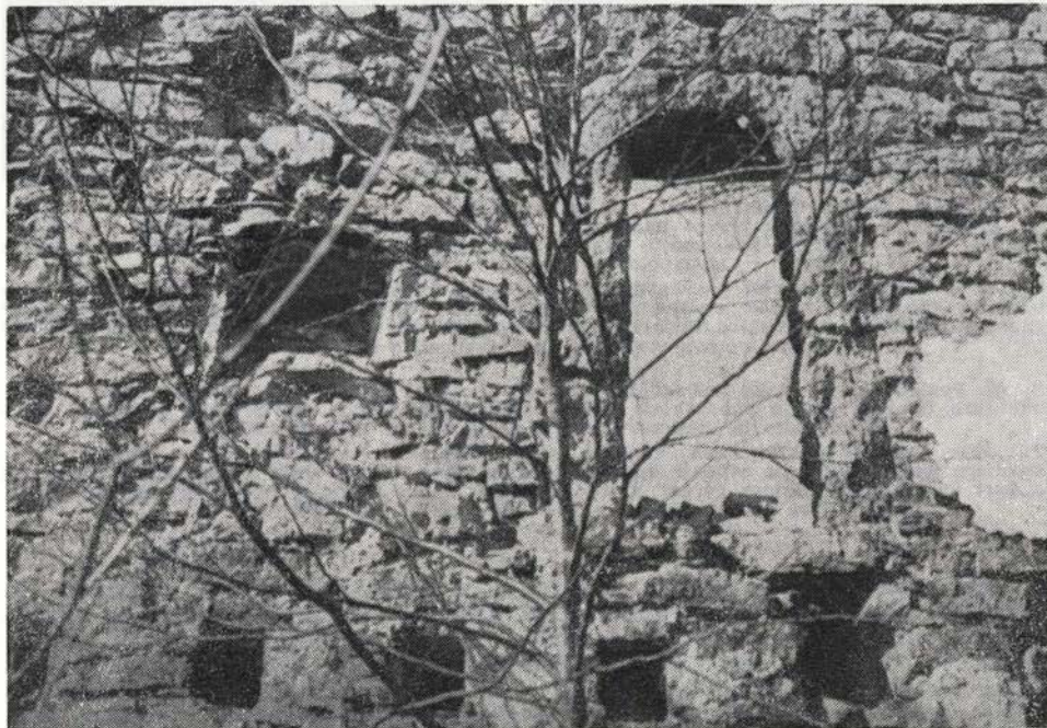
Sl. 97. Portal stranišča v tretjem nadstropju (št. 15) in pohištvena niša (št. 20). Vidne so tramovnice poda tretjega nadstropja
