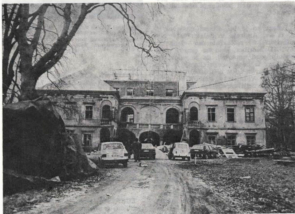
Sl. 135. Turnišče pri Ptuj — gradbena dela na gradu Fig. 135 — Turnišče near Ptuj: construction works on the castle
