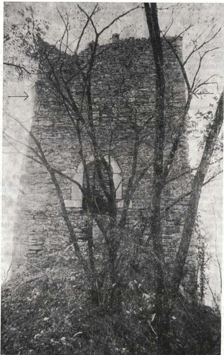
Sl. 92. Severno pročelje romanske grajske hiše. Puščici kažeta, kje se začne zidava vogalov s klesanci iz lehnjaka. Pod portalom je vidna skala, po kateri so lezli do vhoda
