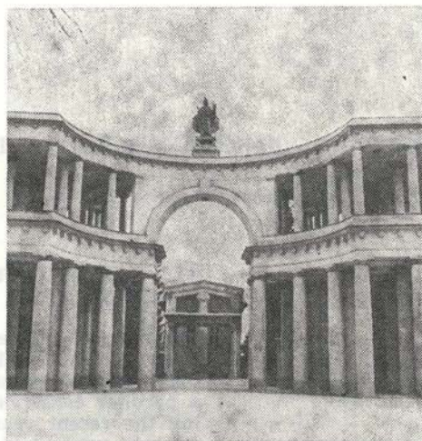
Sl. 63. Propileje pred obnovo. Vidni so različni barvni odtenki na popravljenih stebrih Fig. 63 — Propylaeum before restoration. Various colour shades can be seen on the repaired columns
