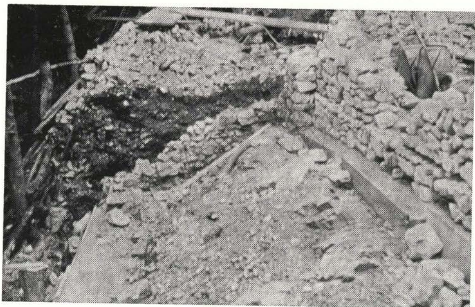
Sl. 31. Ajdna — Novo temeljenje narteksa Fig. 31 — Ajdna — new groundwork of the narthex
