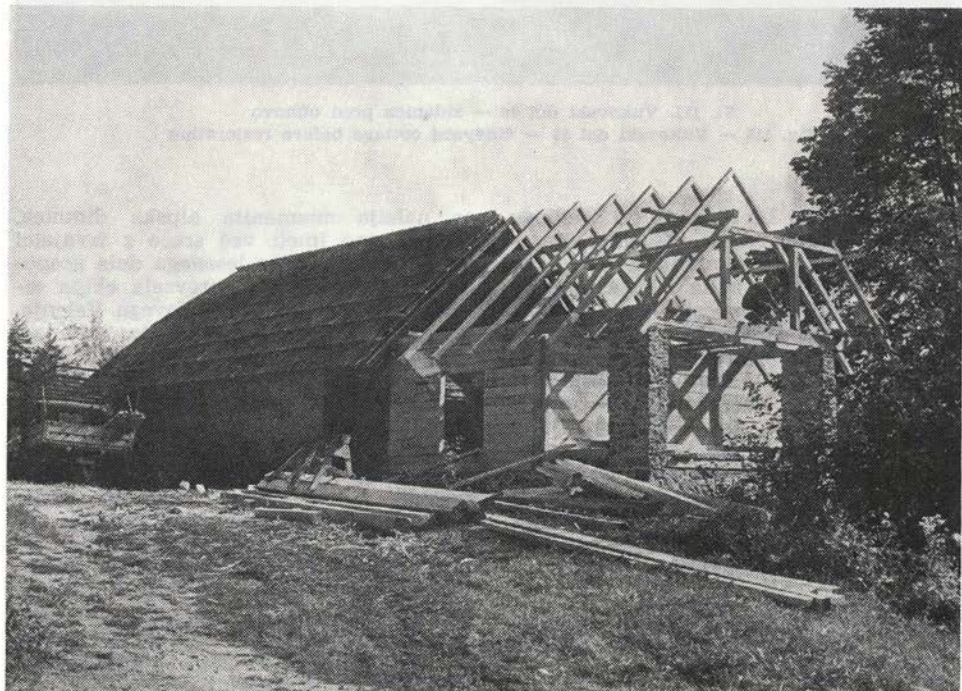
Sl. 118. Zavodnje 43, Kavčnikova domačija. Dela na rekonstrukciji gospodarskega poslopja Fig. 118 — Zavodnje 43, Kavčnik house. Works being carried out on the reconstruction of the farm-building
