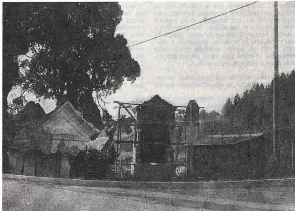
Sl. 112. Topolščica 199, zaselek Lajše. Rekonstrukcija kapele na novi lokaciji. Iz stare kapele so bili v novo vgrajeni vsi pomembnejši elementi (kamnita podpora stebrišča, železna vez z letnico 1846)
