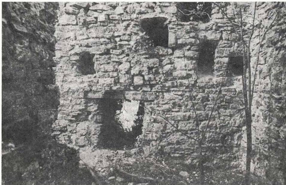
Sl. 96. Odprtine v zahodni strani prostora D. Spodaj je okence (št. 5), nad njim levo je odprtina za prag vratne odprtine (št. 17). V isti vodoravni vrsti sta dvojna tramovnica za stopnice in podest in še ena tramovnica za podest. Višje je izlivnica (št. 7) in deloma vidno okence (št. 1). Zavoljo uporabe širokokotnega objekta je perspektiva spačena; odprtina za prag leži v navpični ravnini deloma porušene predelne stene, na fotografiji vidne levo
