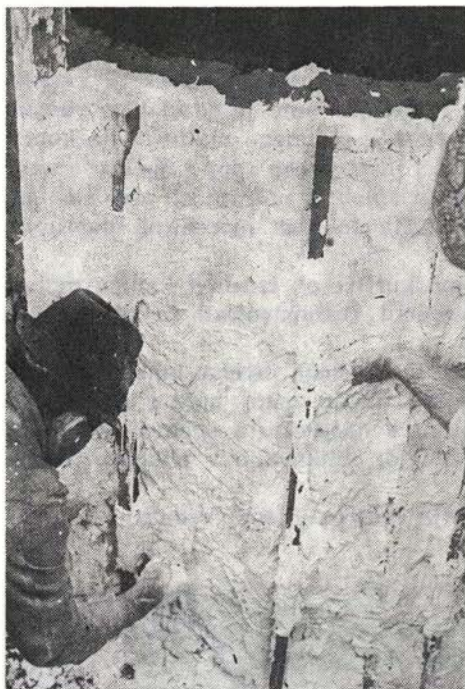
Sl. 36. Hajdina — odlivanje peči (faza 5 in 6): pričvrstitev opornikov z juto in mavcem (foto: Mira Gulič)
