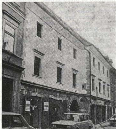
Sl. 123. Celje, Zidanškova 3: rekonstruiran zgornji del renesančne fasade
