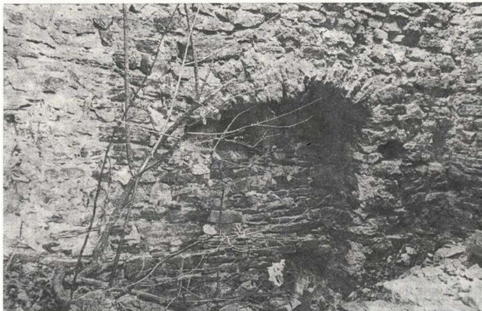
Sl. 101. Pogled na notranji del recentno zazidanega vhodnega portala. Viden je predrt del zazidave. Desno ob portalni niši sta recentni tramovnici, levo sega v nišo še ena recentna tramovnica
