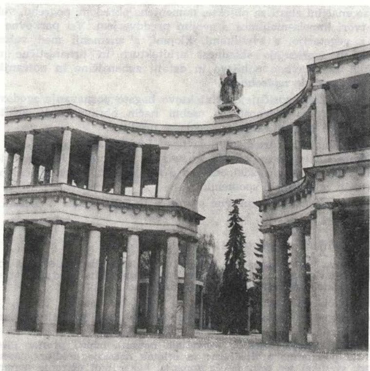
Sl. 65. Propileje pred obnovo. Vidni so različni barvni odtenki na popravljenih stebrih
