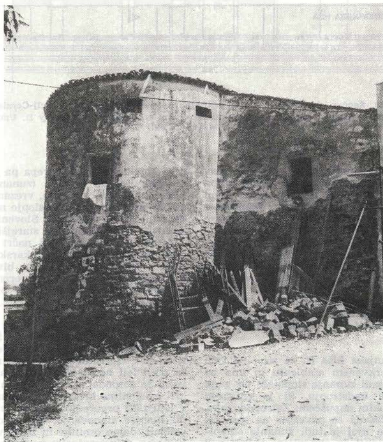
Sl. 111. Smartno 16, jugozahodni stolp pred obnovo
