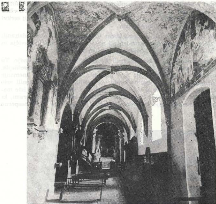
Sl. 46. Ptuj — obnovljena južna ladja proti vzhodu Fig. 46 — Ptuj — renewed southern aisle, eastward
