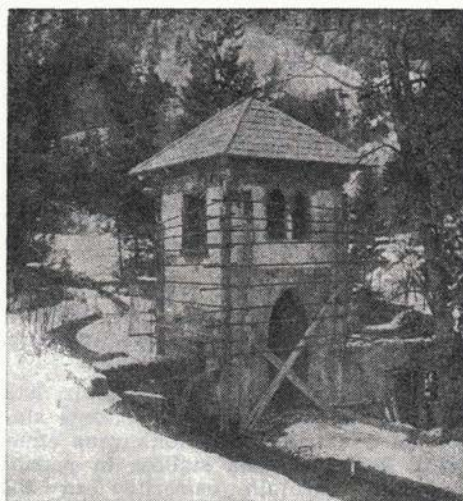
Sl. 55. Grabče, Strojjeva kovačnica — začasna statična ureditev stolpa z jeklenimi cevmi
