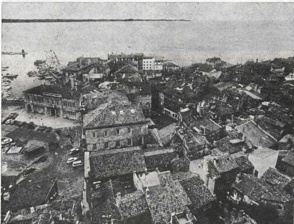
Sl. 81. Piran. Pogled na peto mestno fasado s prenovljenim hotelom (D. Gale)
