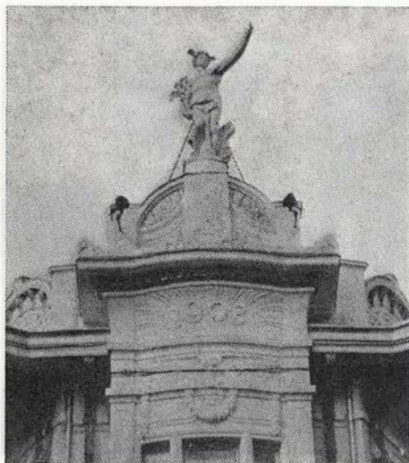
Sl. 103. Ljubljana, Prešernov trg veleblagovnica Centromerkur, kopija plastike — na podlagi rekonstruiranega originala (F. Benedik)
