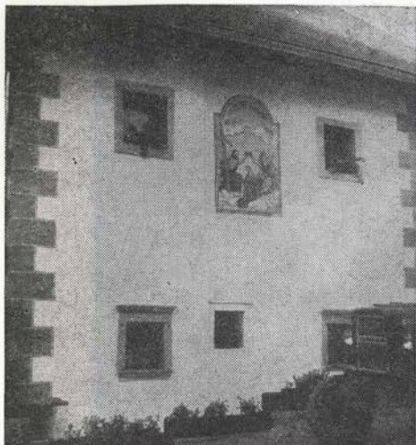
Sl. 65. Podkoren 18, obnovljena freska na obcestni fasadi
