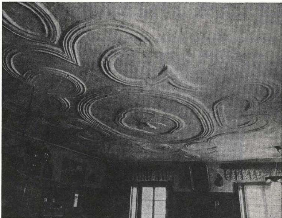
Sl. 61. Železniki — Racovnik 50, strop v Popčevi hiši Fig. 61 — Železniki — Racovnik 50, the ceiling of Popčeva house
