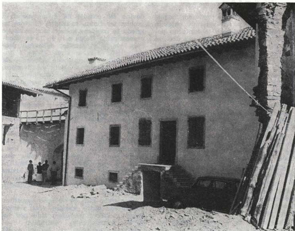
Sl. 70. Šmartno v Brdih, JV obzidje, ureditev fasade in preboj v klet
