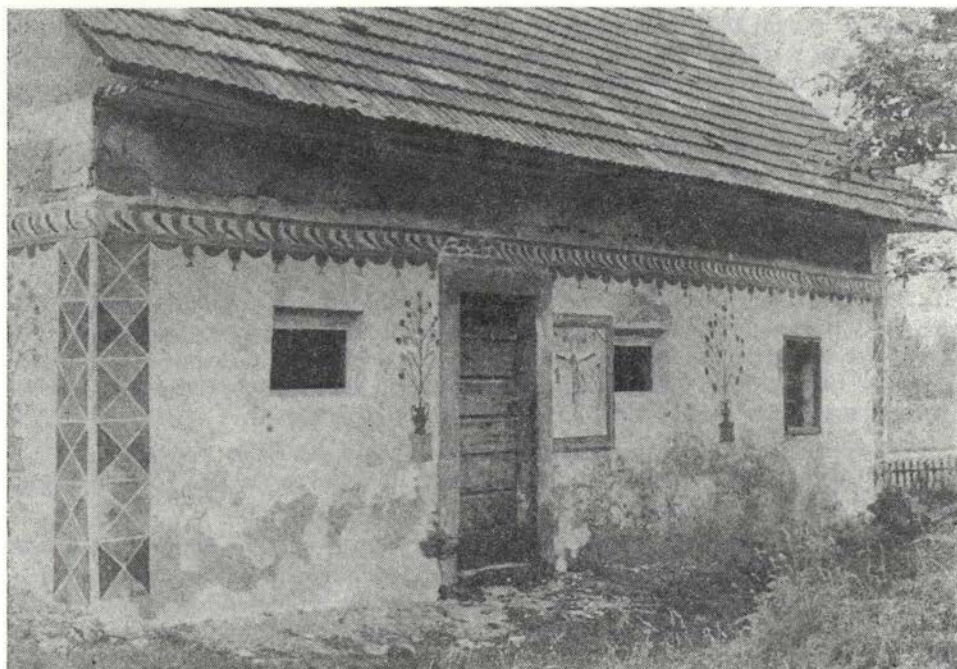
Sl. 44. Zavratac nad Godovičem: Gnoj in vegetacija sta uničevala steno poslikane hiše (stanje pred in po posegu — foto I. Bogovčič)
