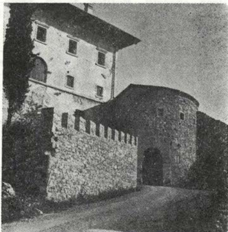
Sl. 133. Stanjel, obnovljeni vhodni stolp Fig. 133 Stanjel — the restored eastern tower
