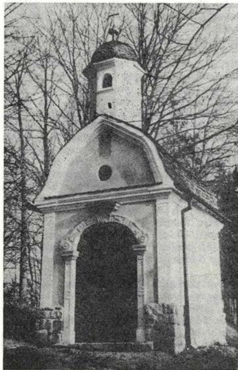
Sl. 106. Celje, Kalvarija, obnovljena 4. kapelica
