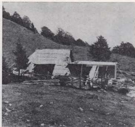
Sl. 135. Planina Jezerce. Gradnja stanu brez ustreznega dovoljenja na mestu ovalnega stanu velikoplaninskega tipa, stanje 1981
