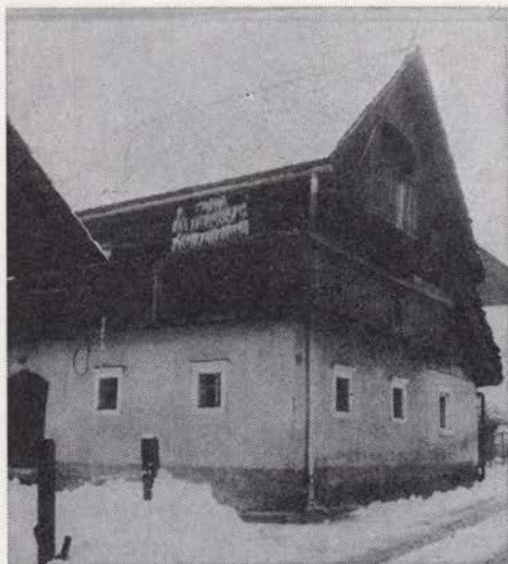
Sl. 132. Ljubno 17, zidana pritlična hiša s prizidano »kamro« in lesenim podstrešjem — nadstropjem, februar 1984
