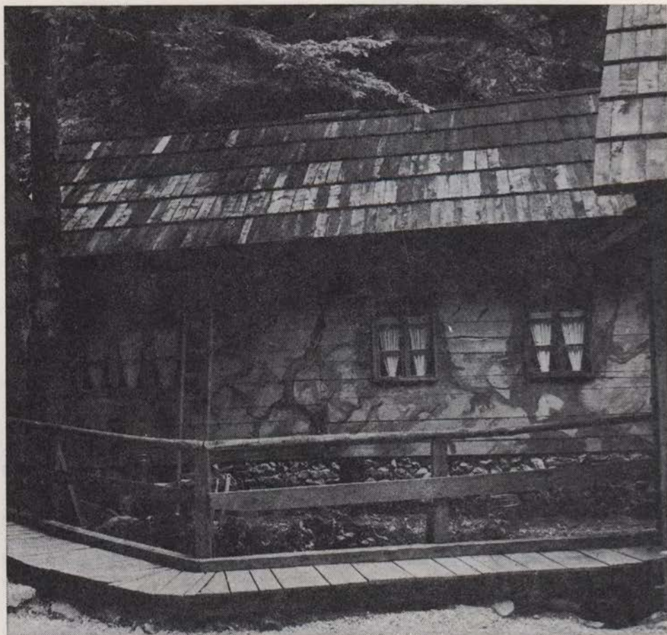
Sl. 4. Partizanska bolnica Franja pri Novakih — baraka za zdravnike, rekonstrukcija originalne sive maskirne poslikave ob obnovi leta 1982 (foto V. Benedik)
