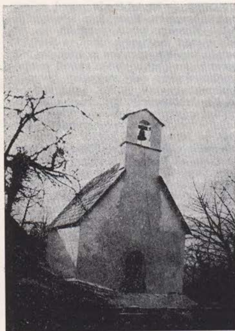
Sl. 172. Koseč — p. c. sv. Justa po končani obnovi
