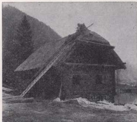
Sl. 153. Trebče — rekonstrukcija hiše Ane Kolar
