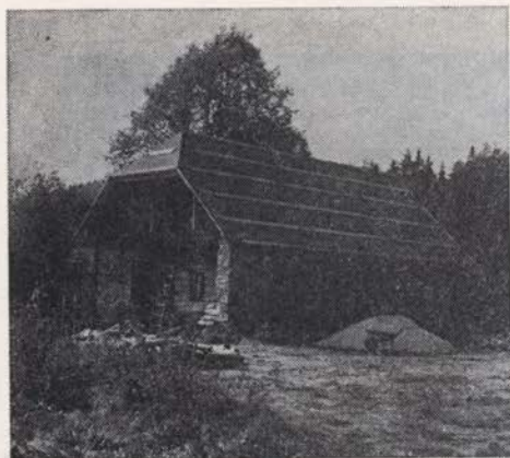
Sl. 158. Zavodje 43 — Kavčnikova domačija. Ohranjeni stanovanjski del osrednjega domačijskega poslopja. Streha rekonstruirana (pokrita bo s škodlami)
