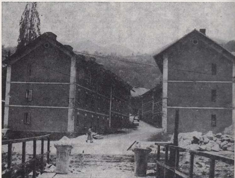
Sl. 194. Trbovlje — kolonija Njiva, delavska in rudarska stanovanja
