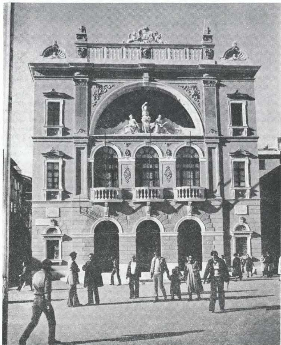
Sl. 37. Split, Hrvatsko narodno kazalište, glavno pročelje po obnovi, foto Z. Buljević Fig. 37 Split, Croatian National Theatre — the main facade after the renewal
