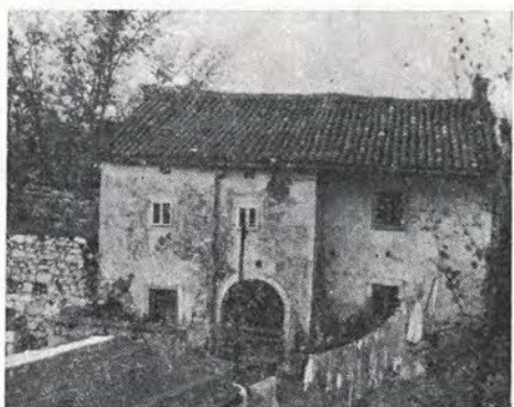
Sl. 98. Hrušica št. 17 Fig. 98 Hrušica, No. 17
