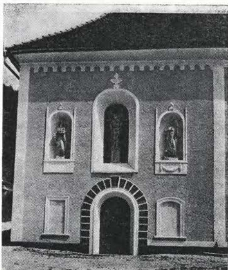
Sl. 120. Jurklošter — kuracija, neustrezno obnovljena
