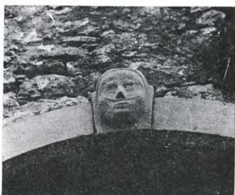
Sl. 96. Golac, št. 20 — sklepnik portala Fig. 96 Golac, No. 20 — keystone of the portal
