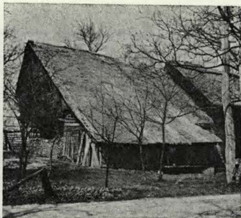
Sl. 106 Pristava št. 9, bivalni del kmečkega doma stegnjenega tipa s povsem uničeno slamnato streho (stanje leta 1971)
