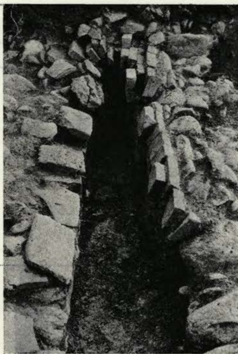
Sl. 59 Ruše — del odkopanega grelnega kanala blizu gomil »Na gavgah«
