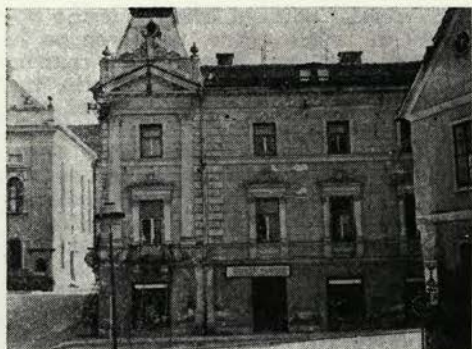
Sl. 115 Prebold — zahodna fasada hiše št. 26 Fig. 115 Prebold — the western façade of house No 26
