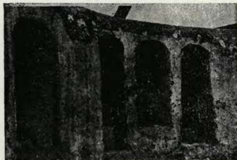
Sl. 125 Velenje, grad. Line s strelnicami in mašikuli v vrhnjem nadstropju bastije
