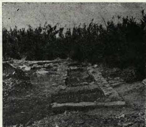
Sl. 41 Izola, Simonov zaliv — temelji rimske stavbe ob vzhodni obali
