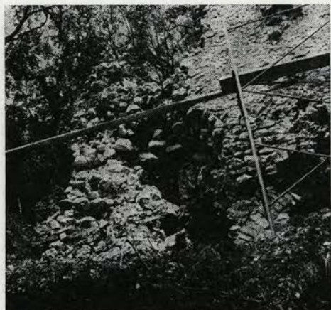
Sl. 14 Zahodna polovica južne stene — očiščena in pripravljena za dopolnjevanje
