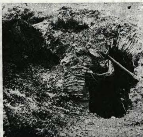
Sl. 19 Pročelna stran obokov v južnem podaljšku: stanje ohranjenosti
