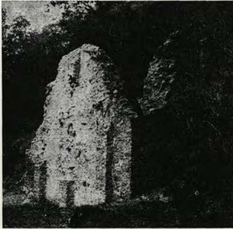
Sl. 16 Pogled na stolp od JV — po končanih delih
