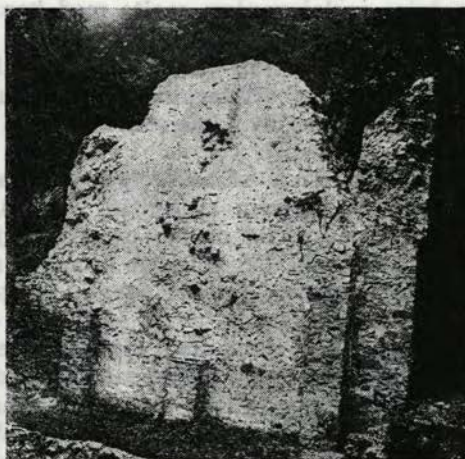
Sl. 15 Obnovljena južna stena po dokončanih odkopih
