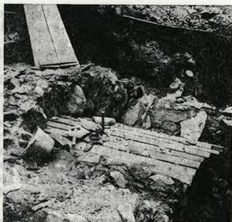
Sl. 23 Obnova svodnih lokov: oblika opažev in očiščeni robovi originalnega svoda
