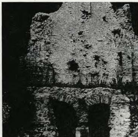
Sl. 12 Južno pročelje stolpa in obokov (stanje l. 1980)
