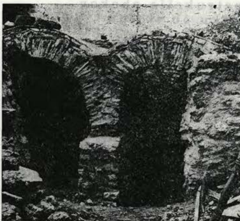
Sl. 22 (Pročelna stran obokov — po rekonstrukciji zunanje tretjine
