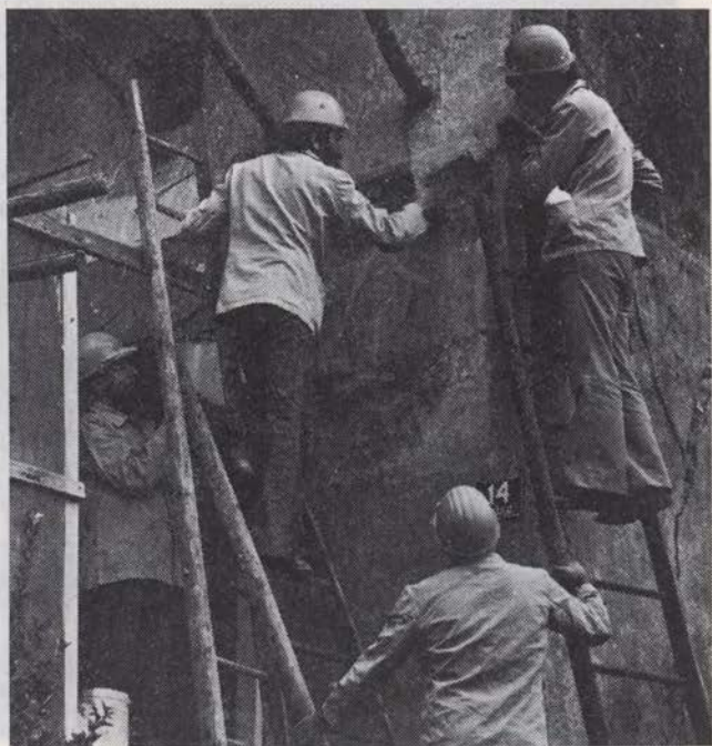
Sl. 5 Sedlo. Lepljenje začasnega nosilca (foto J. Gorjup) Fig. 5 Sedlo — gluing of the temporary support. (Photo: J. Gorjup)
