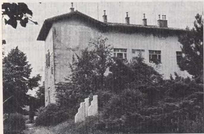
Sl. 5-7 Poslopje osnovne šole, ki stoji na temeljih nekdanjega srednjeveškega gradu v naselju Vogrsko; spodaj: razvaljen del gradu in tri ohranjene kamnite konzole
