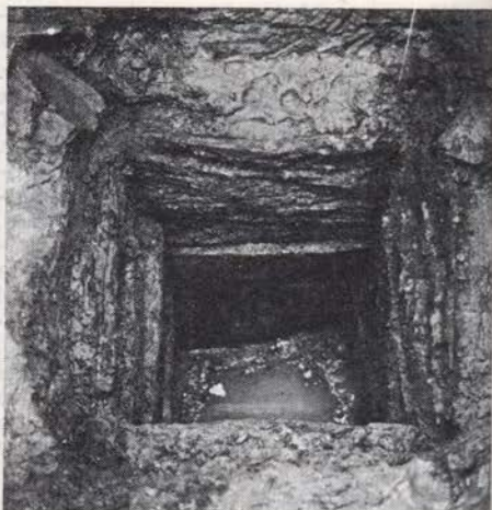
Sl. 50 Ptuj, Rabelčja vas — gradbišče bloka št. 3, kašta iz brun v vodnjaku št. 2 Fig. 50 Ptuj, Rabelčja vas. — Building-site of the block No. 3: the log-lining in the well No. 2
