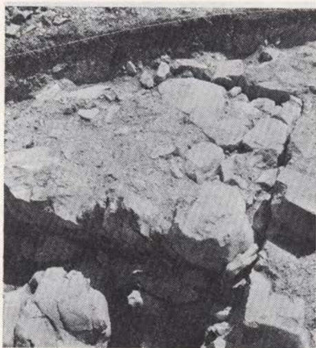
Sl. 12 Temelj opornika v južnem vogalu stolpa
