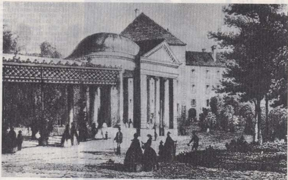
Sl. 5 Tempelj s secesijskim, že porušenim veznim hodnikom
