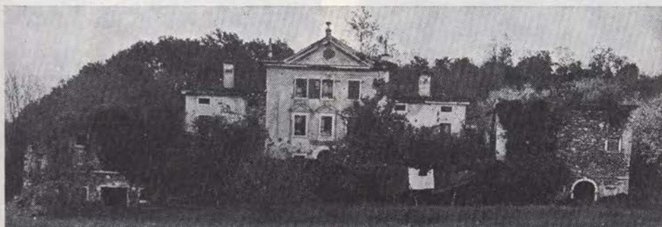
Sl. 11—12 Dvorec pred in med obnovitvenimi deli
