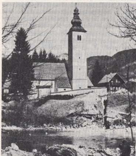
Sl. 177 Bohinj, izkop vodovodnega jarka pod podružno cerkvijo sv. Janeza
