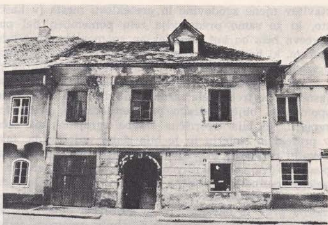
Sl. 19-20 Šivčeva hiša pred začetkom konservatorskih del; spodaj: prezentirana fasada maja 1975
