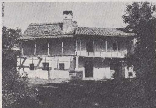
Sl. 12-13 Še ohranjena, a nenaseljena, torej na propad obsojena domačija v Koprivi (zraven hiše št. 30). Zgoraj: dimnik z nje in del še ohranjene kamnite kritine, ki prehaja v korčno
