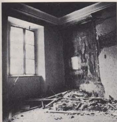
Sl. 14–15 Odkrivanje prvotnih lesenih opažev v zgornji veliki sobi, ki so bili skriti pod debelo plastjo ometa; del obnovljenega zgornjega prostora
