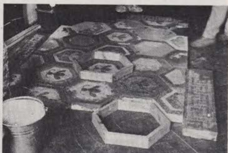
Sl. 5-6 Polaganje peščeno-umetnosmolne mase in poskusno sestavljanje nove kompozicije v delavnici; vidna lesena okvira — modela za obdelavo šesterokotnih elementov
