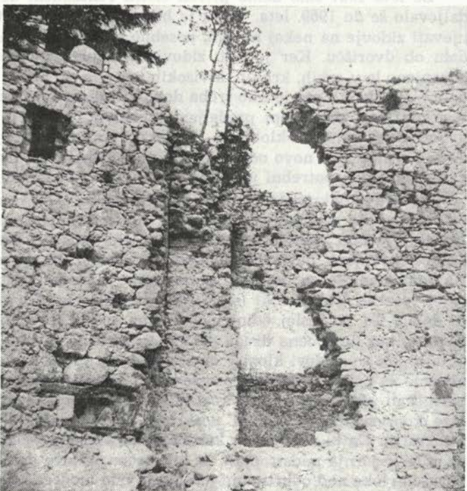
Sl. 11 Stik med 3. in 4. gradbeno fazo ob gornjem bastionu
