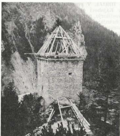
Sl. 17 Kamen pri Begunjah, postavljanje rekonstruiranega ostrešja na zahodnem stolpu Fig. 17 Kamen near Begunje, Erecting of the reconstructed roofing on the western tower
