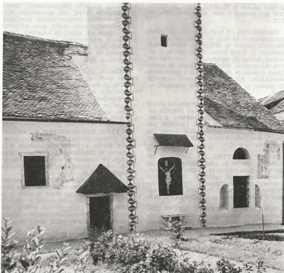
Sl. 29 Loka pri Zidanem mostu, obnovljena zunanjščina (foto R. Fonda) Fig. 29 Loka near Zidan most, The renewed exterior (Photo by R. Fonda)
