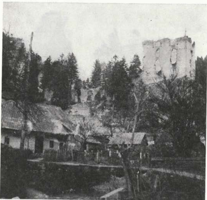
Sl. 5—6 Grad Kamen pred pričetkom del leta 1957 in pogled na grajski kompleks leta 1972
