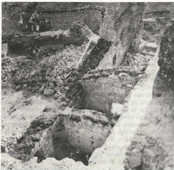
Sl. 12 Prostori v pritličju renesančnega dela — način utrjevanja zidov
