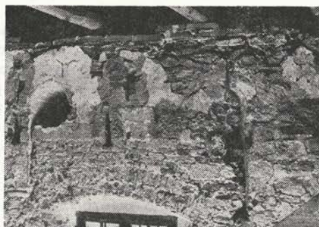
Sl. 4 Sledovi romanskih okenc v južni steni po odstranitvi »oboka« (foto M. Zadnikar) Fig. 4 The traces of the Romanesque small windows in the south wall after the removal of the »vault« (Photo by M. Zadnikar)
