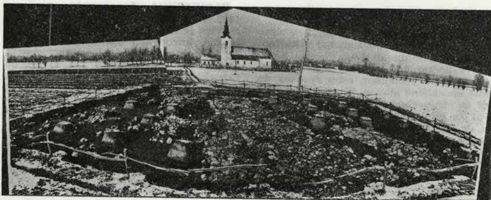
Sl. 162 Otok pri Dobravi, pogled na izkop. Osi tlakovane ceste in sedanjega kolovoza se popolnoma ujemata
