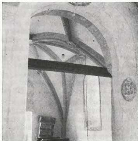
Del ladje pred obnovo in po rekonstrukciji rebrne mreže. — Foto P. Fister
