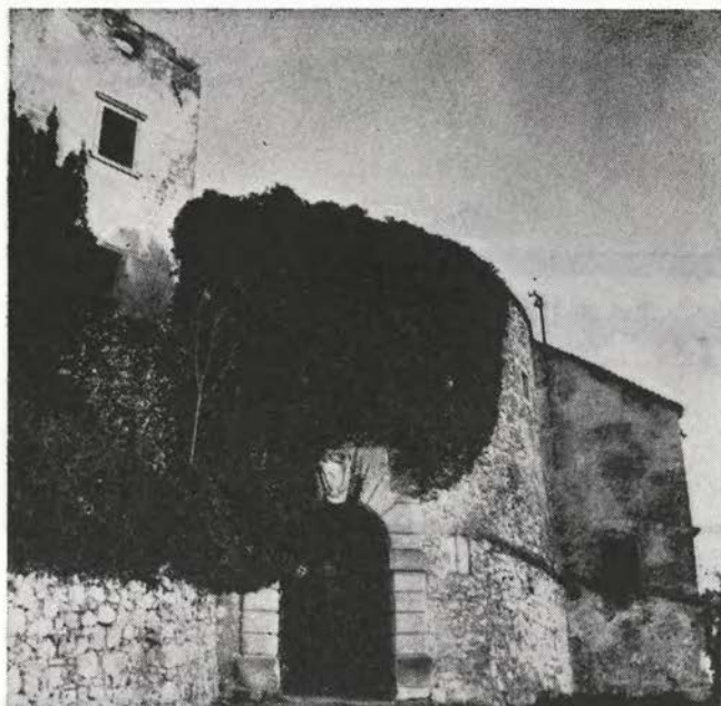
Palacij in portal v vhodnem stolpu. — Foto Nace Sumi
