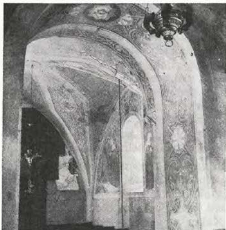
Del ladje pred obnovo in po rekonstrukciji rebrne mreže. — Foto P. Fister
