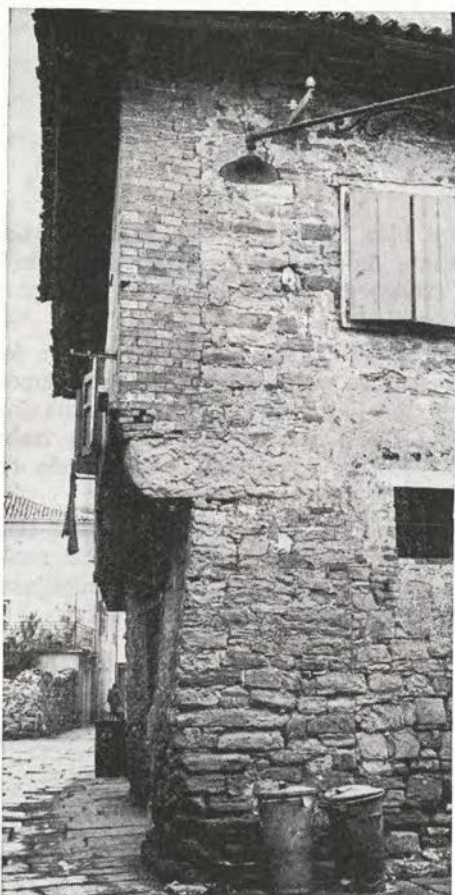
Levo: značilni poševni zid v pritličju in kamnita »vogalna« konzola; desno: nadstropje na barbakanih. — Foto Nace Sumi oz. J. Gorjup
