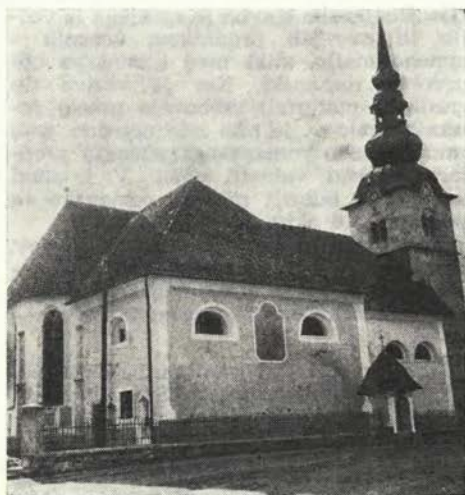
Kranjska gora, zunanost ž. c. Vnebovzvetja DM, obnovljena po rezultatih sondiranja
