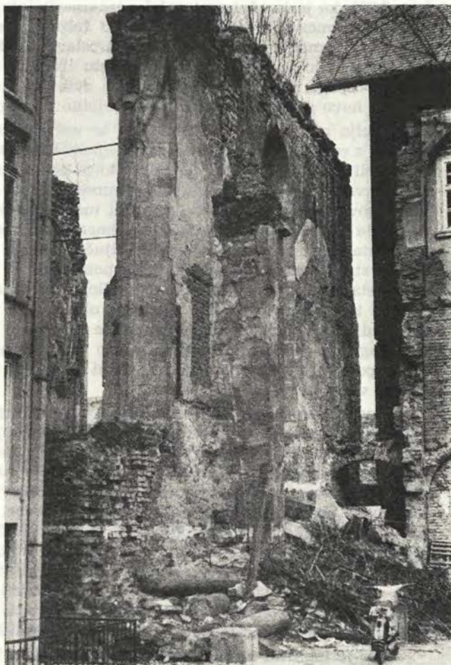
Stanje ruševin pred začetkom del, aprila 1969 (foto: M. Zadnikar)
