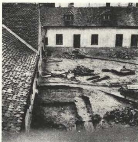
Begunje, izkopani temelji starejše arhitekture na grajskem dvorišču (foto: P. Fister)
