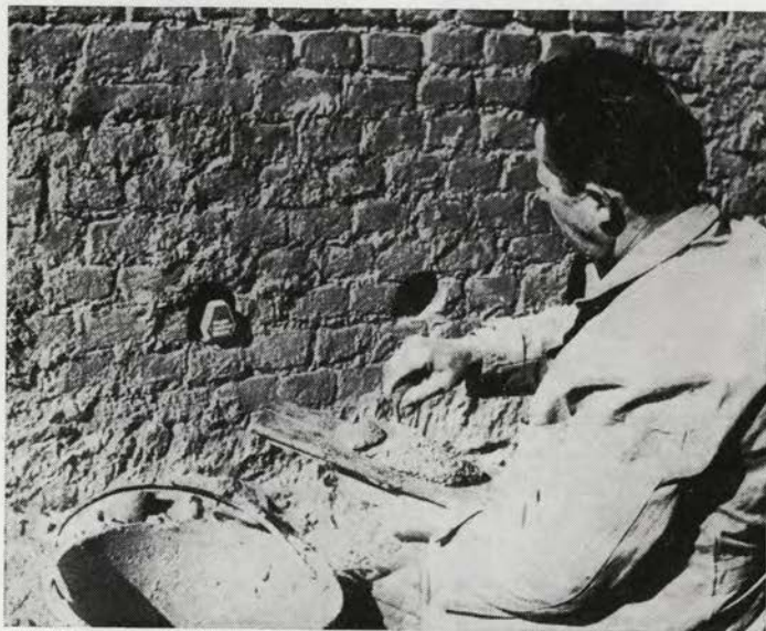
Skica 6. Vzidavanje elementov v zid
