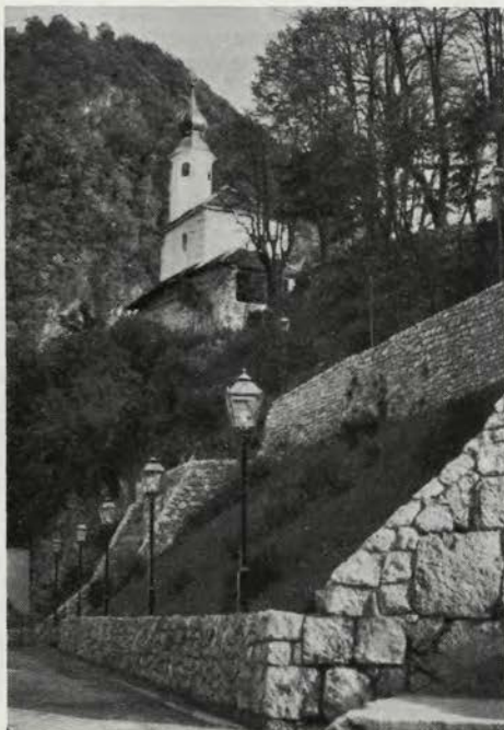
Kamnik, obnovljena zunanjsčina Malega gradu z urejenim podnožjem hriba. — Foto arh. B. Slegel
