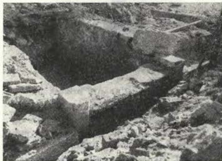
Ljubljana, obrežje Ljubljaničice, z opeko zazidana vrata neke poznosrednjeveške stavbe. — Foto M. Slabe Ljubljana, bord de la Ljubljaničice, porte murée avec briques d'une maison du Haut moyen-âge. — Photo M. Slabe
