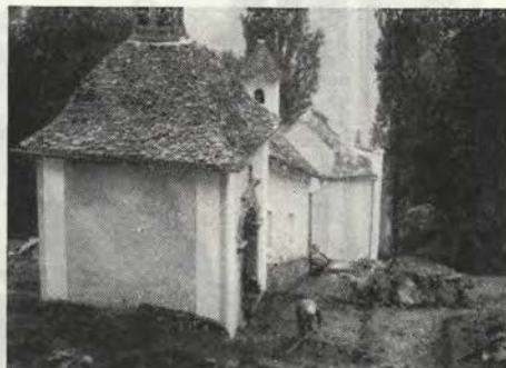
Šmarje pri Jelšah, drenaža kapelic Križevega pota. — Foto Berk Šmarje près de Jelše, drainage des chapelles du Chemin de la croix. — Photo Berk
