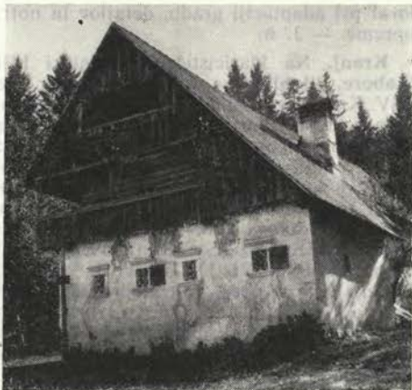
Hosta 1, ambiciozna, v osnovi gotska, v baroku prezidana in poslikana kmečka hiša. — Foto A. Bar-Janša 1964 Hosta 1, maison paysanne ambitieuse, fondement gothique, reconstruction et peintures baroques. — Photo A. Bar-Janša 1964
