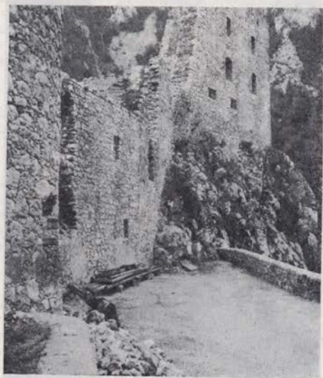
Kamen pri Begunjah — 1964 obnovljena prva grajska terasa
