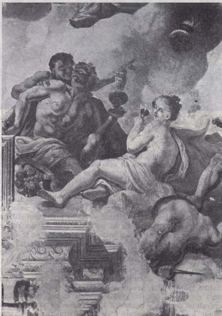
Strop stopnišča — poškodbe pred restavriranjem (foto J. Gorjup)
