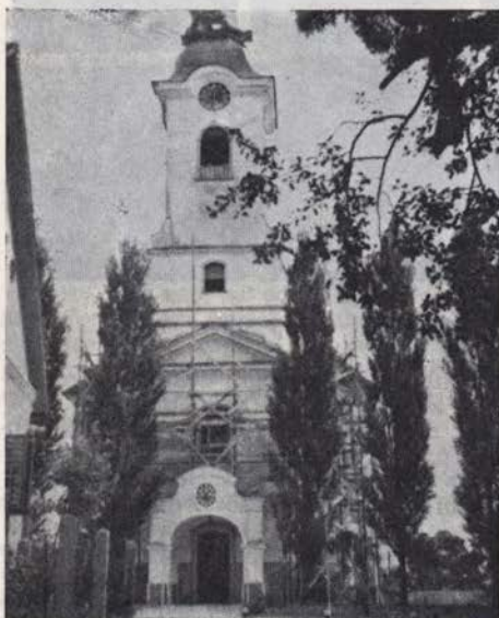
Cerklje, obnova fasade ž. c.
