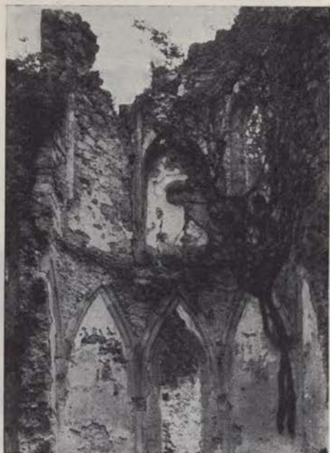
Notranjščina Otokarjeve kapele — vzhodni del pred obnovo (foto Berk, 1963)
