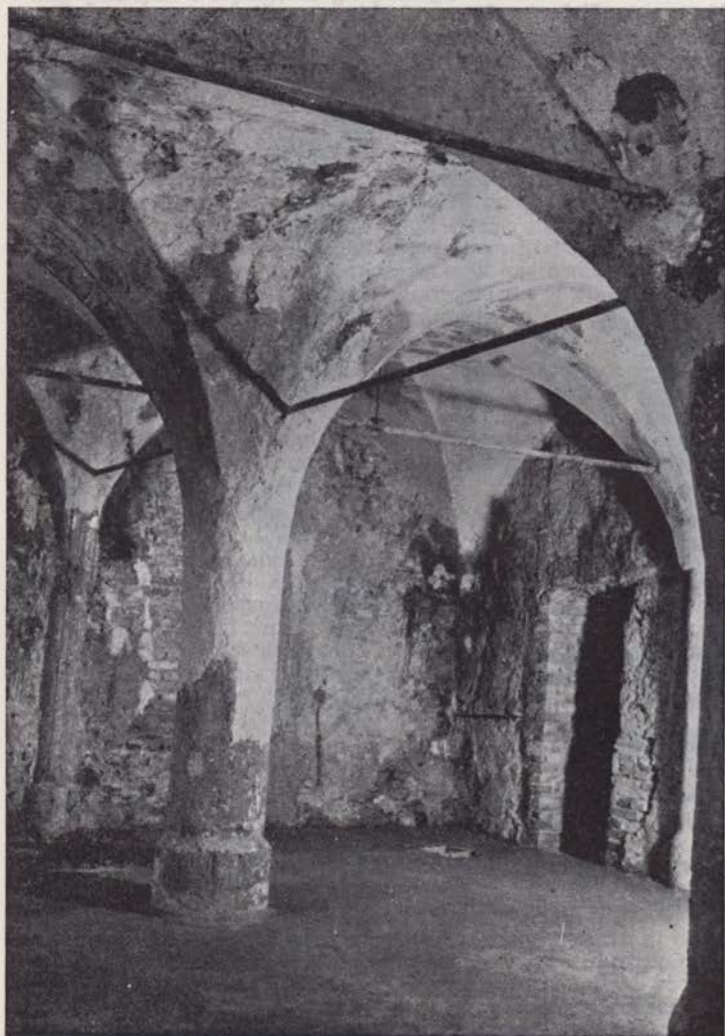
Stebriščna dvorana iz 1. pol. 16. stol. po odstranitvi poznejših zidov in vgraditvi železnih vezi
