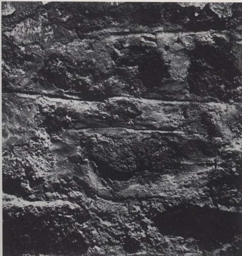
Vuzenica — zidava južne stene najstarejšega dela cerkve (foto: M. Zadnikar) Vuzenica — construction du mur méridional de la plus vieille partie de l'église
