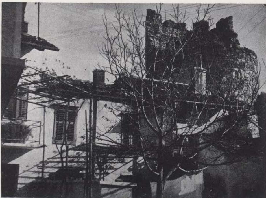
Ajdovščina — zahodna stran stolpa pred rekonstrukcijo (foto: P. Petru) Ajdovščina — côté ouest de la tour avant reconstruction
