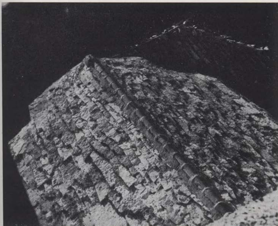
Hrastovlje — nova kamnita streha na cerkvi (foto: M. Zadnikar) Hrastovlje — nouveau toit de pierre de l'église
