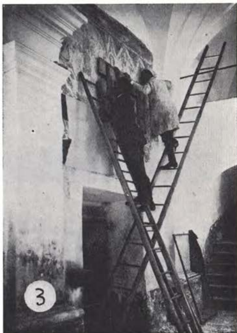
Vrzdenc — restavrator M. Sternen in konservator F. Stelè snemata fragmente mlajše plasti z zidu.
