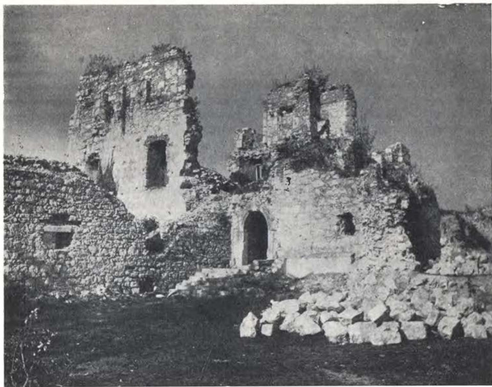
Pobrežje — ruševina gradu med očiščevalnimi deli leta 1959. (Foto I. Komelj) Pobrežje — ruines du château pendant les travaux de déblayage en 1959. (Cliché I. Komelj)
