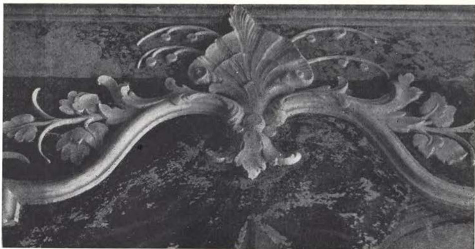
Goričane — del okvira med rekonstrukcijo. Razloček med originalom in novo štukaturo kažejo zlasti listi in zvončasti cvet. (Foto M. Zeleznik)
