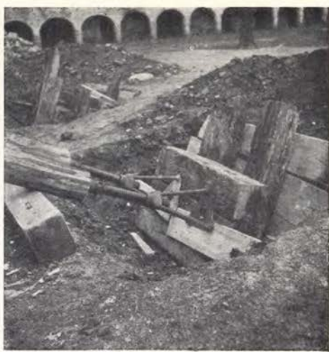
Kostanjevica na Krki — podstavek lesenih opiračev konstrukcije za izravnavanje fasade arkadnega hodnika ob južni strani cerkve. (Foto M. Čanak)
