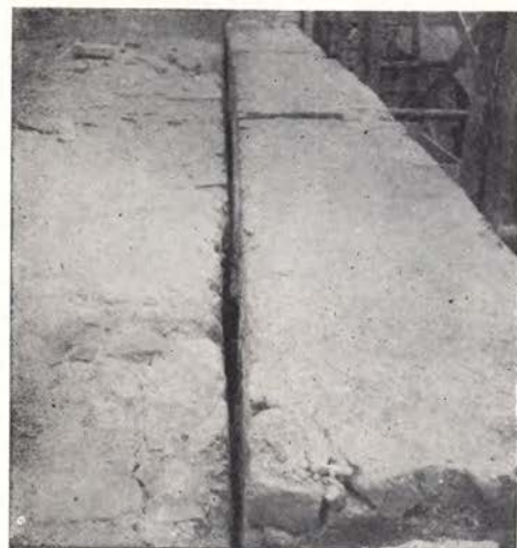
Kostanjevica na Krki — fasadna stena arkadnega hodnika ob južni strani cerkve pred poravnavo. (Foto. M. Čanak)
