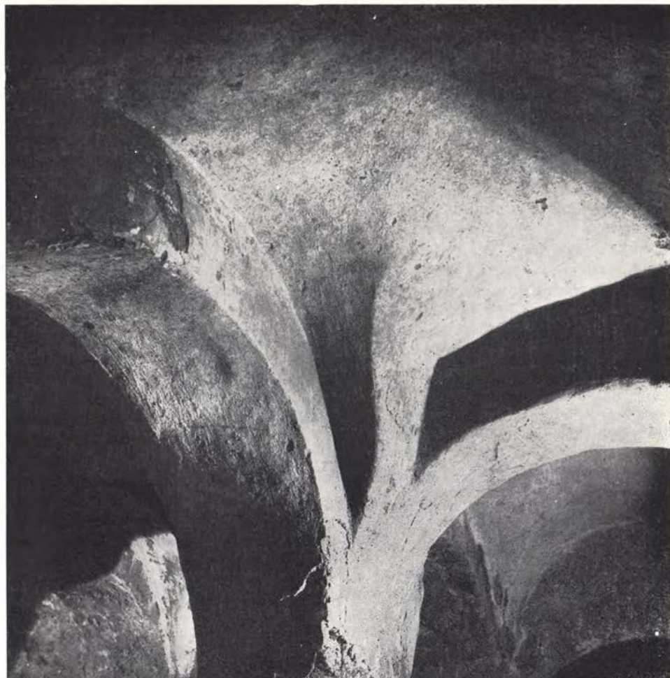
Hoče — obočne konstrukcije v drugem prostoru. — (Foto M. Zadnikar) Hoče — constructions voûtées dans le second espace. (Cliché M. Zadnikar)
