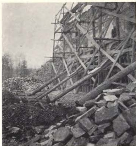
Kostanjevica na Krki — lesena konstrukcija za izravnavanje fasade arkadnega hodnika ob južni strani cerkve. (Foto M. Čanak)
