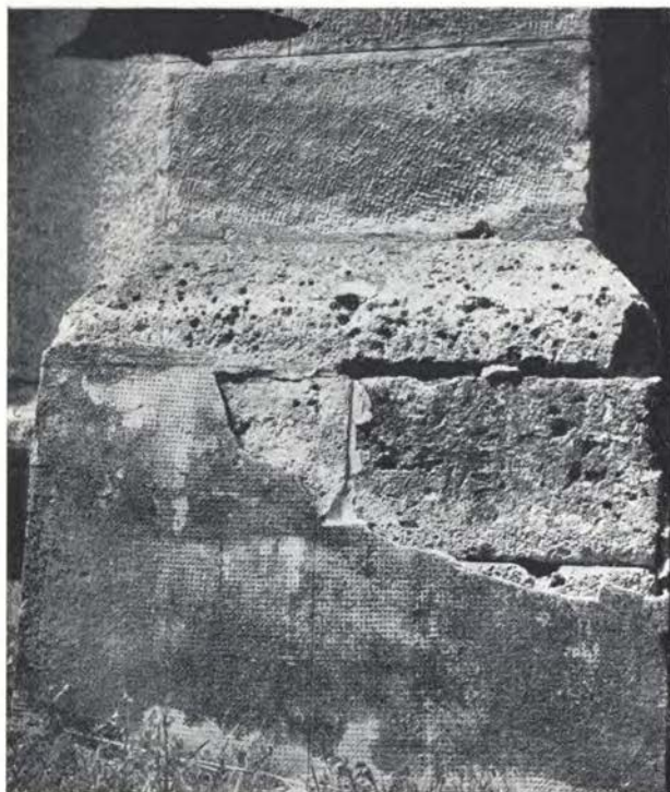
Ptujska gora — cementna obloga odstopa od kamnitega podstavka opornikov. (Foto M. Zadnikar)
