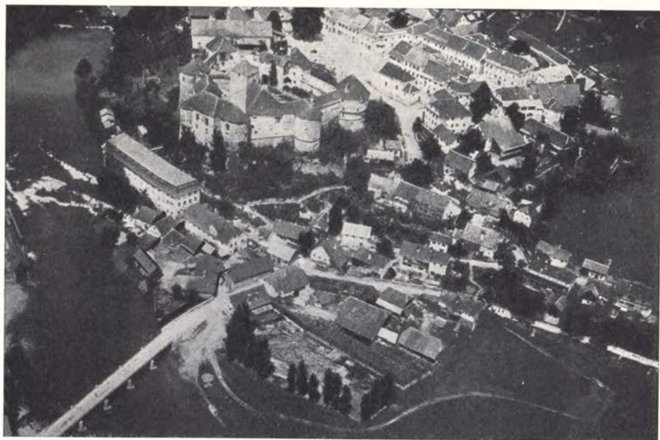
Žužemberk — pogled na trg z gradom okrog leta 1930. (Po posnetku iz zraka) Žužemberk — vue sur le bourg avec le château vers 1930. (D'après une photo prise d'avion)
