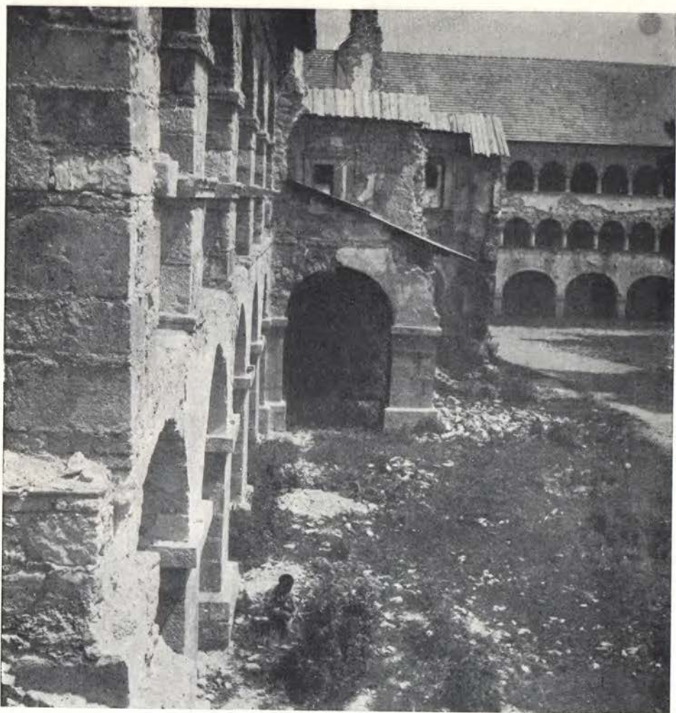
Kostanjevica na Krki — fasada arkadnega hodnika ob južni strani cerkve po poravnavi in rekonstrukciji zgornjega dela. (Foto M. Čanak)
