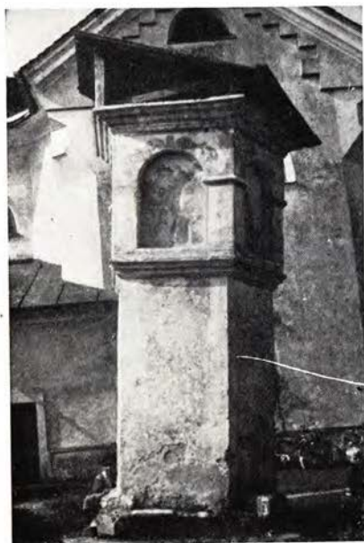
Visoko pri Kranju — predstavitev zidanega poslikanega znamenja: 1. Znamenje brez strehe v strogem občestnem pasu, 2., 3. Premikanje podzidanega znamenja na lesenih valjih, 4. Znamenje je predstavljeno in pokrito z novo streho. (Foto B. Sajovic)
