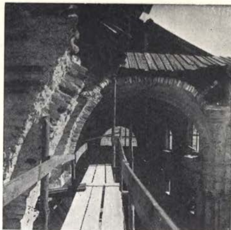
Kostanjevica na Krki — ostanki baročnih obokov v glavni ladji. (Foto M. Čanak)
