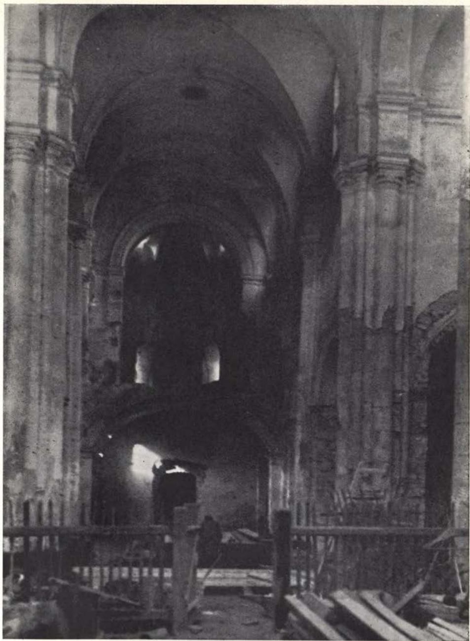
Kostanjevica na Krki — notranjščina cerkve s pogledom proti zahodu pred restavracijo leta 1929. Pevski kor, ki obsega eno travejo, še stoji. (Foto F. Stelè)
