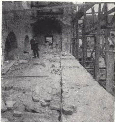
Kostanjevica na Krki — fasadna stena arkadnega hodnika ob južni strani cerkve po poravnavi. (Foto M. Čanak)
