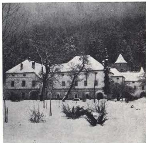
Bistra — pogled na celoto po rekonstrukciji stolpa. (Foto M. Vidmar)
