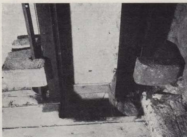
Babna gora — dvigalna naprava v bunkerju. (Foto: M. Vidmar)
