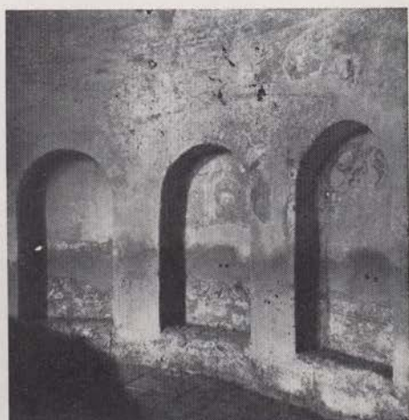
Selo v Prekmurju — odprte stenske niše in obravnava sten po restavraciji. (Foto: M. Zadnikar)
