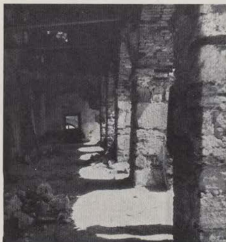
Kostanjevica na Krki — nagnjeni arkadni slopi ob hodniku na južni strani nekdanje samostanske cerkve. (Foto: I. Komelj)
