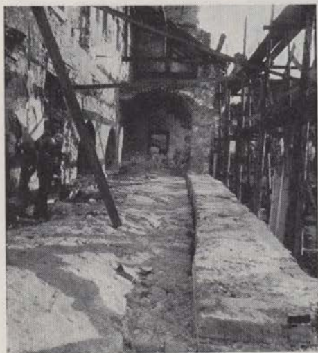
Kostanjevica na Krki — izbočena stena ob hodniku na južni strani cerkve. (Foto: I. Komelj)
