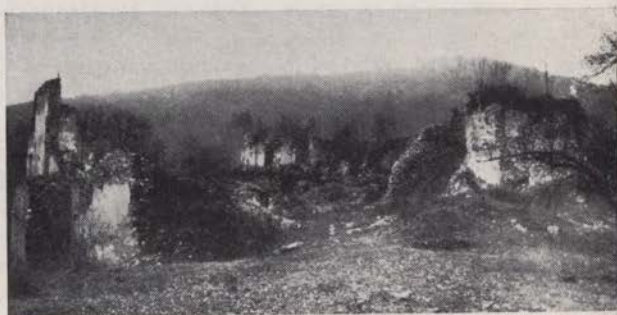
Klevevž — grad, stanje leta 1955. (Foto: I. Komelj)
