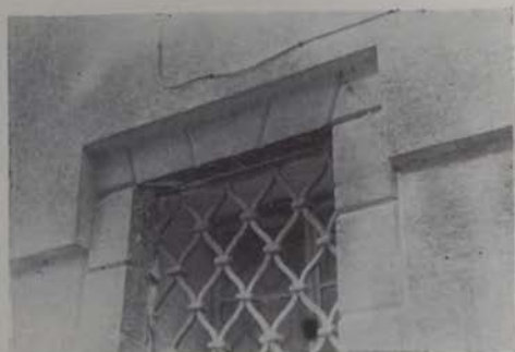
Baročno okno je utonilo v debelem sloju fasadnega ometa, ki mu je na zgornjem delu zmalčilo arhitekturno značilnost; pa tudi omet sam je spomeniško varstveno nesprejemljiv, ker je podan v sodobni tehniki tako imenovanega umetnega ometa (terra nuova). (S pročelja Zoisovega dvorca v Ljubljani, obnovljenega leta 1938)
