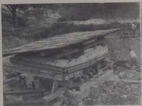
Sl. 3. Temelj z zaščitno streho v času podzidavanja
