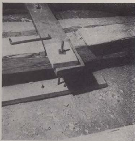
Sl. 27. — Brežice, grad, utrjevanje poveznikov, na katere je obešen strop
