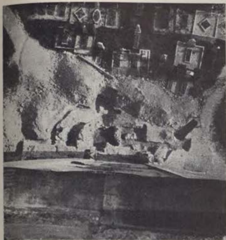
Stara Loka — pogled iz zvonika na izkopane temelje gotske in v njej romanske južne apsida stare cerkve (Foto Zadnikar)
