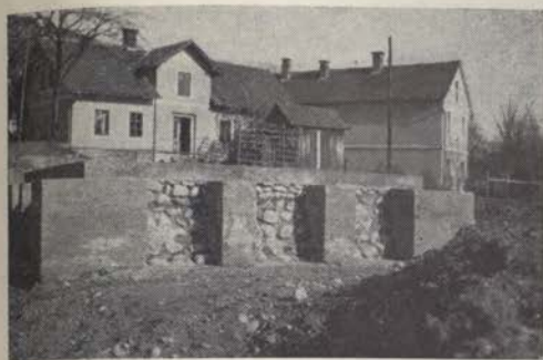
Sl. 5. Rekonstruiran in učvrščen temelj leta 1954
