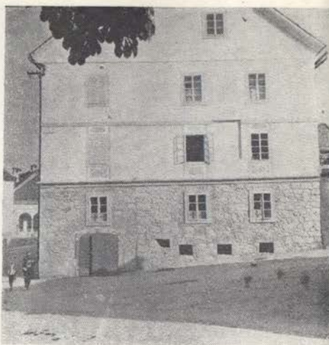
Sl. 16. Pogled na pročelje novo odkritega bastiona s kasnejšo dozidavo
