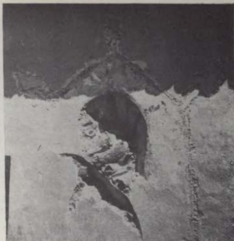
Dovže v Mislinjski dolini — odkrito staro okno s štukiranim okvirom (Foto Zadnikar)
