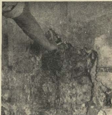
Restavrator v drugi fazi s štrcalom vbrizgava kazein emulzijo pod fresko omet. (Foto Velepič)
