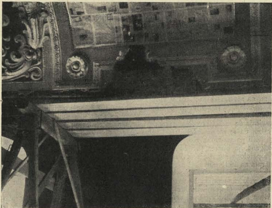
Maribor, grad. »Viteška dvorana«: prelepljena freska Poletje. Skozi luknjo viden podrti del dimnika, ki je bil napaden po hišni gobi. (Foto Cizelj)
