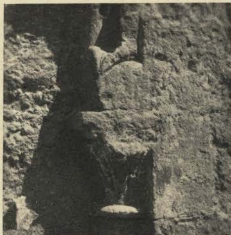
Ptuj — minoriti. Kapitel k severni steni ladje prislonejenega stebra nekdanjega baldahina, ki je prekrival oltar, za katerim so se ohranili odlomki fresk z glavo Kristusa. Nad kapitelom je viden del žlebičasto profiliranega loka z odtokom žleba, ki je značilen motiv prehodnega sloga. (Foto l. 1950 — Zadnikar)
