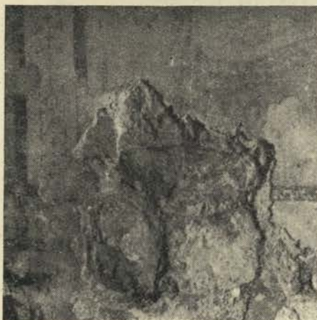
Bolna od vlage uničena mesta na freskah je bilo treba do zdrave osnove, kamna, temeljito očistiti. (Foto Velepič)
