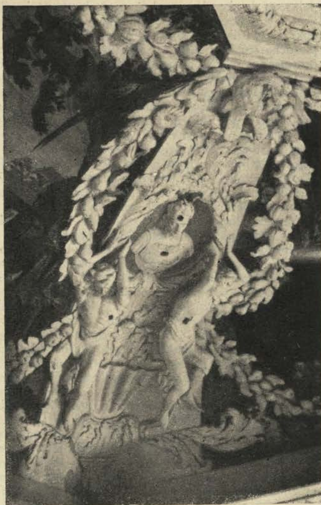
Grad Statenberg. Odstopajoči stuk ornament in plastiko je bilo treba dvigniti in pritrditi na osnovni omet. Na glavah in prsah so vidne glavice vijakov s ploščicami
