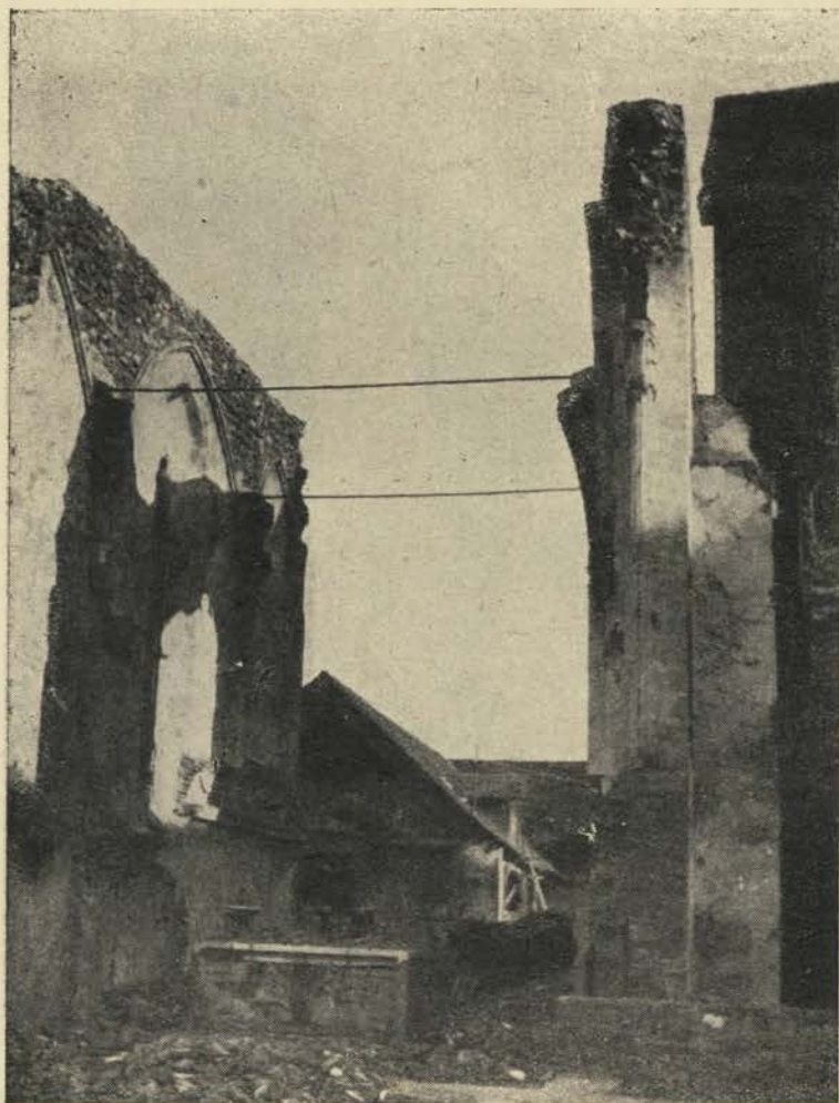
Ptuj — minoriti. Obe steni prezbiterija sta bili med seboj povezani z železnimi vezmi in baročna pregrada odstranjena. (Foto dec. 1950 — Zadnikar)
