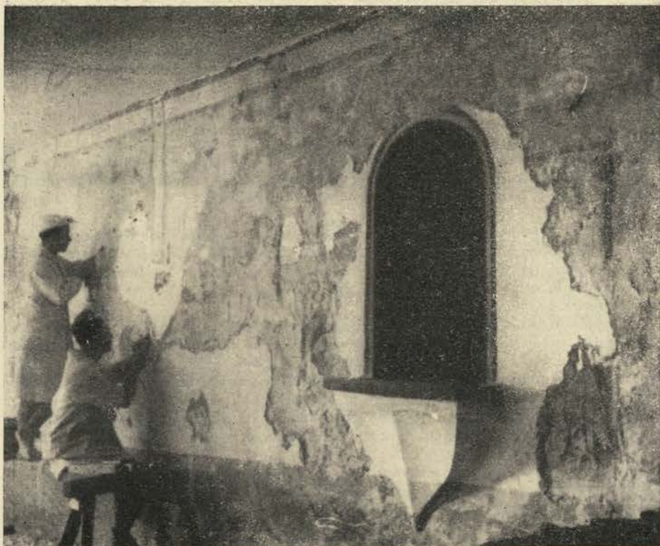
Zanigrad v Slov. Istri. Restavratorja previdno odstranjujeta novejši omet na levi severni steni ladje. Skoraj do polovice višine stene je vlaga uničila fresko, poleg tega je novejša miša poškodovala največjo figuralno kompozicijo Pohod kraljev in prizor rojstva. (Foto Velepič)
