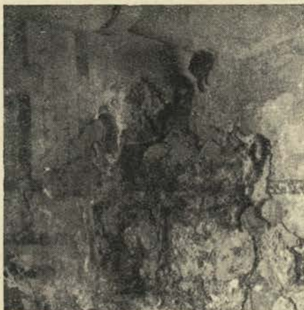
V tretji fazi se z ometom, kateremu je pri-mešana kazein emulzija, podprejo robovi fresko ometa. (Foto Velepič)
