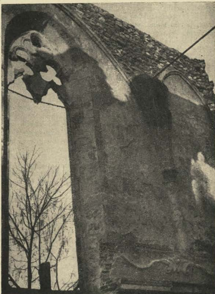
Ptuj — minoriti. Odprto gotsko okno v severni steni se je razodelo v lepem trilistnem krogo- vičju in stena je znova zaživela. (Foto dec. 1950 — Zadnikar)
