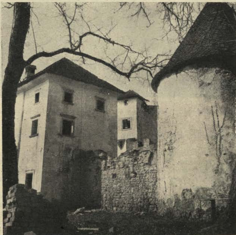
Grad od severovzhoda. Na pomolu je delno ohranjena slikarija iz 16. stoletja. Obzidje med obema stolpoma je prvotno segalo vse do strešnega slemena. Na sliki vidimo zobčasti nastavek na opečnih konzolah, kar je rezultat »restavracije« 19. stoletja. (Foto Komelj)
