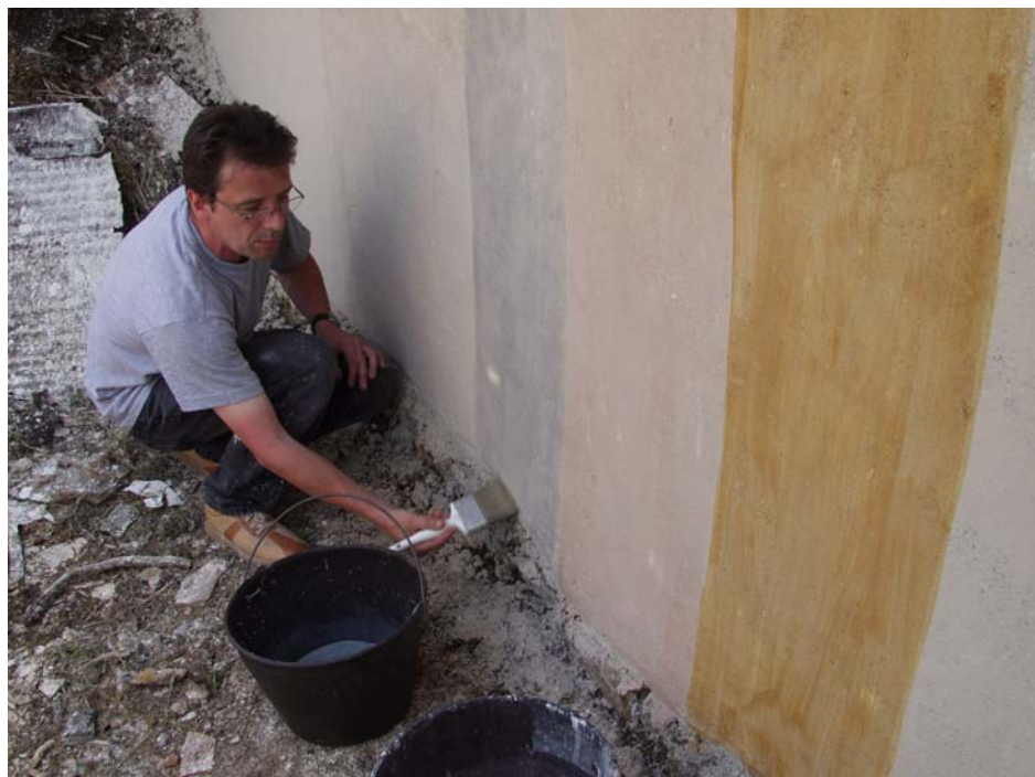
Dediščina slikopleskarstva, demonstracija pleskanja v fresko tehniki, delavnica Apno in apnene tehnologije, Prapreče pri Lukovici, 2003
