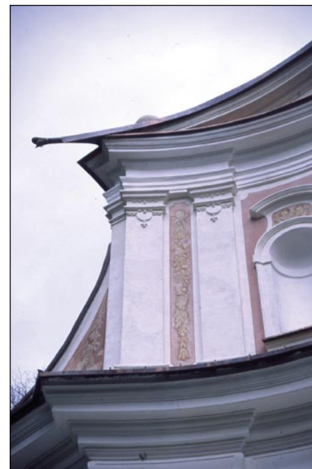
Ohranjen stari štuko omet, dopolnjen z novim na pilastrih baročne kulise fasade v Kostanjevici na Krki
