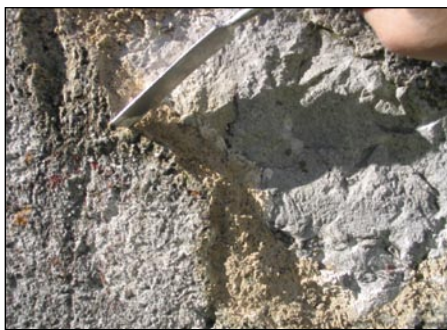
Obšivanje prvotnega ometa, Štanjel
