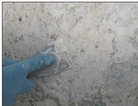
Vtiskovanje apnene mase v površinske razpoke ometa
