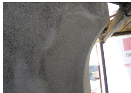
Primer izenačene površine starega in novega ometa, Škofja Loka
