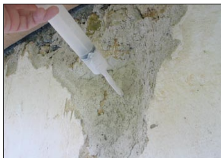
Primeri injektiranja zaplate ometa, Prapreče pri Lukovici (zgoraj) in Prišece (spodaj)
