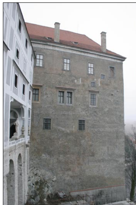
Češki Krumlov, konserviran gotski omet na zahodni fasadi gradu
