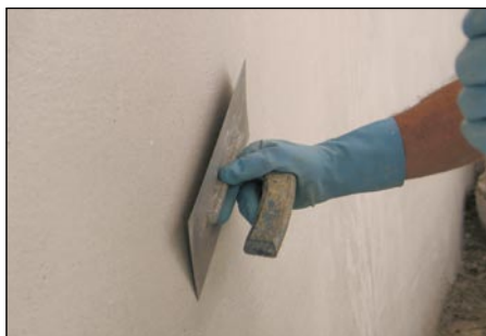
Fasada Paplerjeve hiše v Škofji Loki (zgoraj) in detajl izvedbe glajenega apnenega ometa (spodaj)
