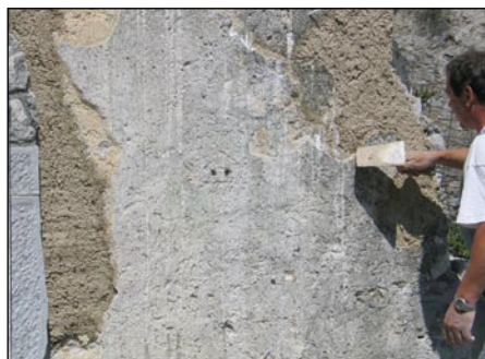
Pripravljeni vzorci ometa (zgoraj) in zapolnjevanje praznih mest, Štanjel (spodaj)
