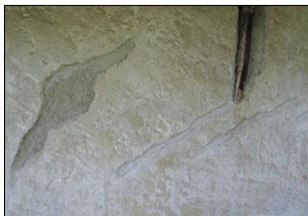
Grad v Pišecah (zgoraj) in detajl dopolnjevanja baročnega ometa na vzhodni fasadi (spodaj)
